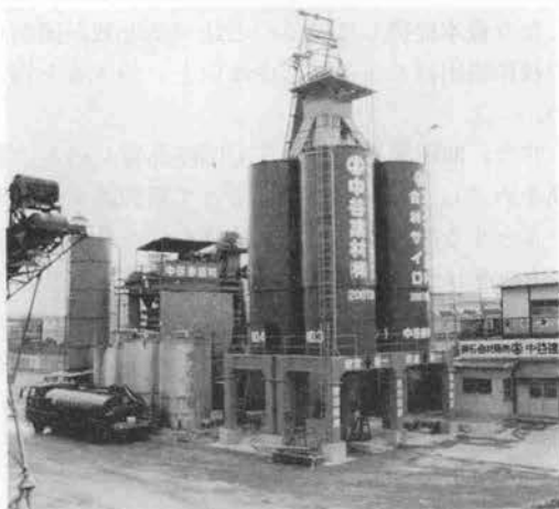
写真—1 合材サイロ4基を装備した合販プラント
