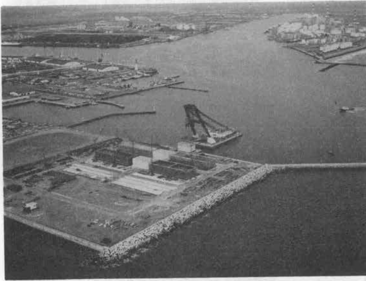
写真-1 ケーソンの全貌
