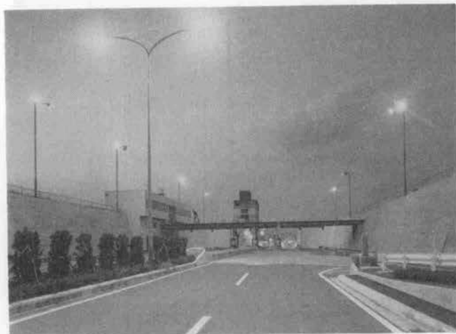
写真—1 東扇島料金所側よりトンネルを望む
