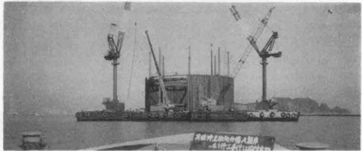
写真-2 組立基地における矢板建込状況
