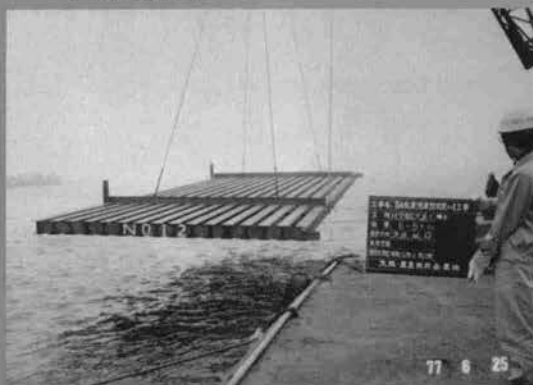
⇨ケソン曳航 ⇩沈床工据付
