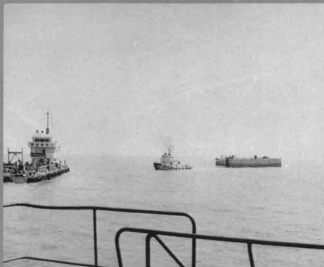
⇨ケソン曳航 ⇩沈床工据付
