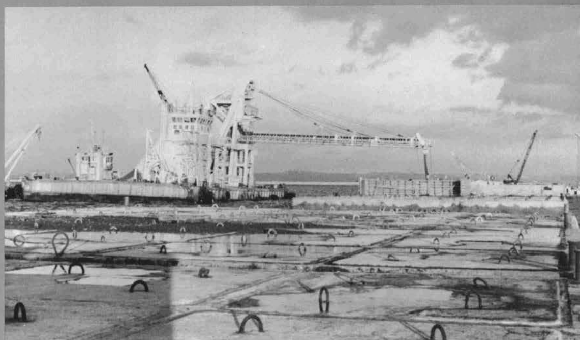
上部打設 作業基地防波堤工事
