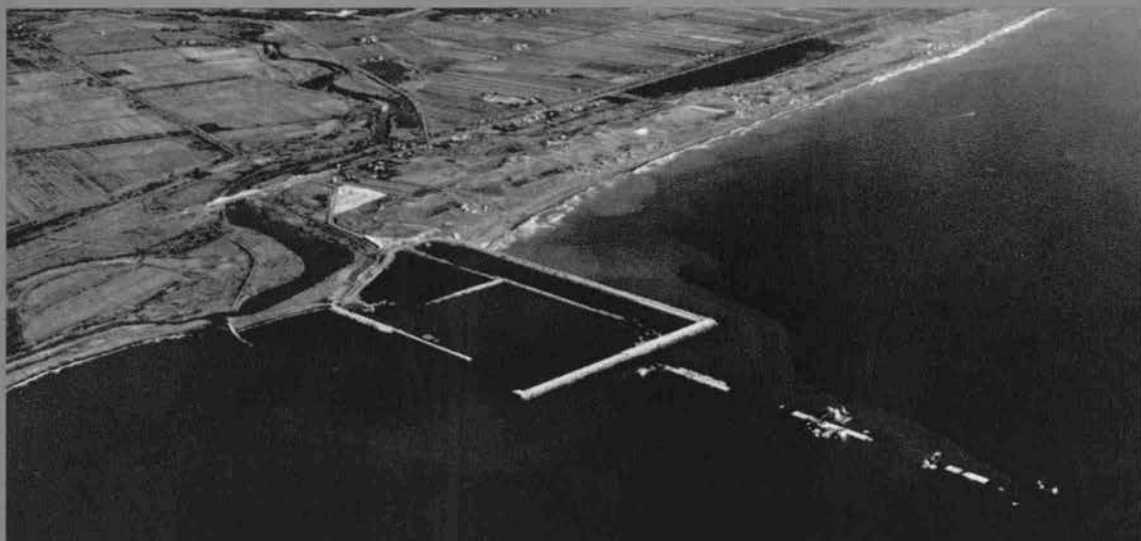
◆東防波堤着工（昭和52年）
