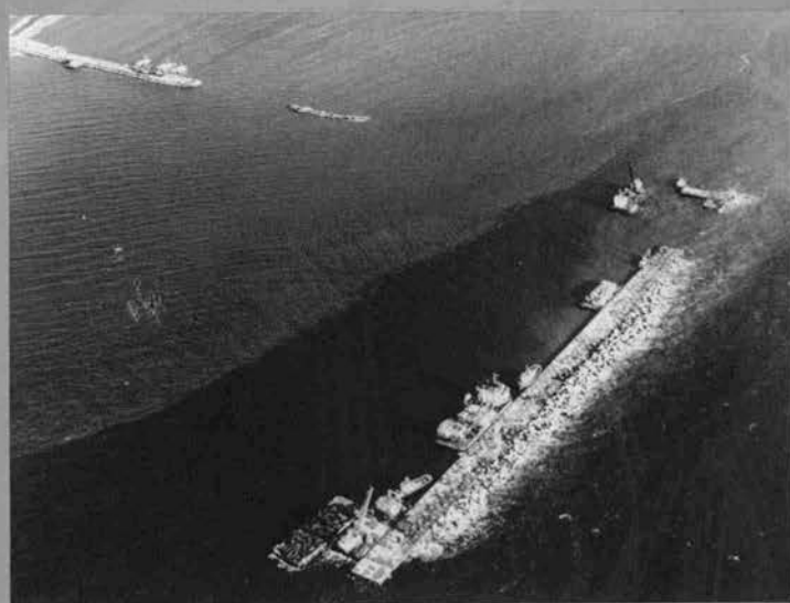
上部打設 作業基地防波堤工事
