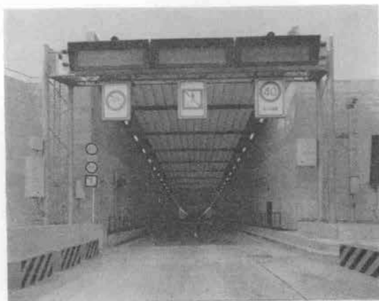
写真-3 東扇島側入口可変情報板
