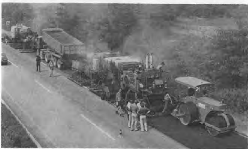
写真-2 イタリアにおける現位置再生工法の施工例 (1979年)。左前方よりプレヒータ (Wirtgen 社製)、ダンプトラック、リミキサ (Wirtgen 社製, 施工幅 4.2 m)、マカダムローラ
