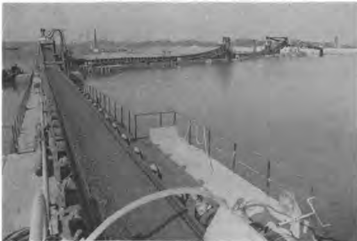
写真-1 フローティングコンベヤおよびフローティングスプレッド
