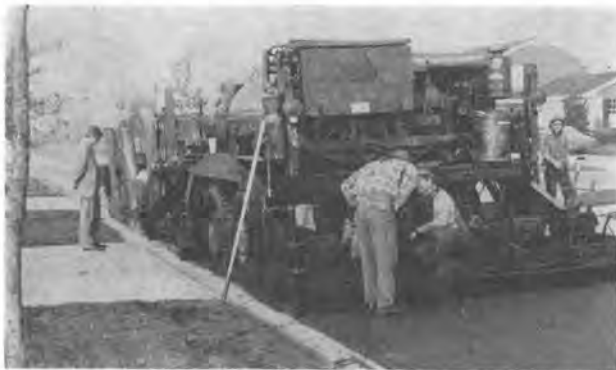
写真-1 シカゴ郊外における現位置再生工法の施工例 (1975年) (リペーバ: Cutler 社製, 施工幅 3.6 m)
