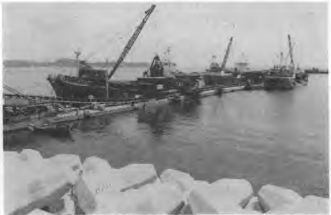
写真-2 揚土コンベヤ
