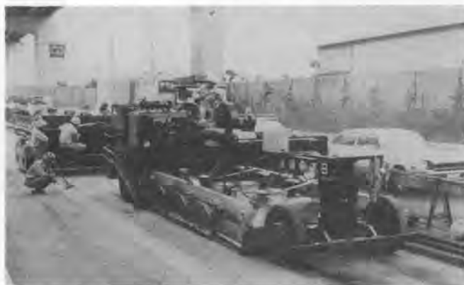
写真一3 ヒータスカリファイヤ (日本舗道製, 施工幅 2.4 m)
