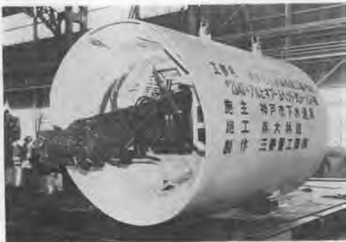
写真-4 φ2,640 アルビネブームヘッド式シールド
