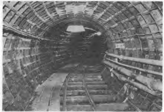
写真-1 急曲線部のトンネル
