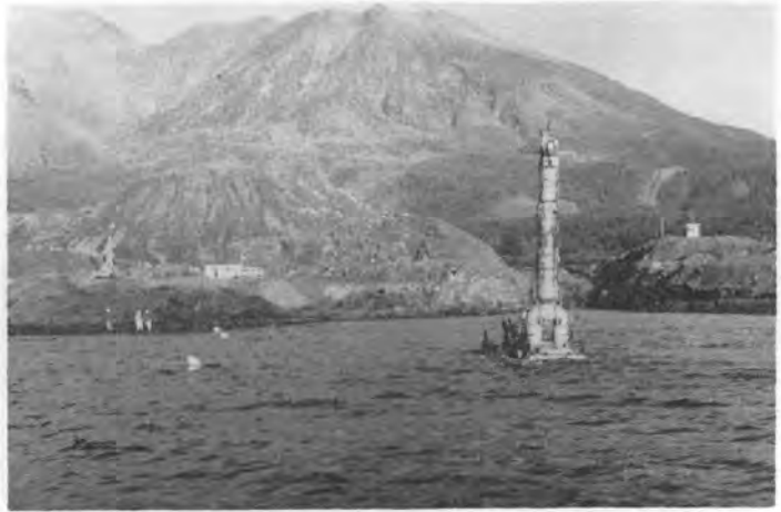
写真-6 水陸両用ブルドーザによる水中掘削
