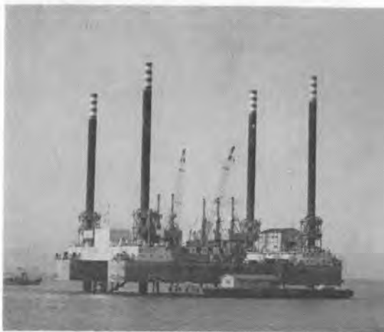
写真-4 7A でせん孔作業中の「たまの」（6 台のウエルマンせん孔機を搭載している。手前の船は 700 t の火工所台船）
