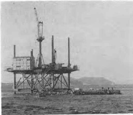
写真-2 4 A の汀線部でせん孔作業中の「躍進」 (OD せん孔機が3台搭載されている)
