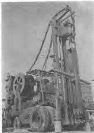
写真-5 連続地中遮水壁用施工機 (OBW 工法)
