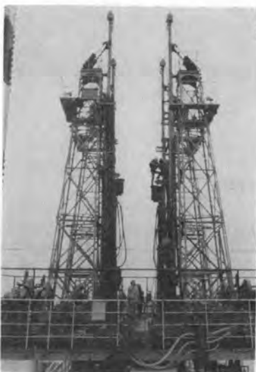
写真-5 「盤石」上でせん孔作業中の 4 台の OD せん孔機
