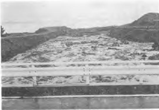
写真-2 土石流発生による泥流
