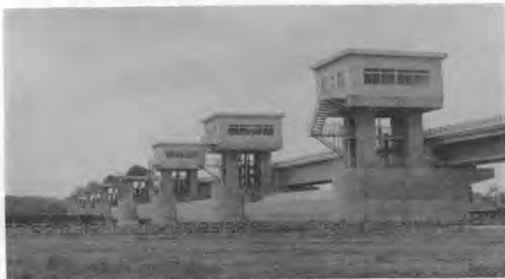
写真-1 第3ブロックまで完了真近かな大堰
