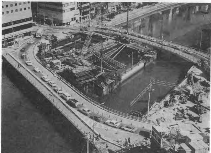
写真-2 那珂川中央分割部の着 工状況
