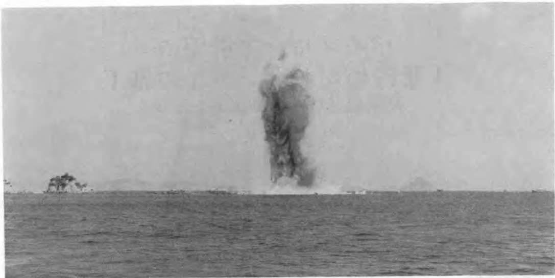
写真-8 4 A の発破（水際部分の発破で、せん孔本数 54 本、薬量 2,160 kg、水柱約 100 m）
