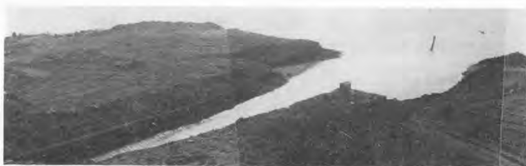
写真-4 水陸両用ブルドーザによる河口部掘削
