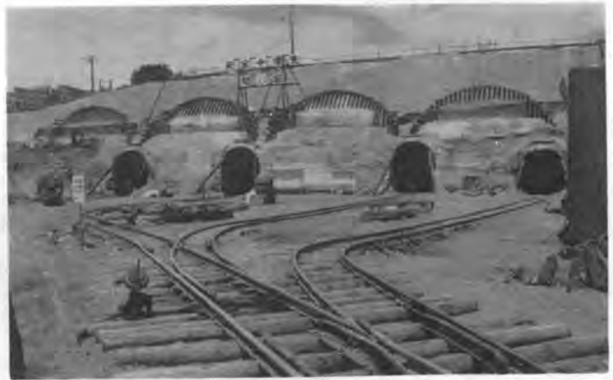
写真-2 導坑掘削
