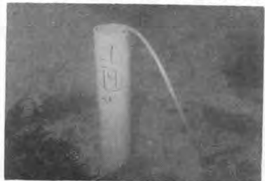
写真-6 装填された海底の導爆線（塩ビ管の端部で損傷を受けないよう導爆線には細いビニールホースを通してある）
