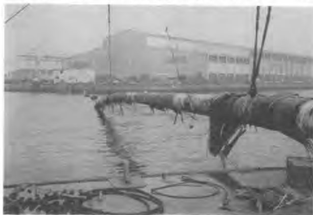
写真-2 送泥管の海底埋設工事
