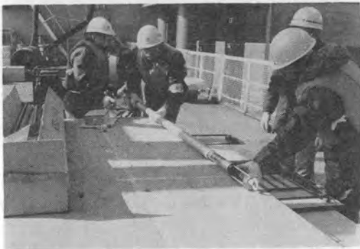
写真-9 カートリッジの作製（せん孔長に合わせて 1 本ごとに調整、組立が行われる。先端部は超音波起爆素子）
