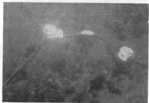
写真-7 接続金具で結線された海底の導爆線（幹線となる海底の導爆線は念のためダブル配線としている。接続金具によって複雑な結線も容易にできる）
