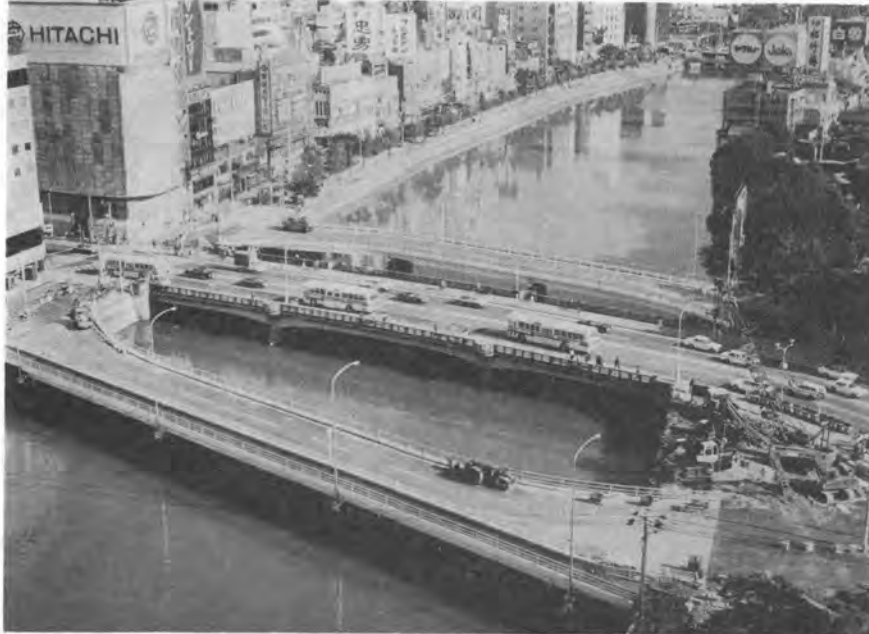
写真-1 着工直前の那珂川付近 （上下流の仮橋に交通 を切替え，現橋（西大 橋）を撤去する）
