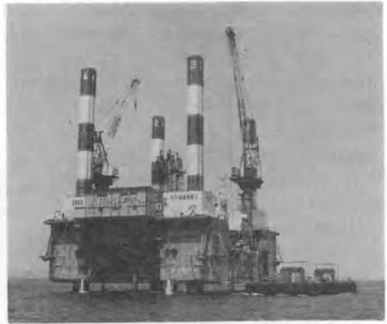
写真-3 5 P でせん孔作業中の「盤石」(右側の台船は500t台船で、火工所と乗降棧橋を兼ねている。「盤石」には4台のODせん孔機が搭載されている)
