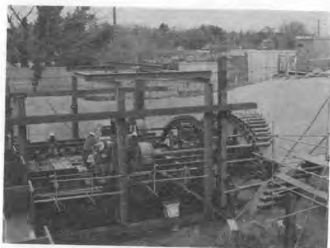
写真-1 鋼管圧入状況
