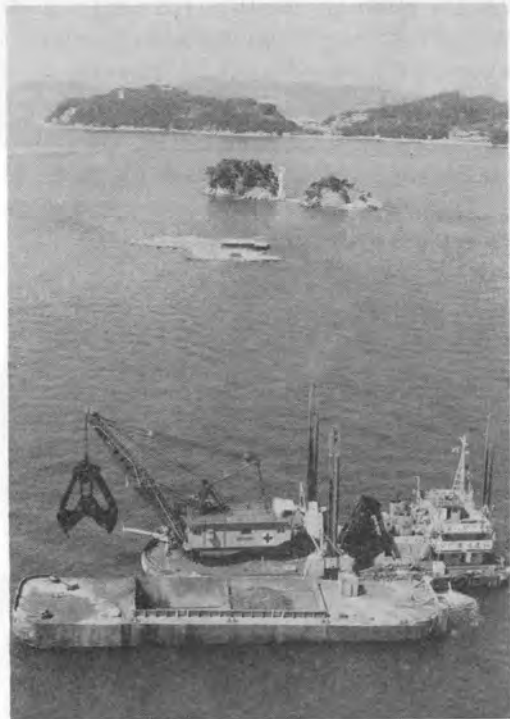
写真-11 5 P 地点で掘削中のグラブ船（中央の平地は 4 A 地点で、TP+2 m に掘削されている。灯台の見える島は三ツ子島で、3 P 基礎が向う側になる）
