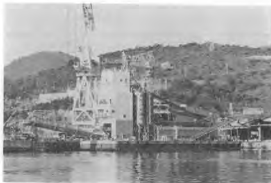
写真-14 IHI コンクリートプラント船「第十八豊号」
