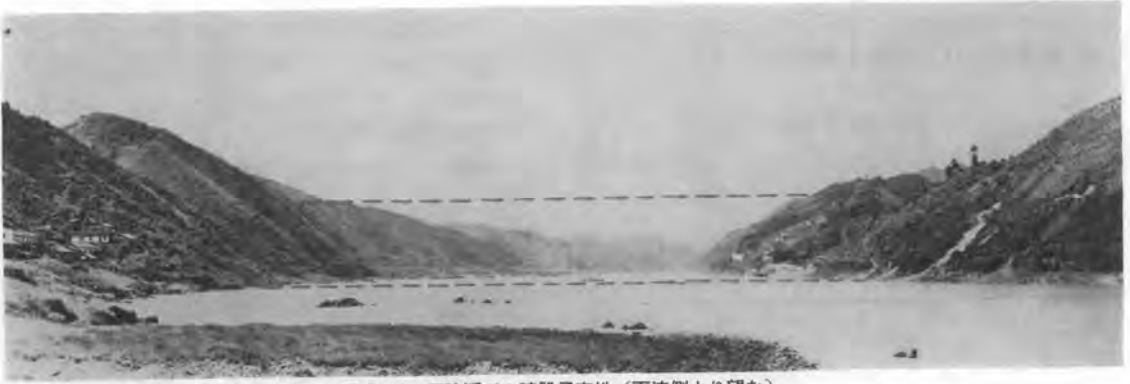
写真-1 五強ダム建設予定地（下流側より望む）
