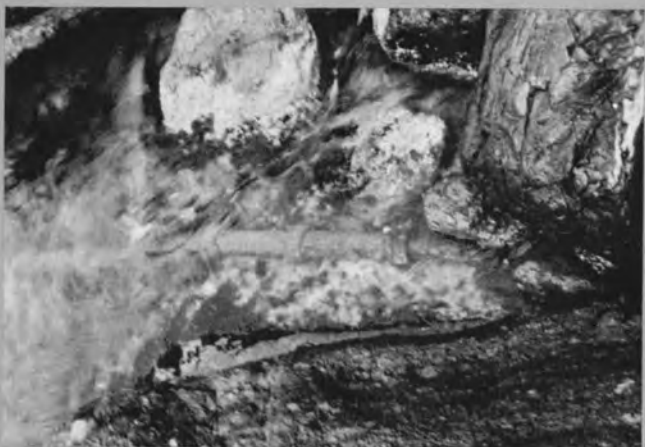
⇨ 白山島から海中へのケーブル敷設
