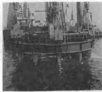
写真-4 打込完了
