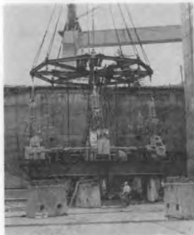
写真-2 組立中の振動装置
