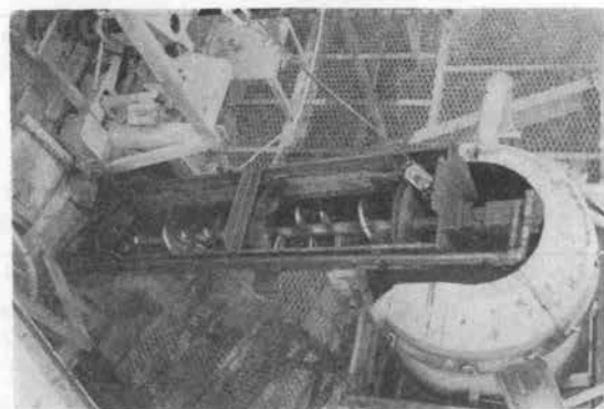
写真-1 連続ミキサの一例(生コンクリートホッパ付)
