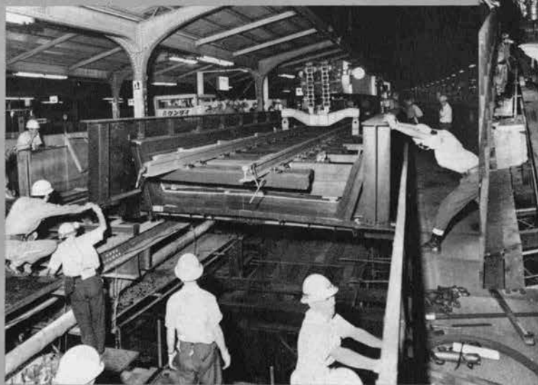
⇨ 軌道桁の架設作業
