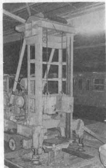
写真-4 杭打機による作業
