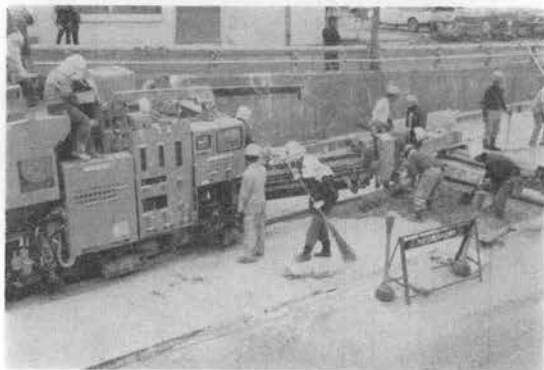
写真—4 連続ミキサを用いた舗装版オーバーレイの施工例
