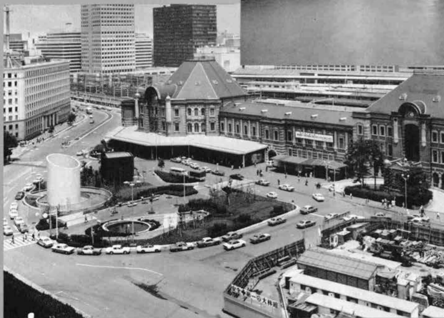
◇丸の内側駅前広場と工事用資材置場
