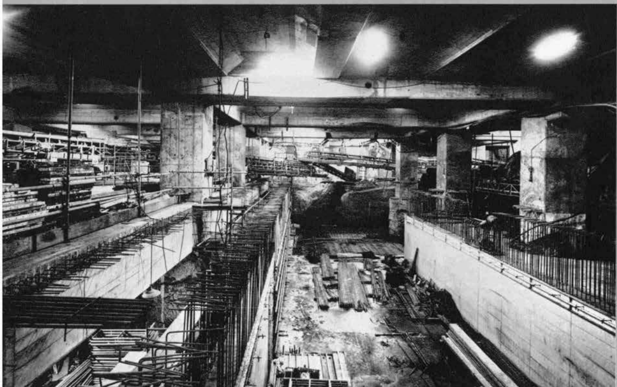
◇中央通路地下2階部分(導道)躯体構築状況
