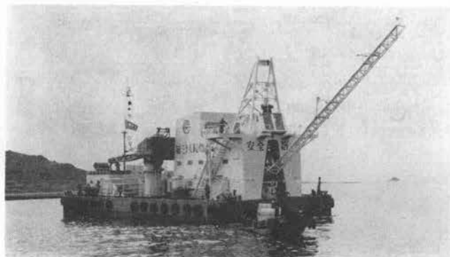
写真—2 連続ミキサを設置したコンクリートミキサ船
