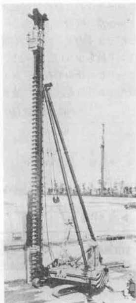
写真-9 → 神戸製鋼 100P バイルドライバ
