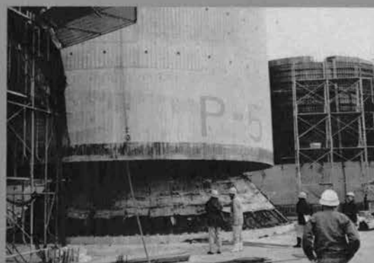
◆ ケーソンつり上げ中
