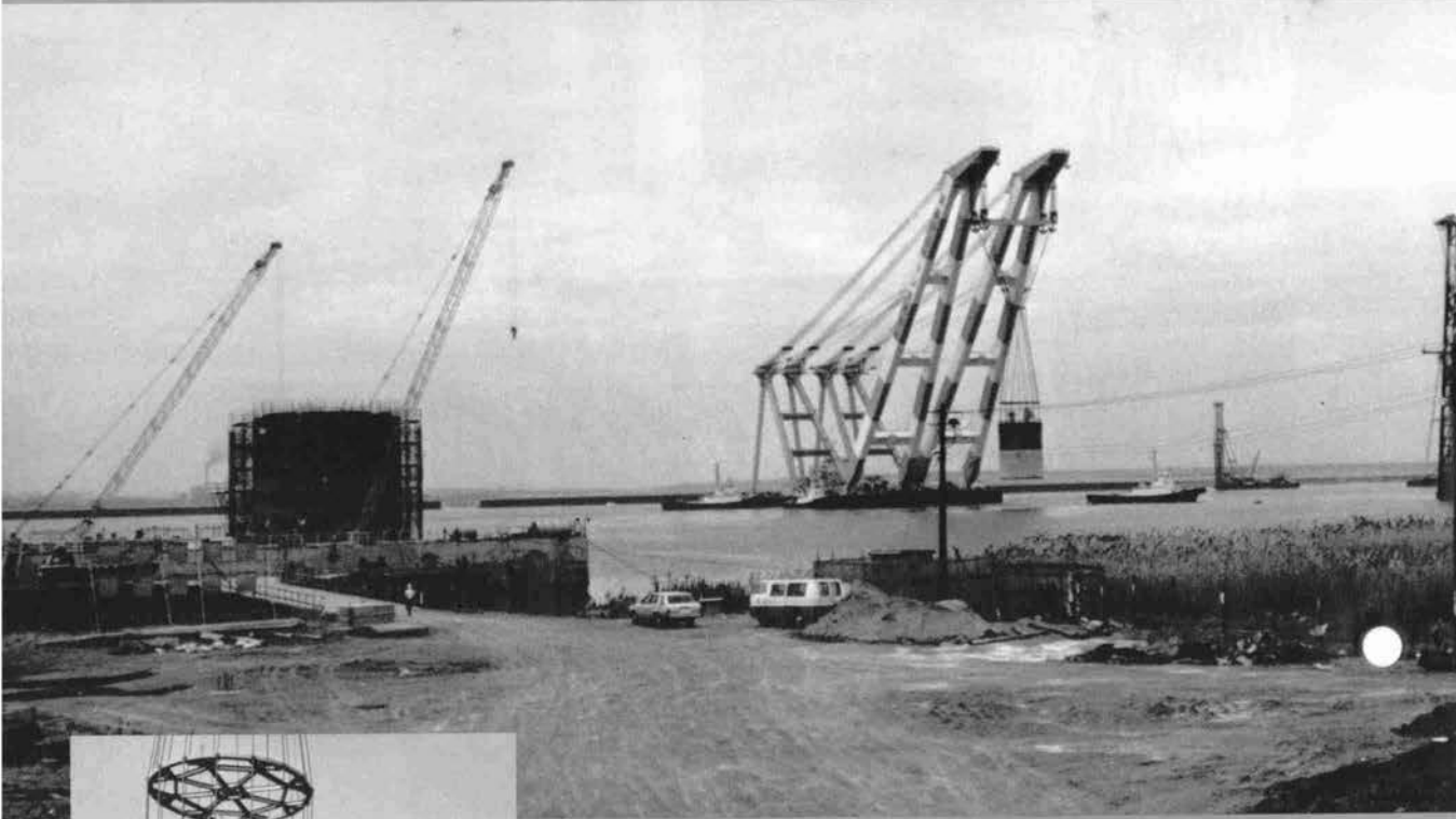
♪ 台船を離れたケーソン ♪ 設置場所へ向うケーソン
