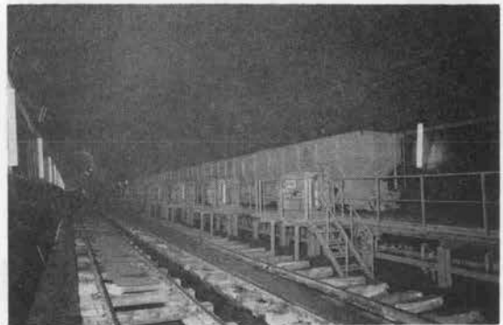
写真—4 鋼車底部のゲート開閉用ユニット
