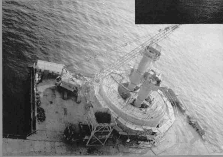
♪ 設置場所へつり下し中のケーソン ♪ 沈下掘削状況
