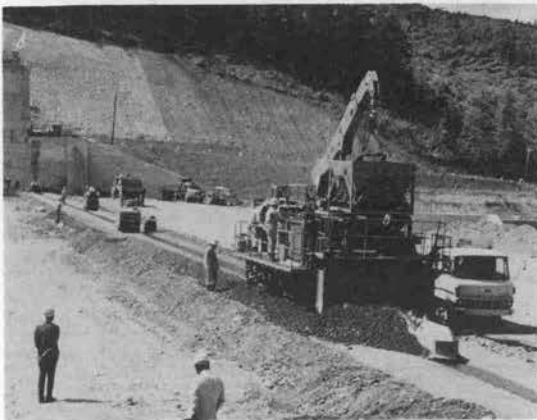
写真-1 アスファルトコアフィニッシャ
