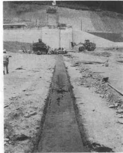
写真-2 グラベルマスチック流し込み後の状況
