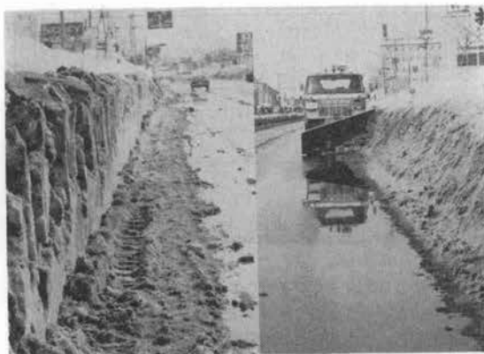
(施工後) (施工前) 写真-10 雪堤成形装置による除雪状況
