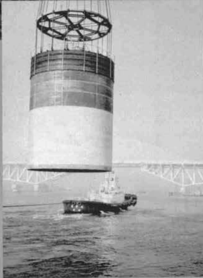
♪ 台船を離れたケーソン ♪ 設置場所へ向うケーソン
