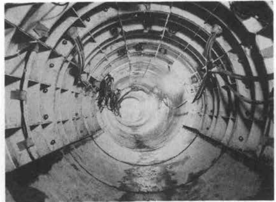
写真-1 ライニング完成
