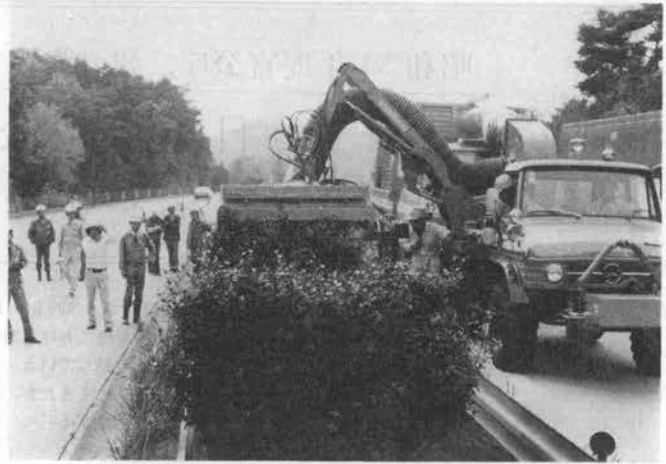
写真-2 樹木せん定機によるせん定作業
