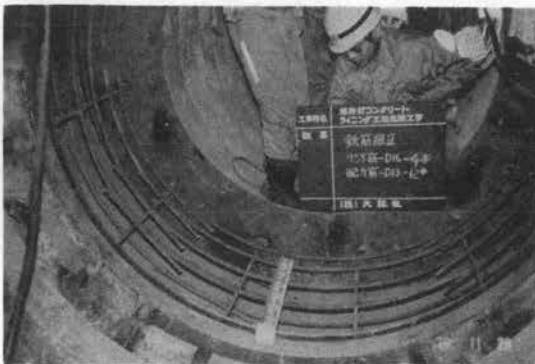
写真-2 鉄筋配筋状況
