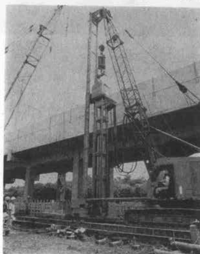
写真-7 振動遮断用地下壁打設装置
