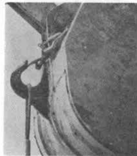
写真-1 バックホウに溶接された安全フック
