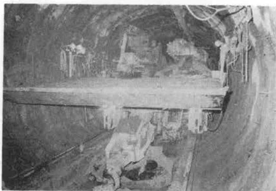
写真一九 ミニベンチ掘削装置
