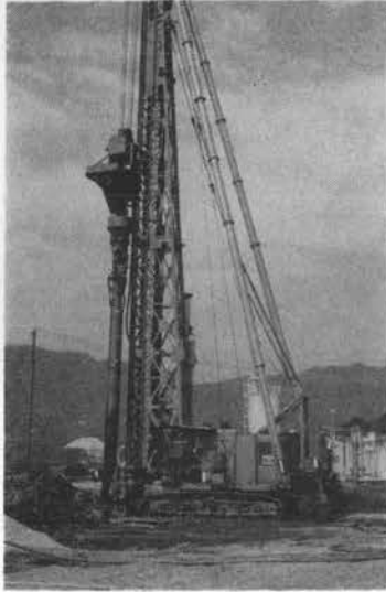
写真-14 低騒音・低振動砂杭打設装置
