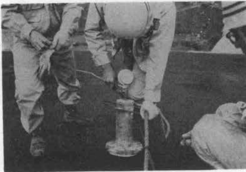
写真-3 真空試験状況
