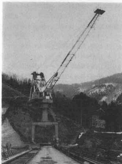
写真-25 台車を連結した高脚走行式ジブクレーン
