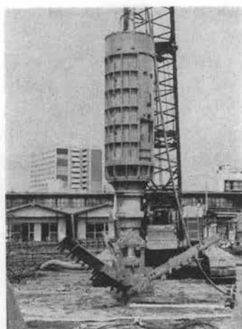
写真-9 リバース掘削機 TT 0811 型機本体
