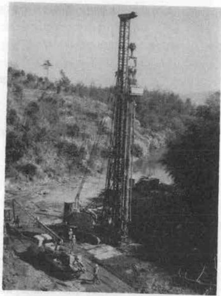
写真-15 電動式深層混合処理装置
