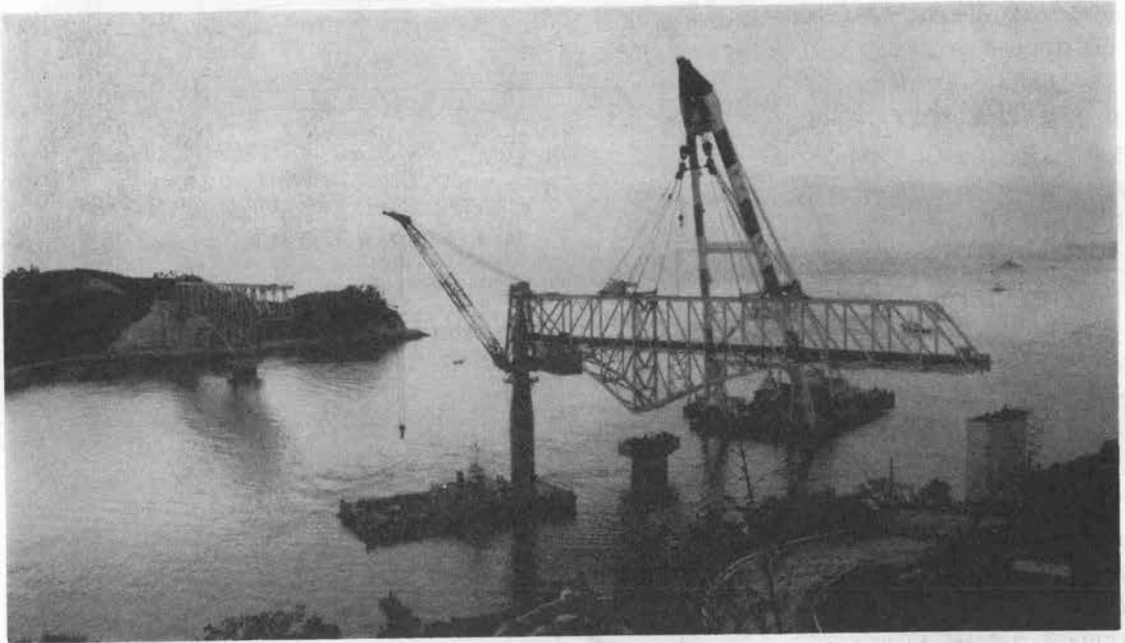
写真-9 側径間ブロックの架設
