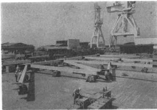
写真-5 トラス平面組立
