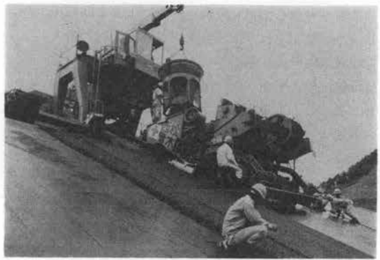
写真-2 舗設状況
