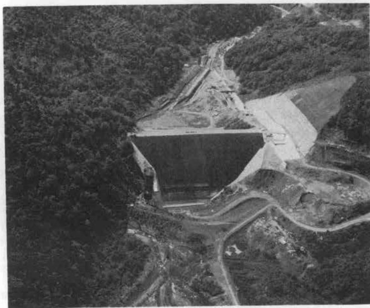
写真-4 舗設完了ダム全景
