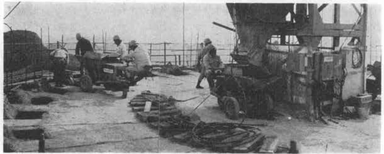
写真-3 上段作業床 (ミニダンプによるコンクリート運搬)
