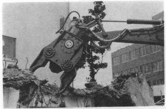
写真-27 アイアンジョーによる解体作業
