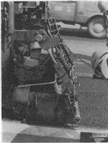
写真-33 わだち掘れ修繕・敷きならし装置
