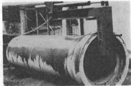
写真-6 管渠用C型フック
