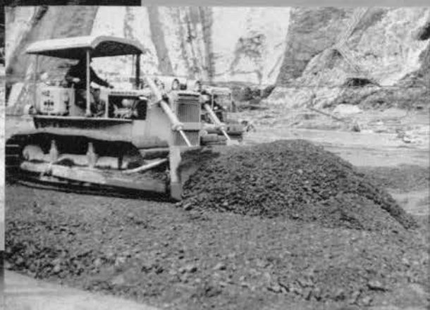
④ ブルドーザによるまき出し
