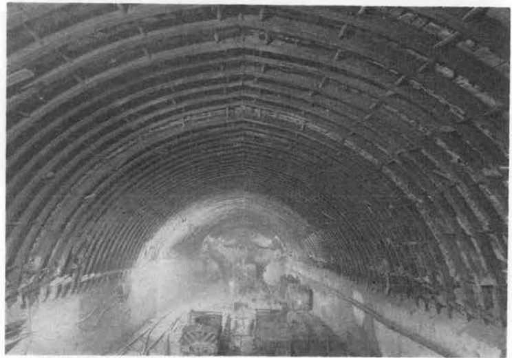
写真-1 中津川方本坑における側壁導坑先進リングカット工法施工状況
