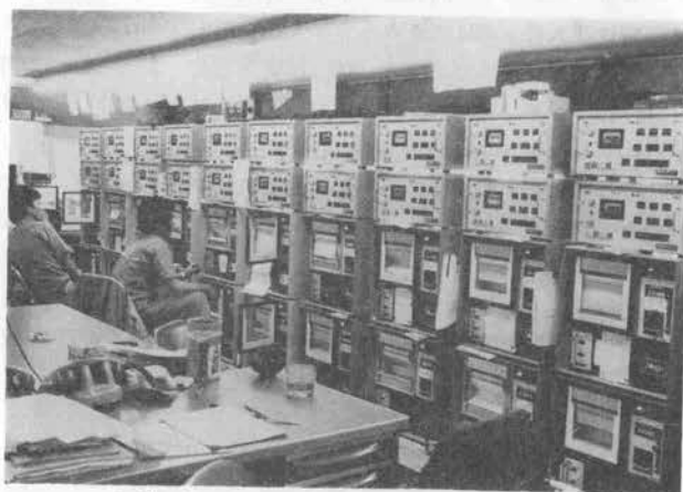
写真-4 グラウト流量計およびデータレコーダ
