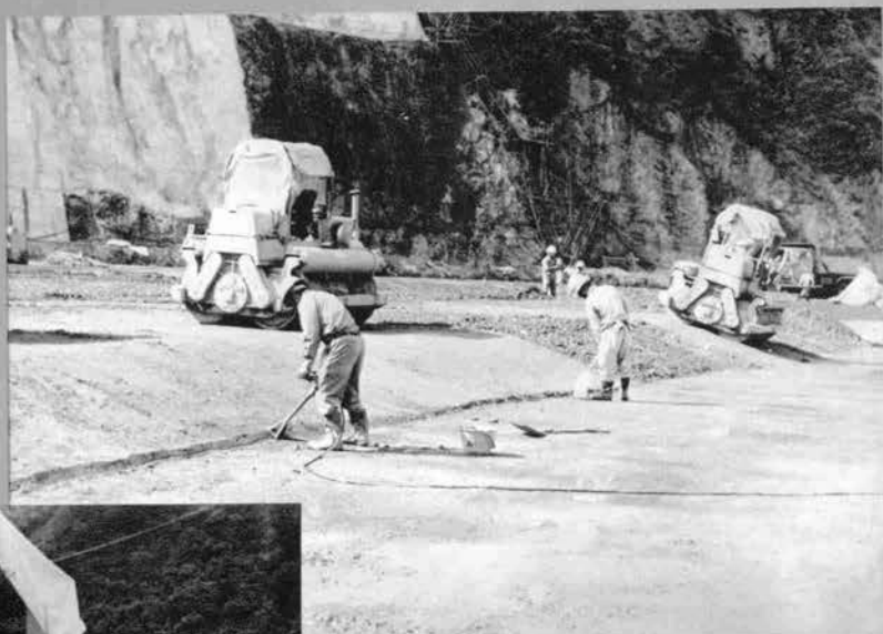
⇨ コンクリート打止部の処理状況
