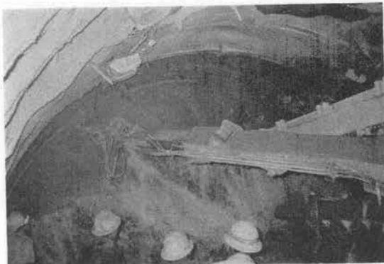
写真一 飯田方工事補助トンネルにおける NATM 工法施工状況
