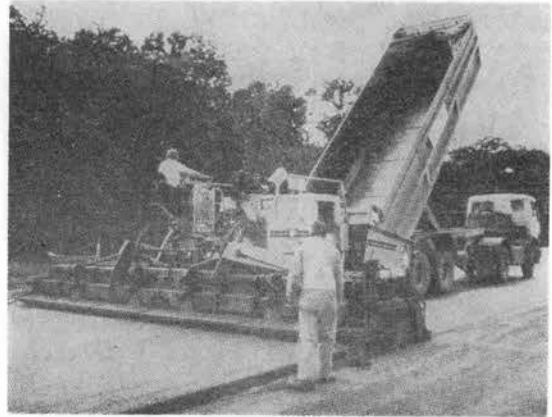
写真-3 新型アスファルトフィニッシャによる試験施工
