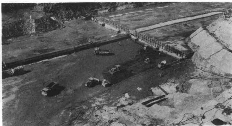
写真-1 大川ダム RCD 工法施工状況
