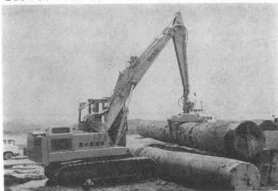
写真-7 油谷 YS 750 油圧式クローラクレーン
