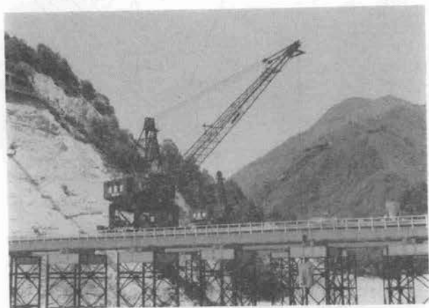
写真-2 下段上流(手前)下流に配置したジブクレーン
