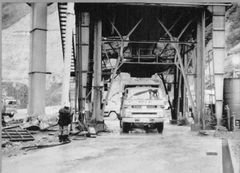
④ バッチャプラントからダンプトラックへ
