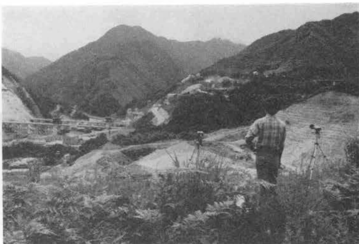
写真—6 別荘地端よりダムサイトを望む
