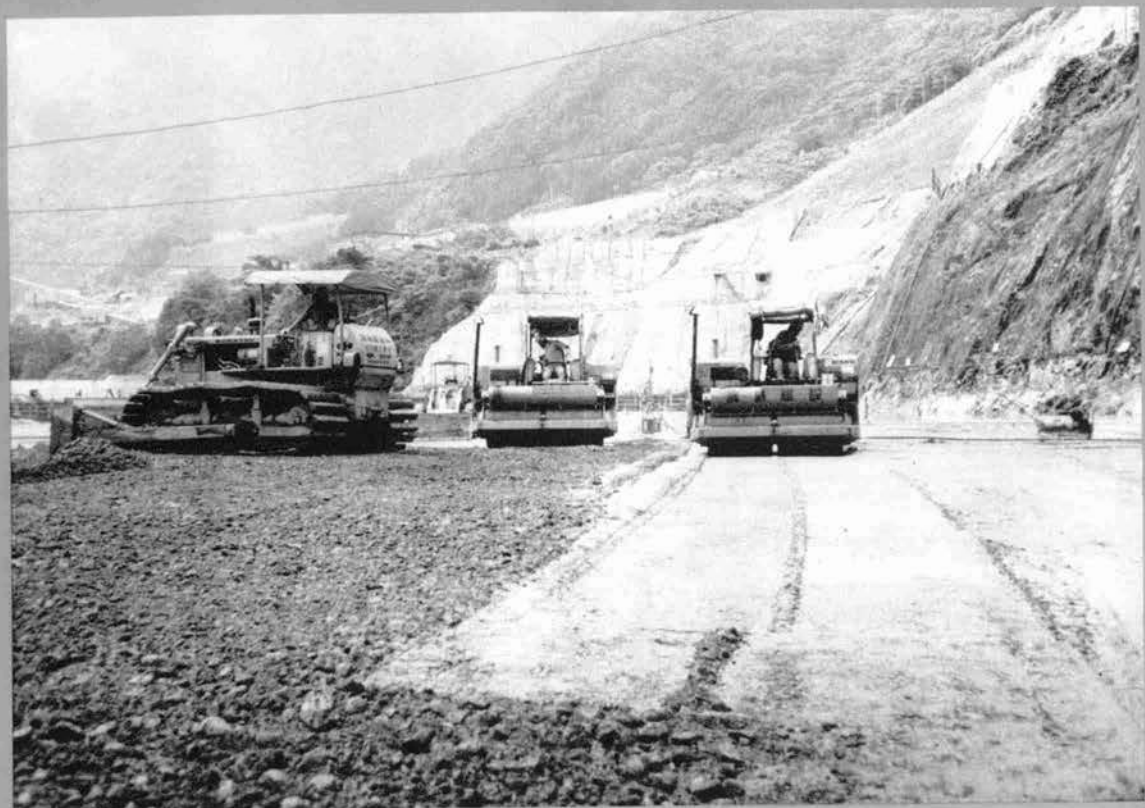
⇨ 振動ローラによる締固め
