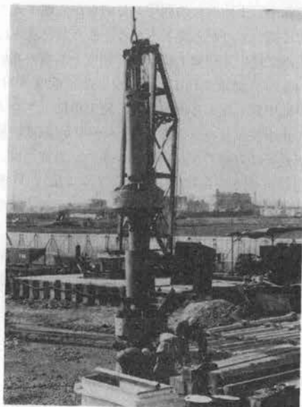
写真-1 リバースサーキュレーションドリルビット部
