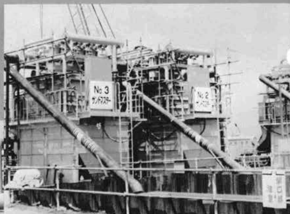
⇨ 掘削土砂分離装置
