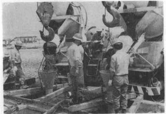
写真-4 コンクリート打設状況
