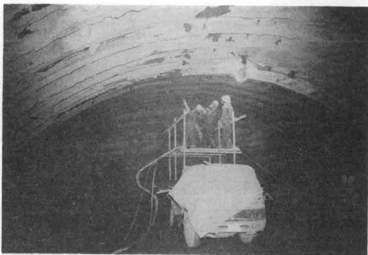
写真-5 コンクリート吹付（1次覆工）
