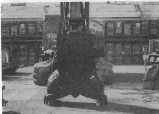
写真-3 BSP 掘削機
