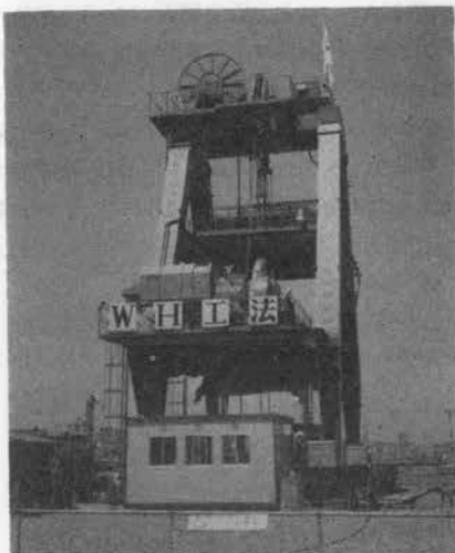
写真-3 MEH掘削やぐら
