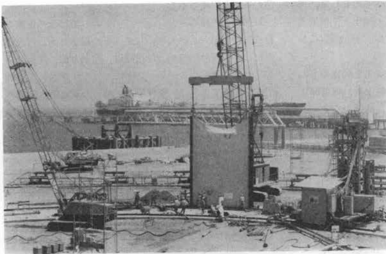
写真-3 Aエレメント鉄筋かご建込状況
