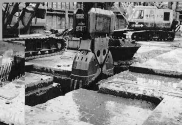
⇨ 十形ユニットの掘削
