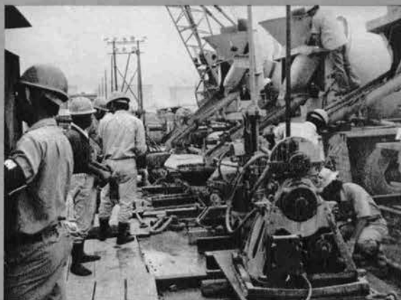
コンクリート打設
