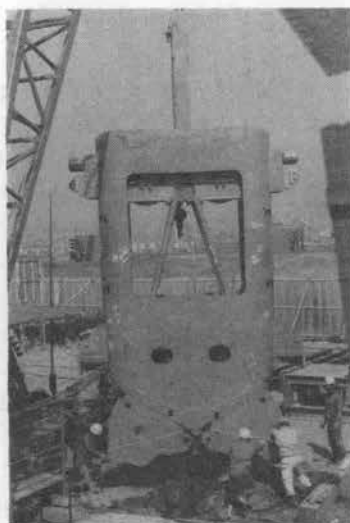
写真-4 Bachy 社製ケーブルグラブ
