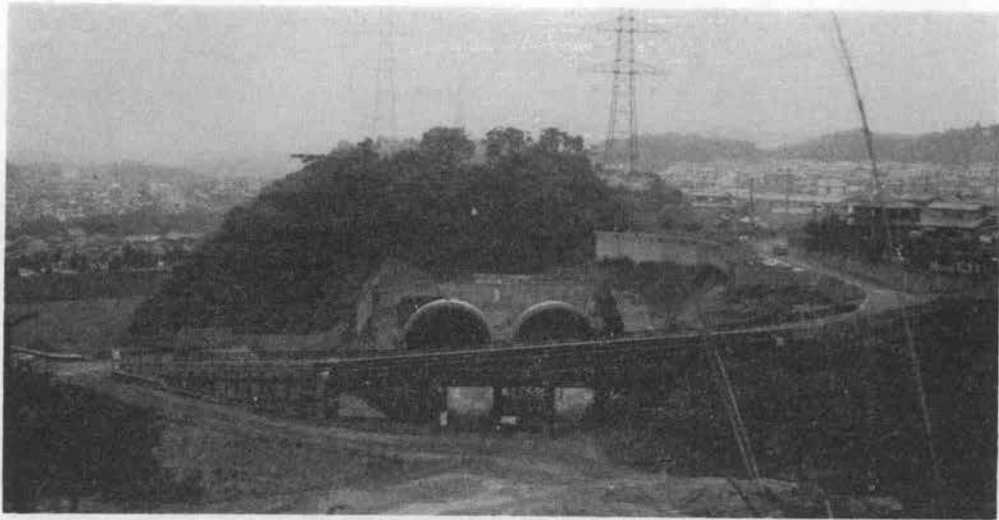
写真-2 横浜第2トンネル
