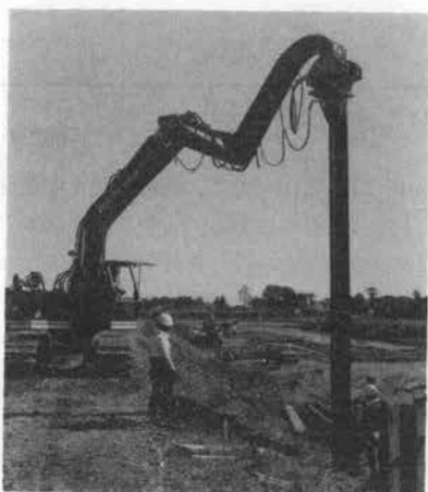
写真-8 日本ニューマチック HP-909-7 杭打抜機
