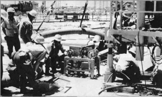
超音波溝壁測定器による 溝の掘削精度測定
