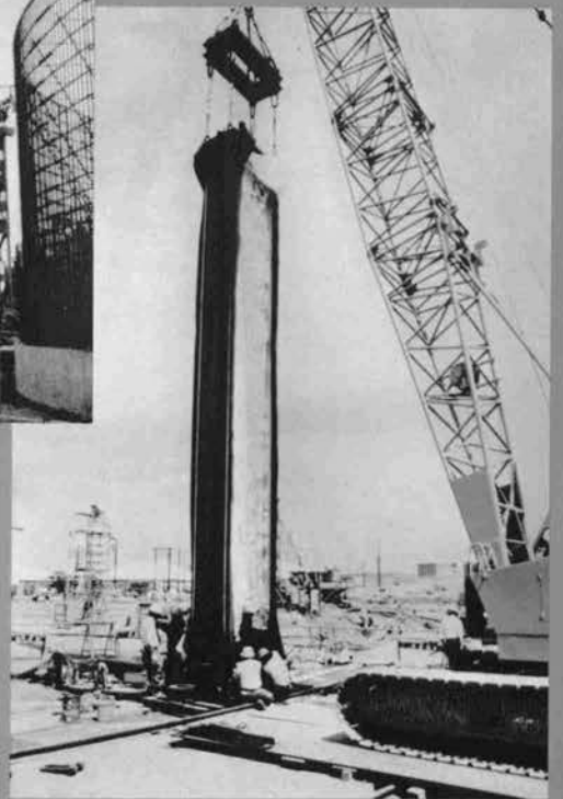
ジョイント部建込み
