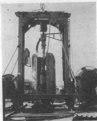
写真-1 先行ボーリング用掘削機
