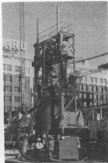
写真-2 掘削試験状況 (その2)
