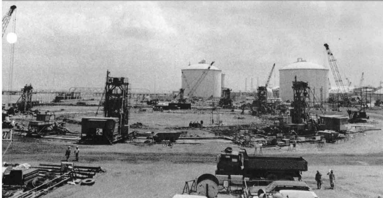
東京ガス袖ヶ浦工場13万kL LNG地下式貯槽工事
