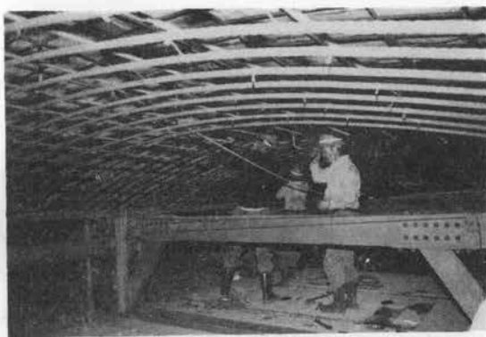
写真-6 2次巻鉄筋工
