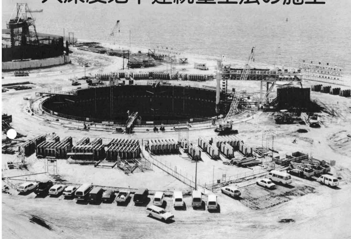
東京ガス袖ヶ浦工場13万kL LNG地下式貯槽工事
