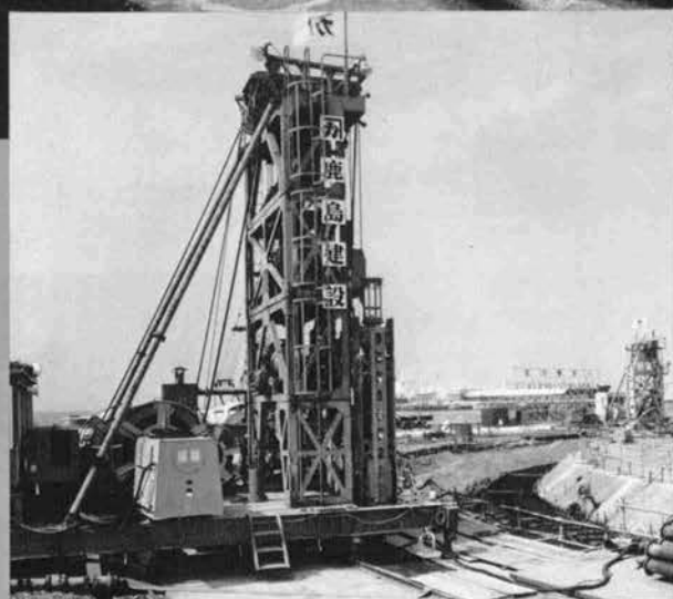
⇨ 連続壁掘削状況
