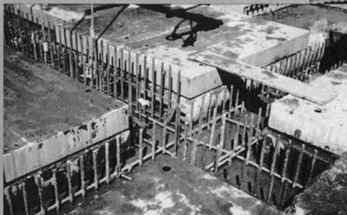
⇨ 十形ユニットに鉄筋かごを納めた状態
