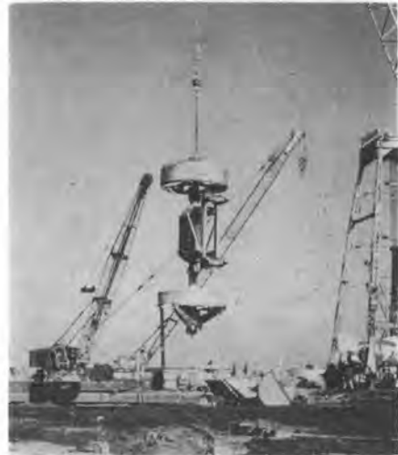
写真-3 一般杭さく孔用ドリルビット
