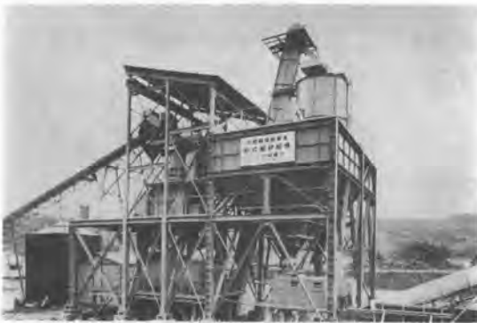
写真-6 川崎ユニット式立型製砂プラント
