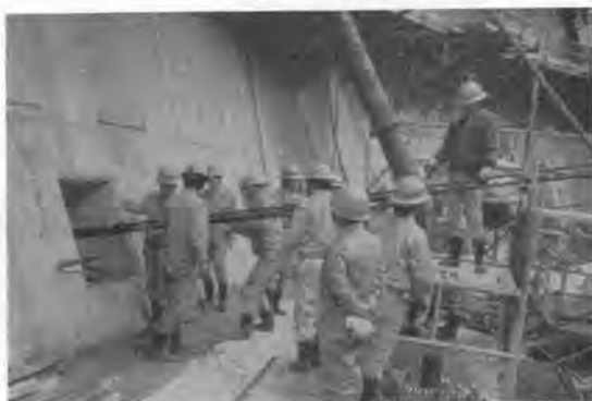
写真-1 PS 鋼棒挿入中
