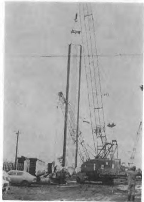
写真-1 鉄筋建込状況
