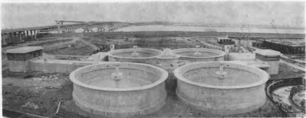
写真-3 汚泥濃縮槽
