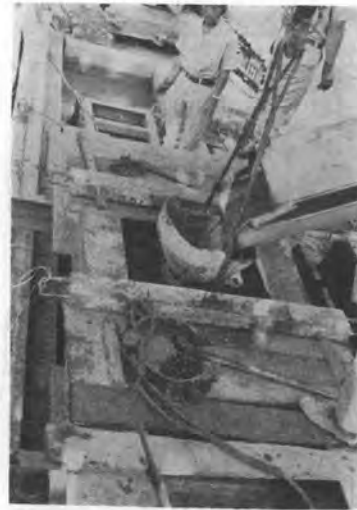
写真-2 コンクリート打設状況
