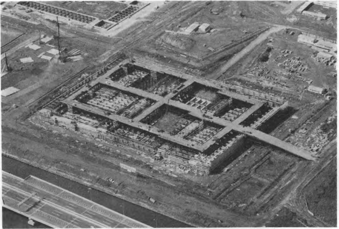
写真-2 北水処理施設第1系列施工状況
