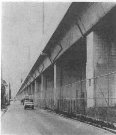
写真-3 完成した東仙台高架橋
