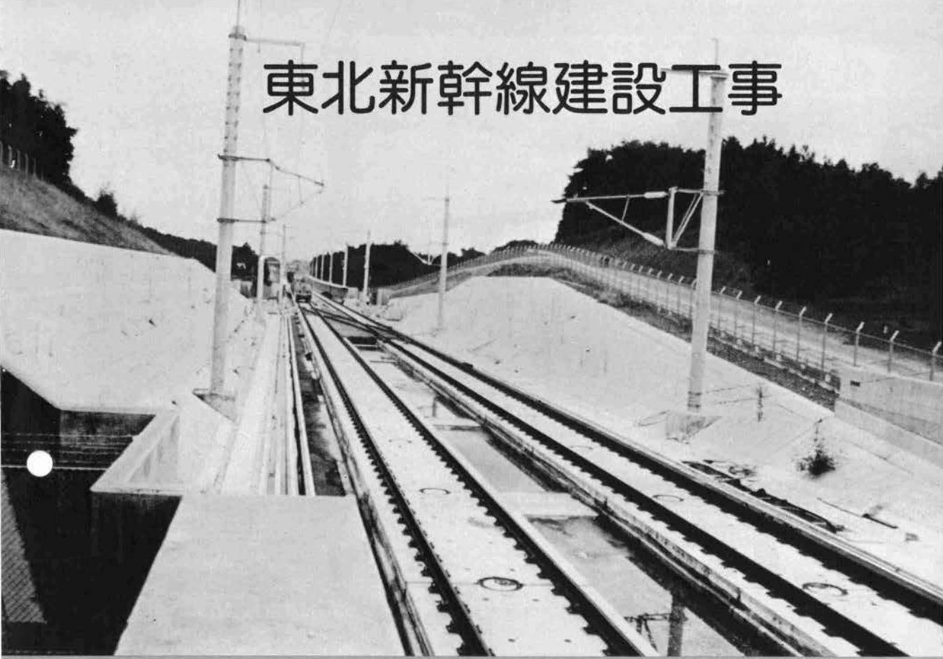
◆切取区間のスラブ軌道（路盤はCcスラブ形式）
