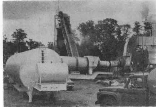
写真-2 再生用添加剤は左側のタンクから中央に見える回転ドラムに供給され、250°F に加熱されている古いアスファルトと混合される
