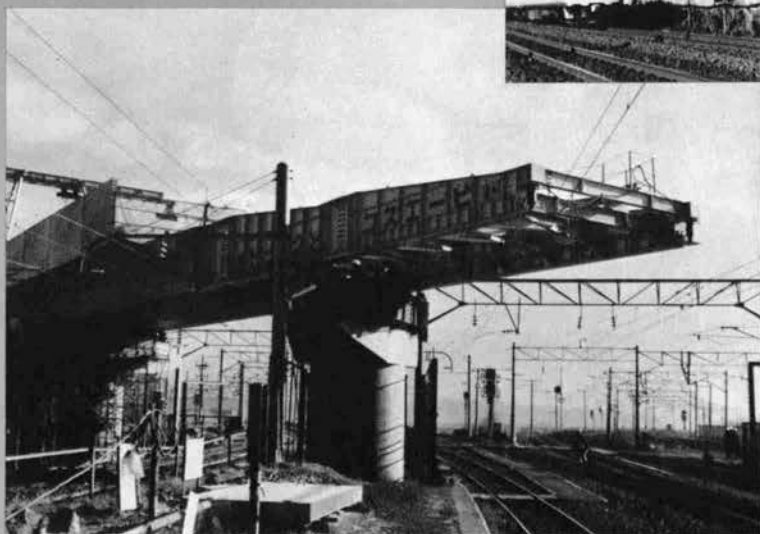
⇨東北本線，利府線の交差部を押し出し工法で架設中の岩切跨線線路橋（84.5 m）
