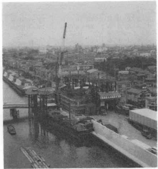
写真-1 P_5 ケーソン施工状況
