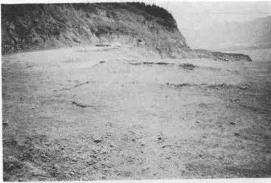
写真-5 予備発破後の岩盤表面
