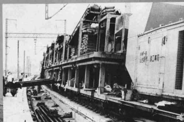
移動プラントによる軌道スラブ下への CA モルタル注入作業 ◇
