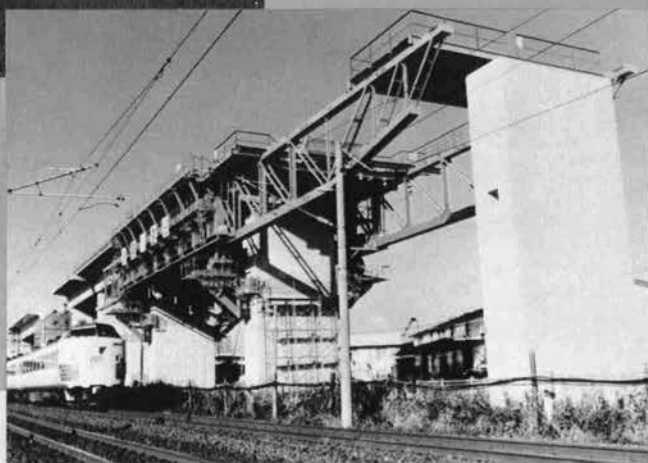
東北本線に近接してアルダス可動支保工で施工中の中通高架橋⇨
