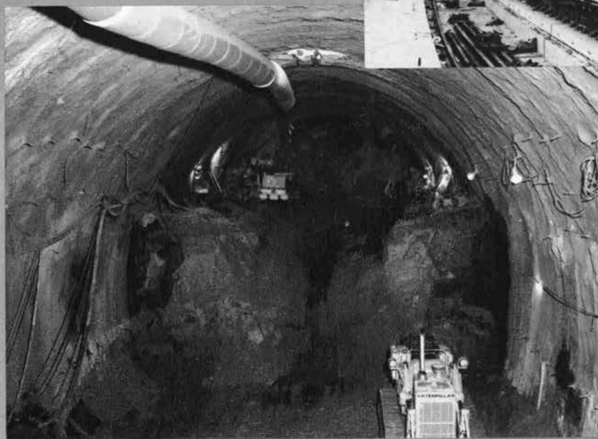
◇ NATM 工法で施工中の第 2 平石トンネル (245 m)
