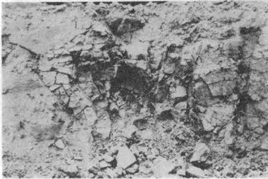
写真-6 予備発破後の岩盤断面
