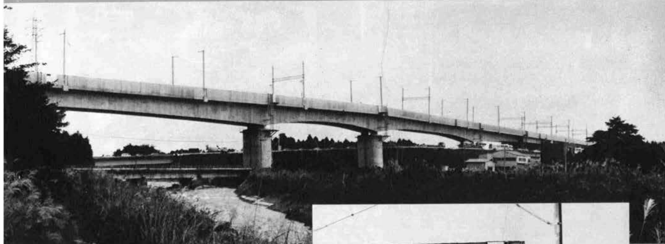
◇国道4号線交差部をディビダーク・カンチ レバー工法で施工した東那須野跨道線路橋 (260 m, 中央スパン 80 m)
