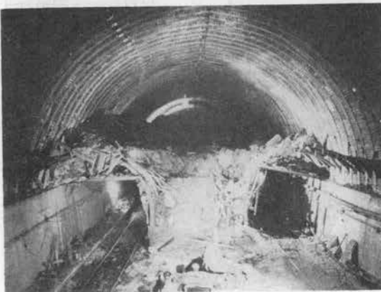
写真-1 在来工法（サイロット工法）
