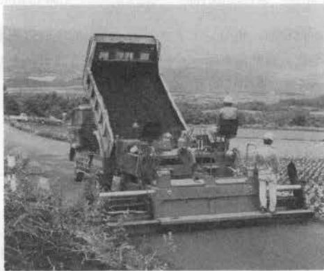
写真-9 新潟 NF 220 V-DM アスファルトフィニッシャー
