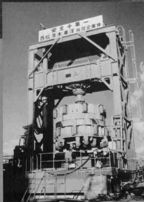
◆大鳴門橋下部工の \phi 4.4 m 多柱掘削 に使用された三菱ヒューズ・シャフ トボーリングマシン MD-440
