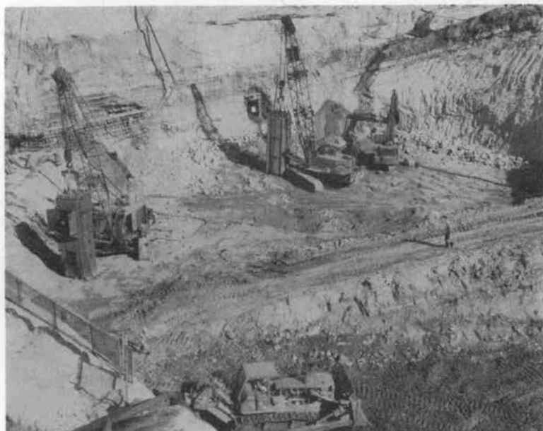
写真-2 ロックブレイカによる掘削状況
