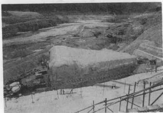
写真-6 函体の防寒工
