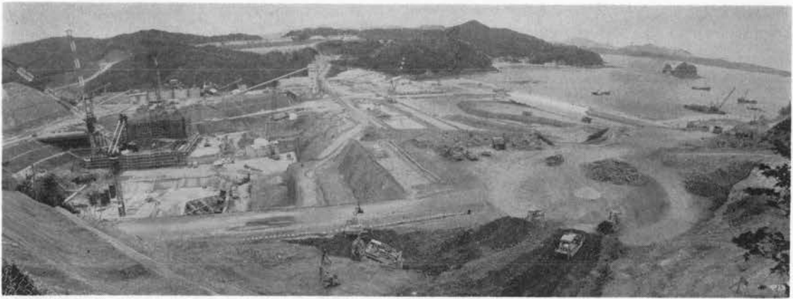
写真-1 工 事 状 況
