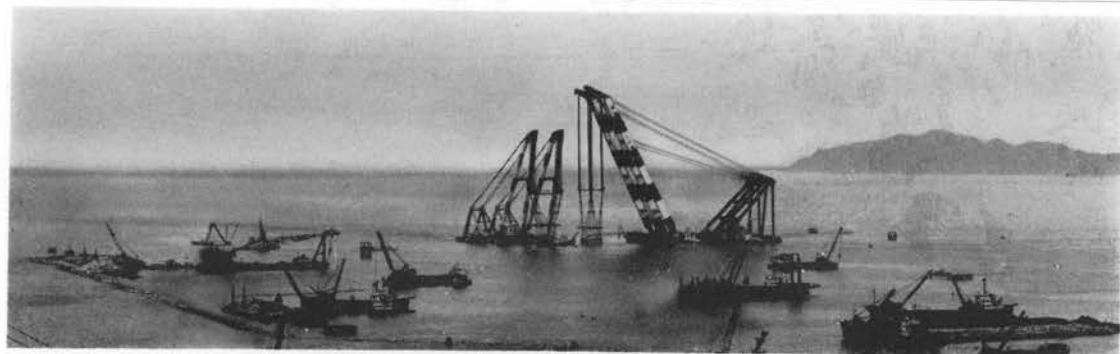
写真-2 海上工事 (3,000 t クレーン船によるケーソン据付)
