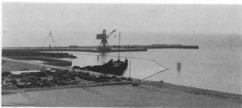
写真-6 撤去中の仮締切
