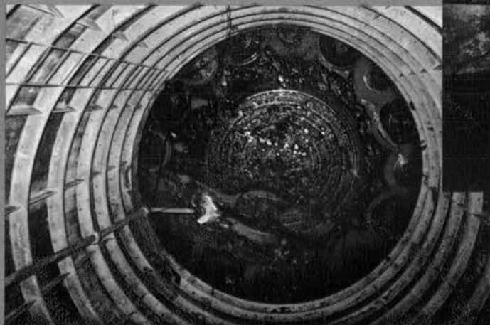
⇨ \phi 7.0m掘削完了（ \phi 4.4m芯抜部、残壁部、16本のリング掘削部の跡が残っている）
