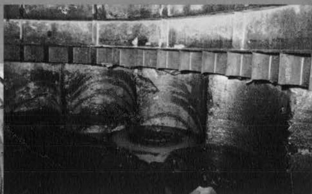
⇨ \phi 7.0m掘削が完了した孔壁面と リング掘削のラップ部分詳細
