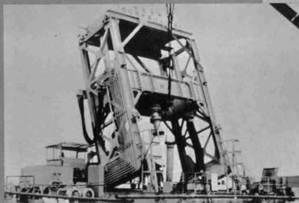
④ 3 m のドリルパイプの継ぎ足し
