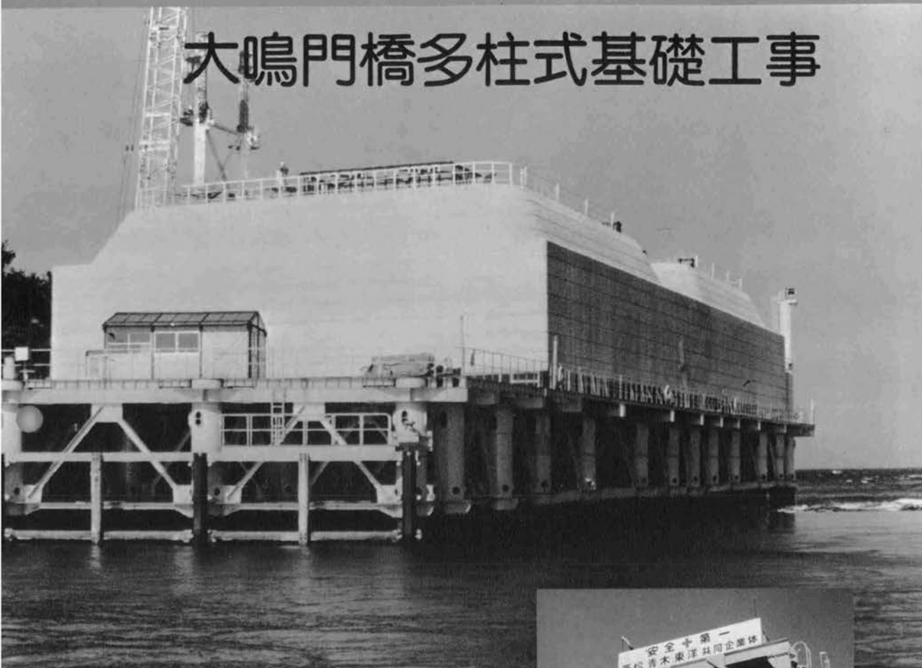
◆多柱基礎が完了し、その上に継ぎ頂版が 施工され、完成した橋台（4P側）
