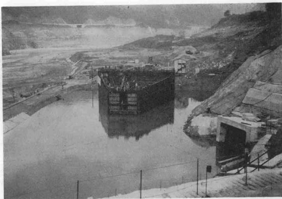
写真-4 函体の曳航(その1)
