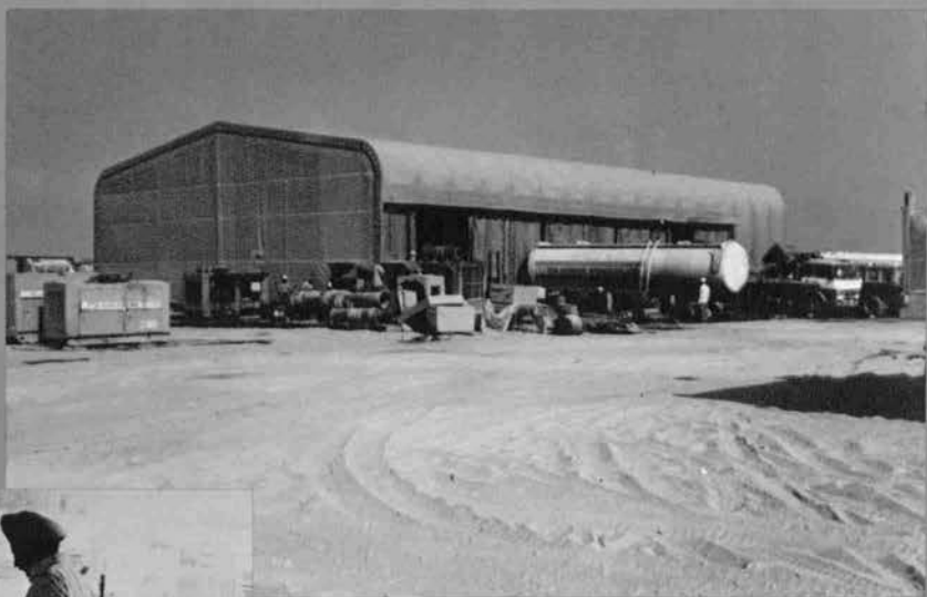
④イラク／コールアルズベール棧橋工事 ／仮設の整備工場（東亜建設工業）
