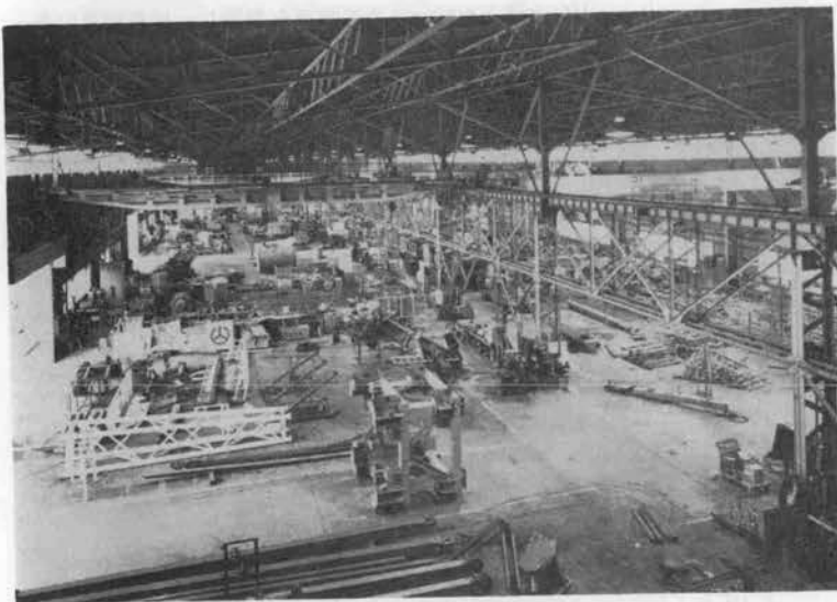
写真一2 東京機械工場の内部
