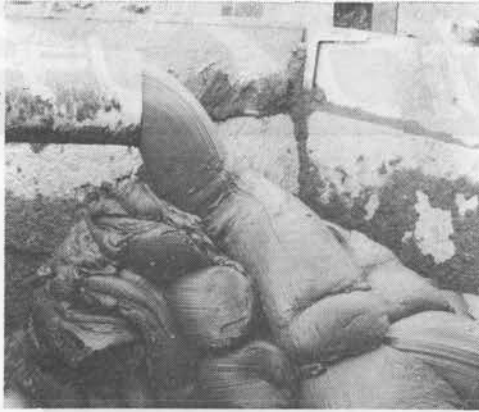
↑東京都の下水幹線工事現場。2NES100型で水平20m、垂直30m送られてホッパーに投入されるシルト (スラップ 幅10cm)
