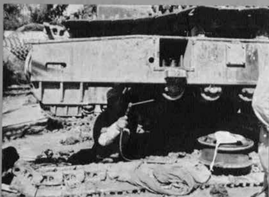
④ シンガポール/下水道掘削工事/クローラ下部の肉盛り作業 (神戸製鋼所)
