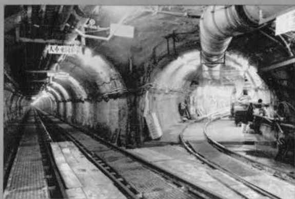
◇坑内修理工場への入口付近
