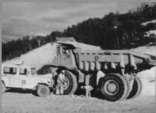
④マレーシア／ケネリ ン水力発電所新設工 事／32tダンプのタ イヤ空気圧および外 観の点検（間組）
