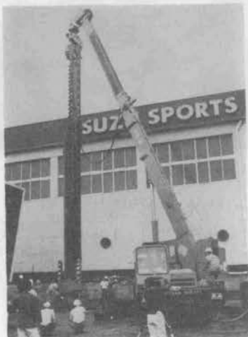
写真-10 中央自動車 AV-505 公害対策杭打抜機
