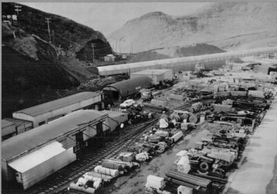
◇日本鉄道建設公団青函トンネル工事坑外修理工場
