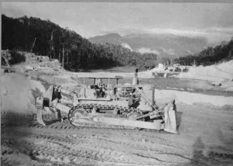
④マレーシア／ケネリン水力発電 所新設工事／40tブルドーザの グリスアップ（間組）
