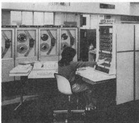
写真-2 コンピュータ室
