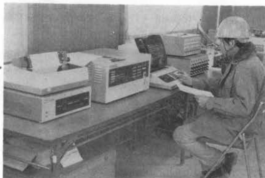
写真4 TL 押し出し工法施工管理システム
