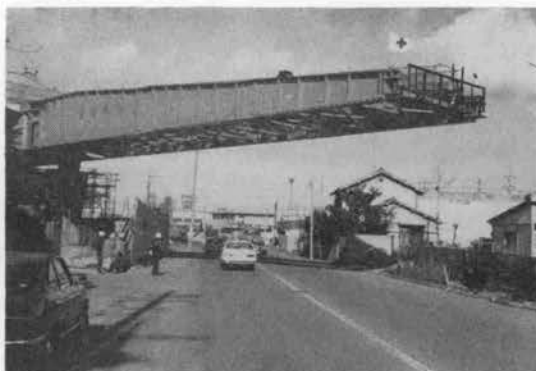
写真-3 手延桁
