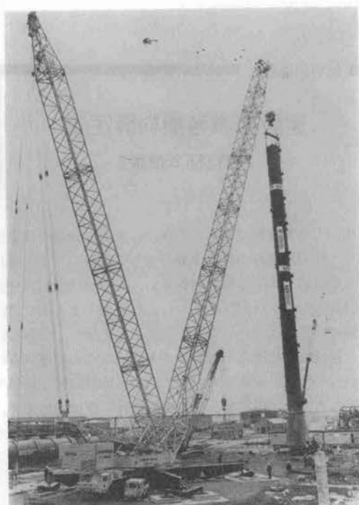
写真-2 TC4000 スーパーリフトクレーン
