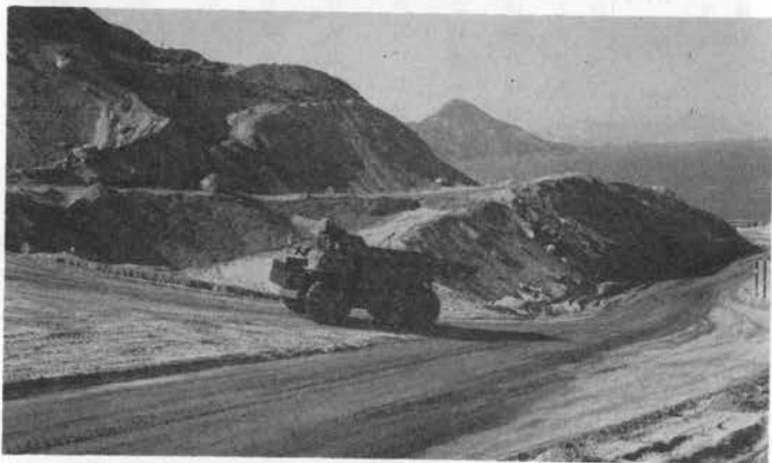
写真-4 江田島土砂採取工事
