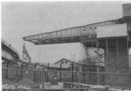
写真-1 鉄道直上高架の TL 押し出し工法
