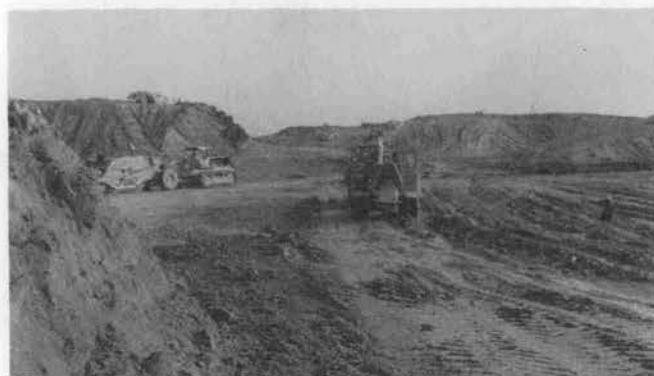
写真-1 緑ヶ丘団地造成工事
