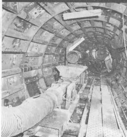
↑東京都足立区千住の管渠シールド作業現場。掘削機から送られてくる粘度の高い泥土をホッパー口へ受け、坑口まで圧送する2NES80型
