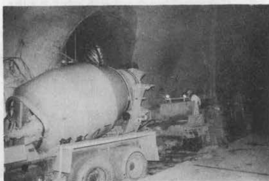
写真二 坑底よりのポンプ圧送
