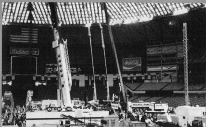
⇨アストロドーム内の Grove 250 t および P&H 100 t 油圧式トラッククレーン
