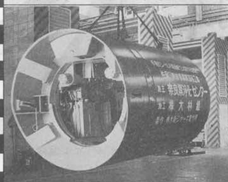
O・J手掘式シールド掘進機
