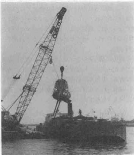
写真-1 RC杭、木杭引揚中のグラブ
