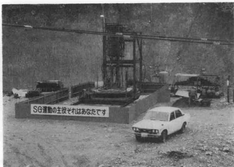
写真一 切上げ足場付クライマーと風防フェンス
