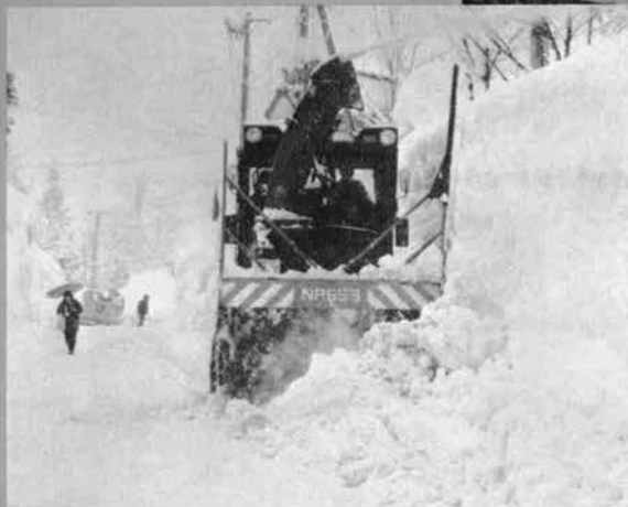
⊕サイドカッタを延長させての高雪堤の切くずし
