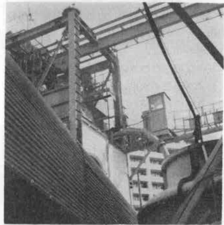
写真-6 ホッパへ入るエルボパイプ
