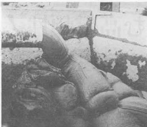
↑ 東京都の下水幹線工事現場。2NES100型で水平20m、垂直30m送られてホッパーに投入されるシルト (スラップ 10cm)
