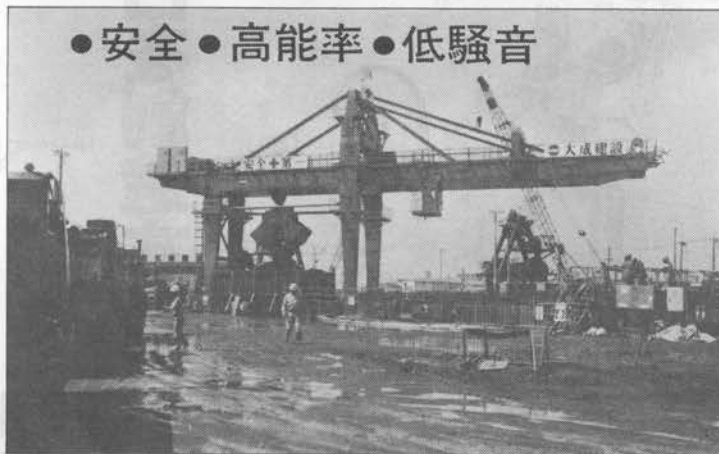
YBM-110型 バケット8M 3 能力600M 3 /D(地下40Mより)
