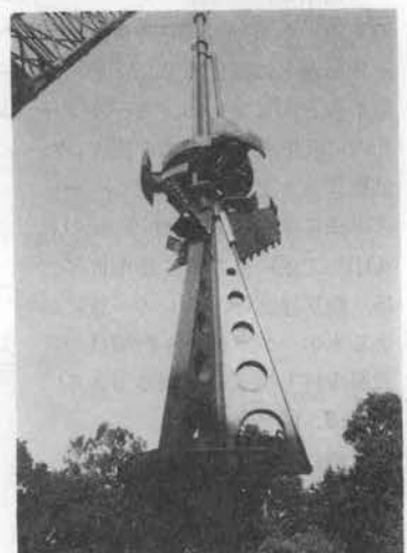
写真-4 HĀMAN工法(間組、丸広基礎工事、日特建設)
