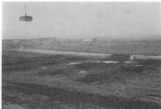
写真-2 作業状況(砂質地盤)
