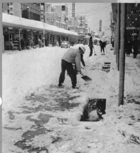
◆“住民協力”市街地の流雪溝が威力を発揮 (新潟県小千谷市内)
