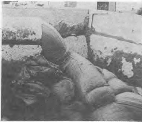
↑東京都の下水幹線工事現場。2NES100型で水平20m、垂直30m送られてホッパーに投入されるシルト（スランプ）
