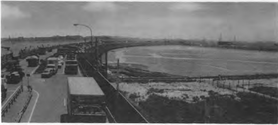
写真-1 現場状況写真(着手前)
