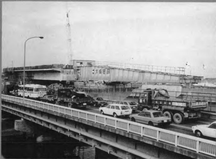
◆ 栄川を横過する3径間連続PC箱桁橋の押し出し工法。前方は架設用手延桁
