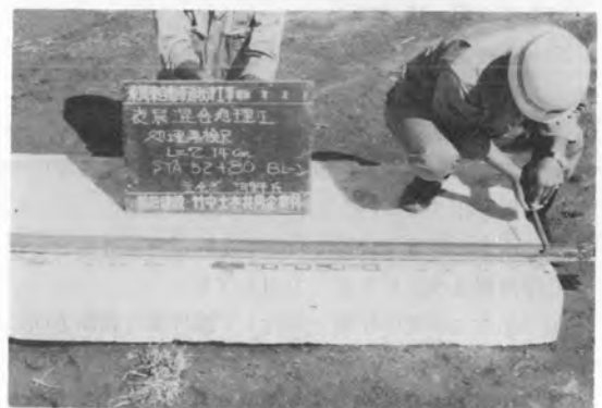
写真-6 改良地盤コア
