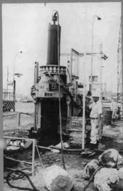
大口径 \phi 600 mm ボーリング による旧護岸撤去作業
