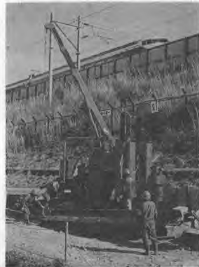
写真-2 無騒音無振動鋼矢板圧入機
