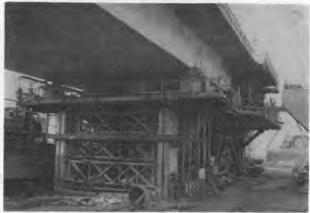
写真-1 前方は仮支柱上の滑り支承、後方は桁製作ヤード
