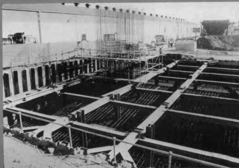
橋脚基礎フーチングの鉄筋組立
