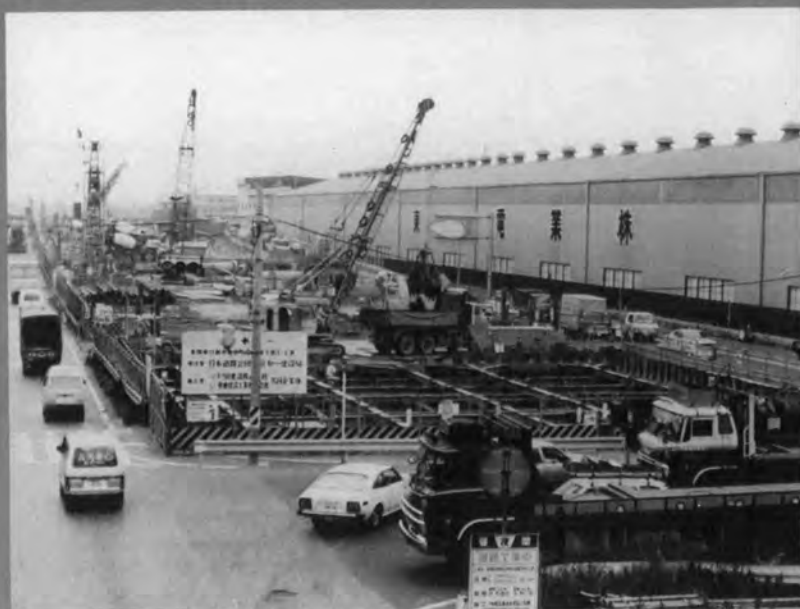
国道 357 号の両側にはさまれた栄町高架橋の日の出交差点付近の施工状況 (クラムシェルによる構造物掘削)
