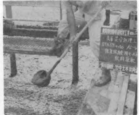
写真-4 処理中の地盤状況
