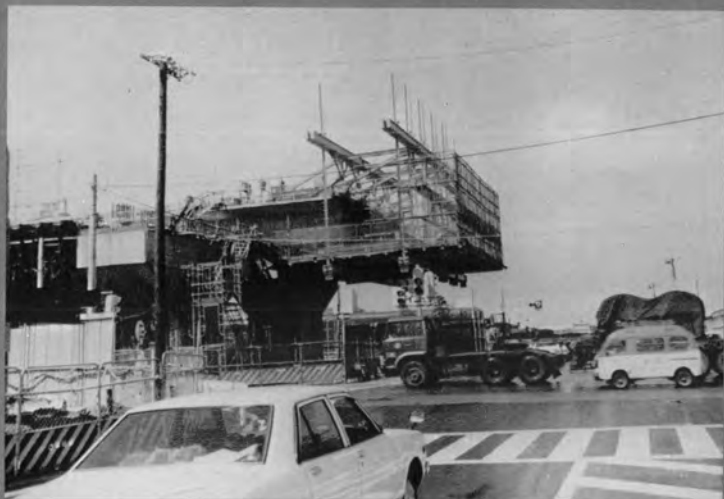
◆ ティビダーク工法によるPC3径間連続箱桁の中央径間部(若松交差点)の架設状況
