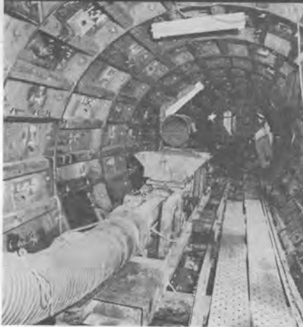
↑東京都足立区千住の管渠シールド作業現場。掘削機から送られてくる粘度の高い泥土をホッパー口に受け、坑口まで圧送する2NES80型。
