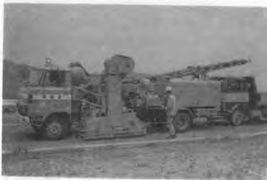
写真-1 路面整正機
