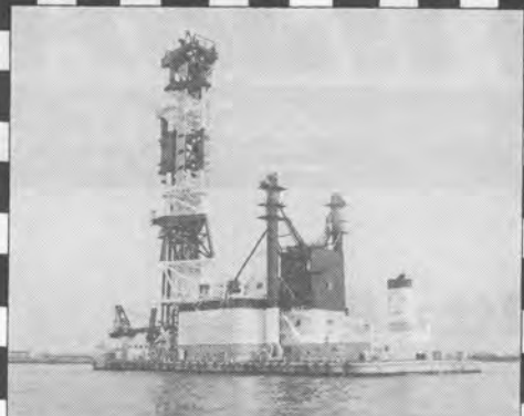
北川・深層超軟弱地盤改良処理装置
