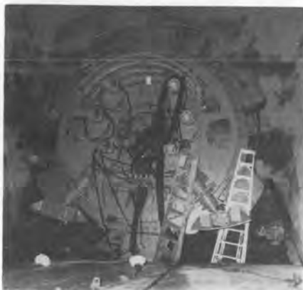
写真-2 ボーリングヘッド取付完了
