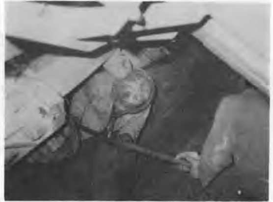
写真-5 カッタ交換作業（リーミング機）
