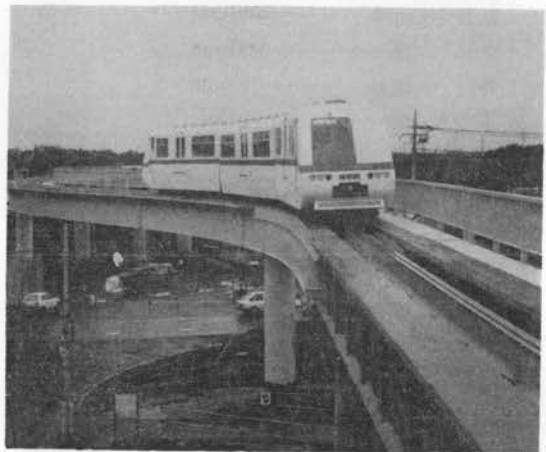
写真-1 成田街道架道橋上の試運転電車
