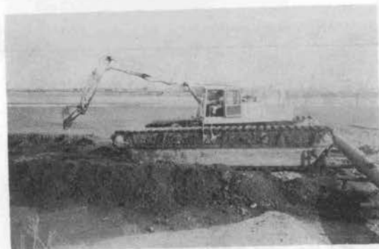
写真-5 河床清掃機(掘削機)
