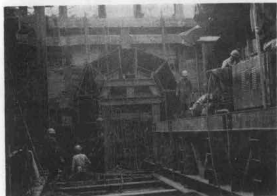
写真-5 エレメントの掘進 (No. 9)
