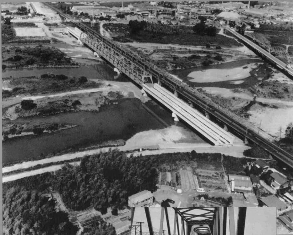
◆東海道本線野洲川橋梁全景
