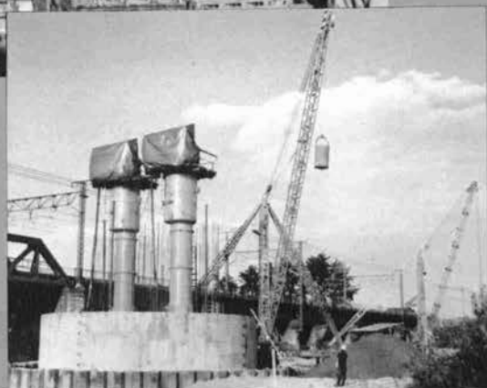
⇨ ケーソンの掘削設備
