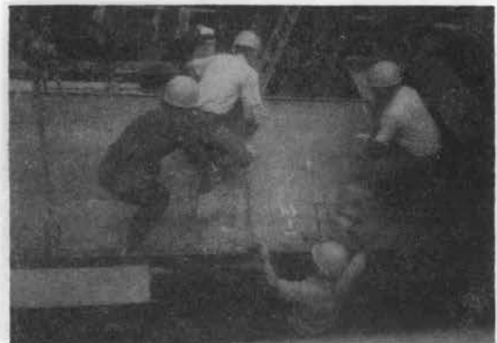
写真-3 エレメントの継足し (No. 2)
