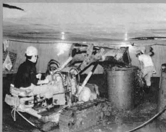
◆ケーソンの函内掘削作業
