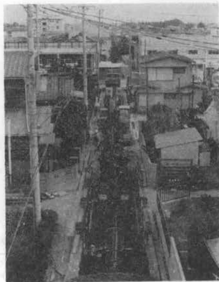
写真-25 連続式機械管渠埋設システム
