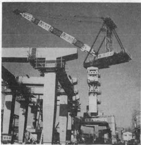
写真-4 走行式大型タワークレーン 6540
