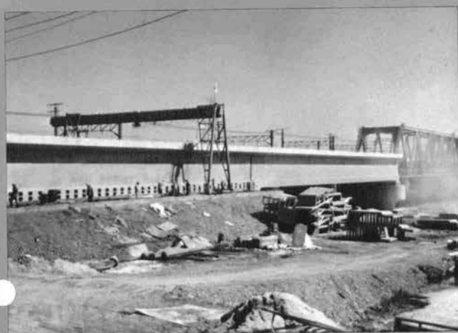
⇨ PC スルー桁と盛土式支保工
