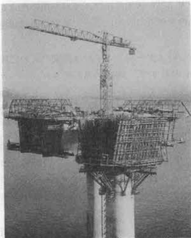
橋脚上からの作業
