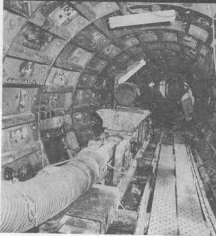
↑東京都足立区千住の管渠シールド作業現場。 掘削機から送られてくる粘度の高い泥土をホッ パー口に受け、坑口まで圧送する2NES80型。
