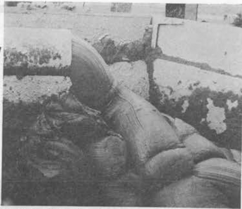
↑東京都の下水幹線工事現場。2NES100型で水平20m、垂直30m送られてホッパーに投入されるシルト（スランプ 約10cm）
