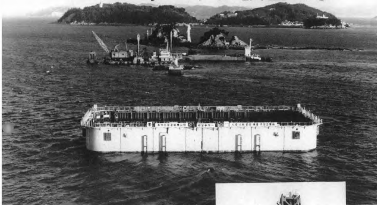
⇨沈設されたケーソン
