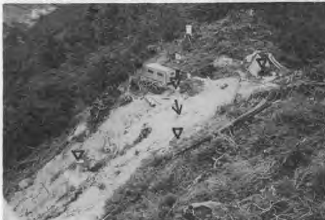
写真-4 鉄塔基礎工事中の 20 号鉄塔現場（▽印は鉄塔基礎、矢印はクレーン設置場所）
