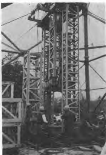
写真-2 地上せり上げ方式でクライミング中の CT 45
