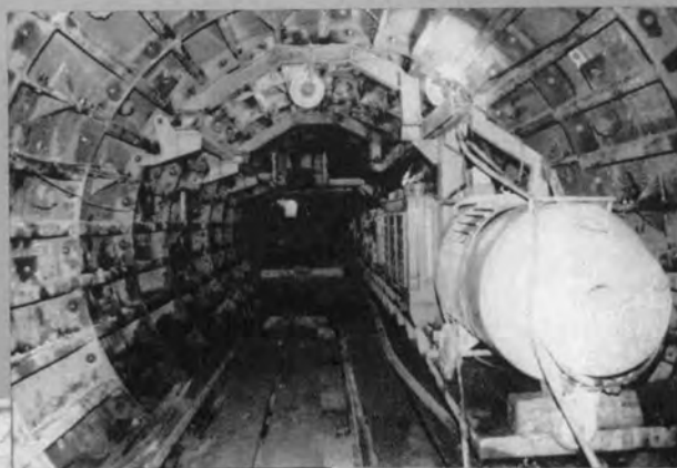
パイロットシールド（舞岡工区）
