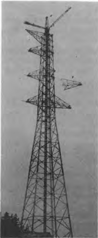
写真-5 腕金を組付け中の CT 45
