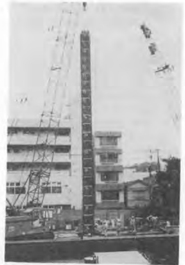
写真-4 鋼管の建込み
