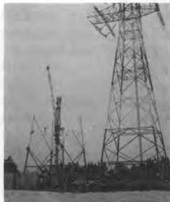
写真-6 既設鉄塔と隣接する鉄塔を組立て中の CT 45
