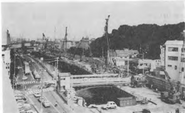
写真-5 現場作業状況（三井建設工区）
