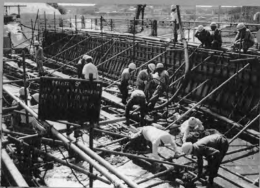
⇨ PC-下路桁打設中 (中里工区)
