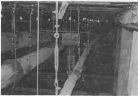
写真-2 埋設管つり防護
