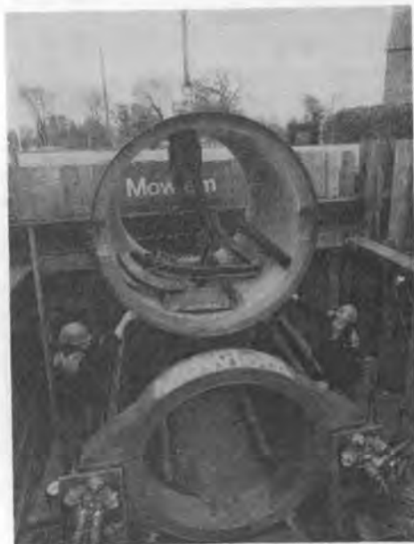
写真-1 反力受け装置
