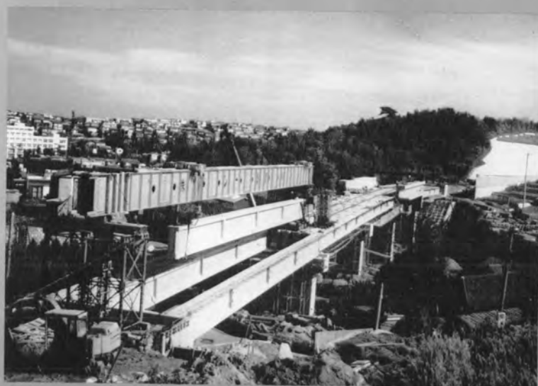
PC-I 桁架設中 (中里工区) ⇨
