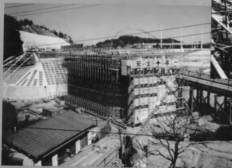
⇨ PC-下路桁支保工組立 (中里工区)
