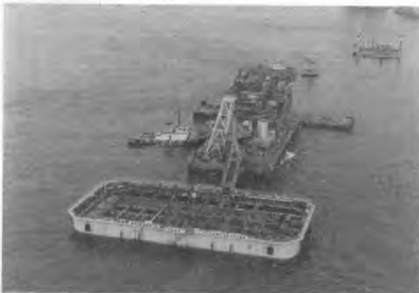
写真-1 リクレーマ船による大径粗骨材の投入工事
