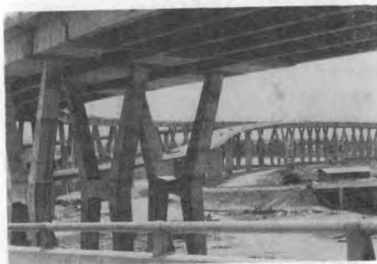
↑ 上部構造に比較して下部構造が簡略に見える
