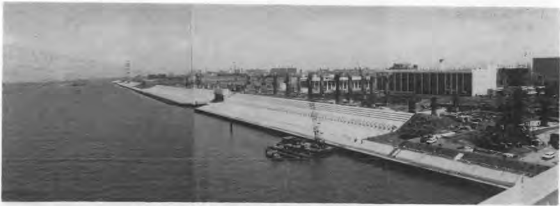
写真-2 荒川湾岸橋から見た葛西沖埋立地の工事現場
