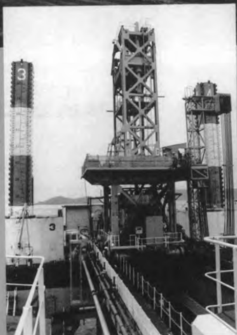
⇨底面仕上げ用大口径掘削機
