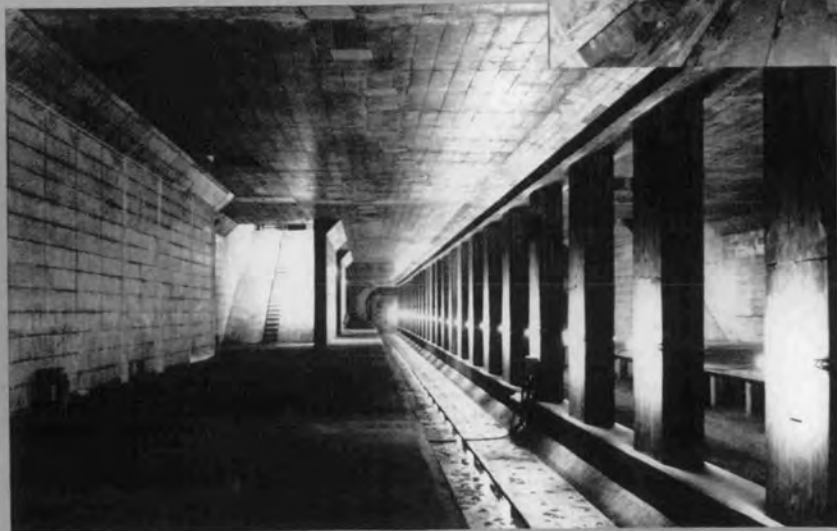
完成した地下2階（舞岡駅工区）
