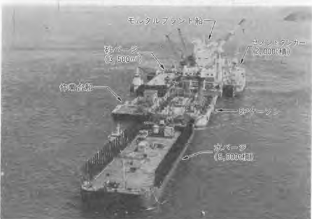
写真-1 リクレーマ船による大径粗骨材の投入工事
