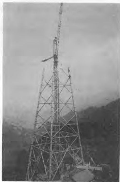
写真-1 奥清津秩父線現場で鉄塔組立て中の CT 65
