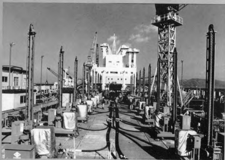
⇨ケーソン上のモルタル注入装置
