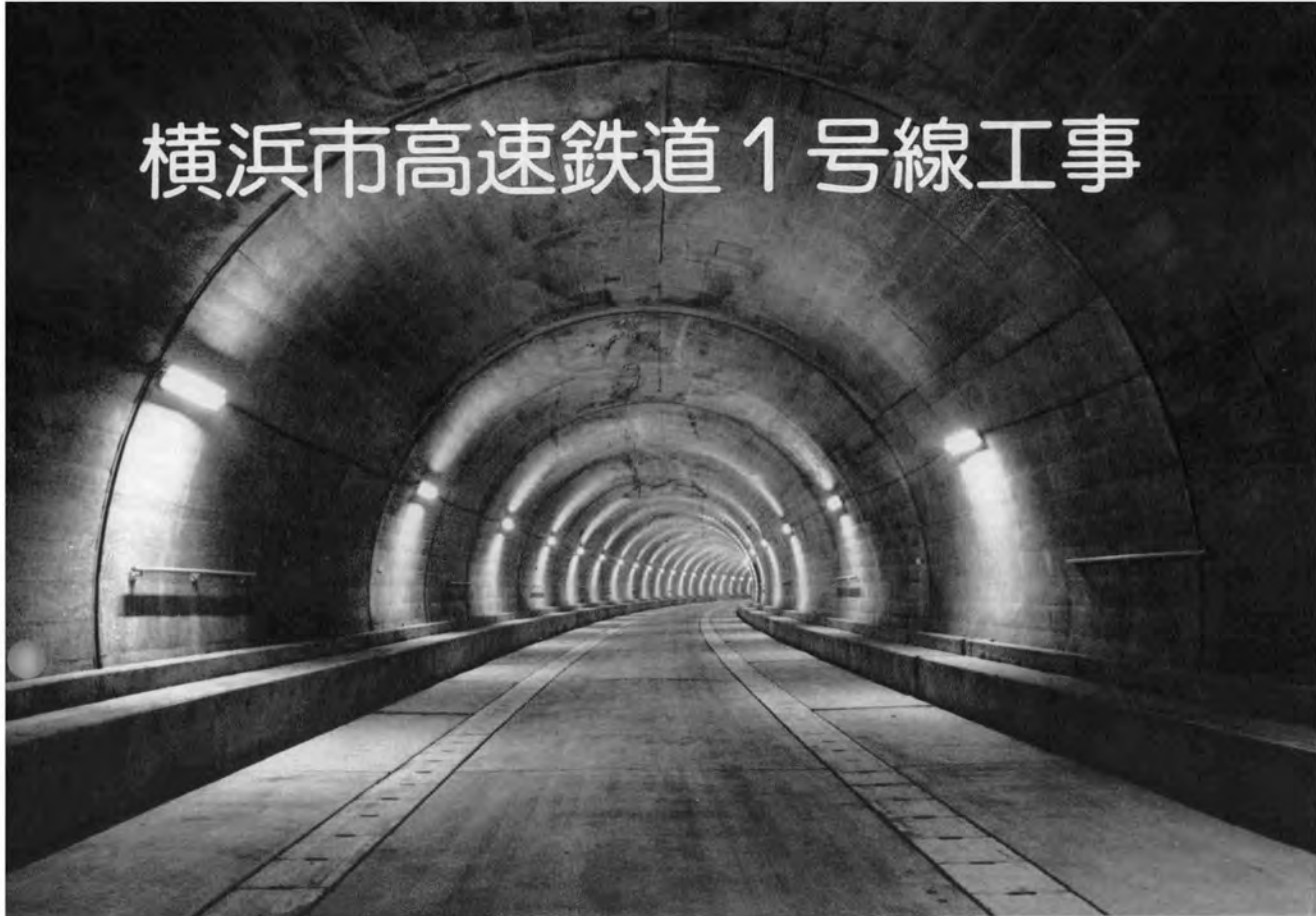
完成したトンネル（下永谷工区）
