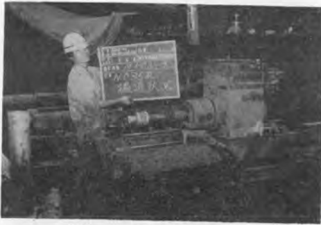
写真-1 パイプーフ施工中
