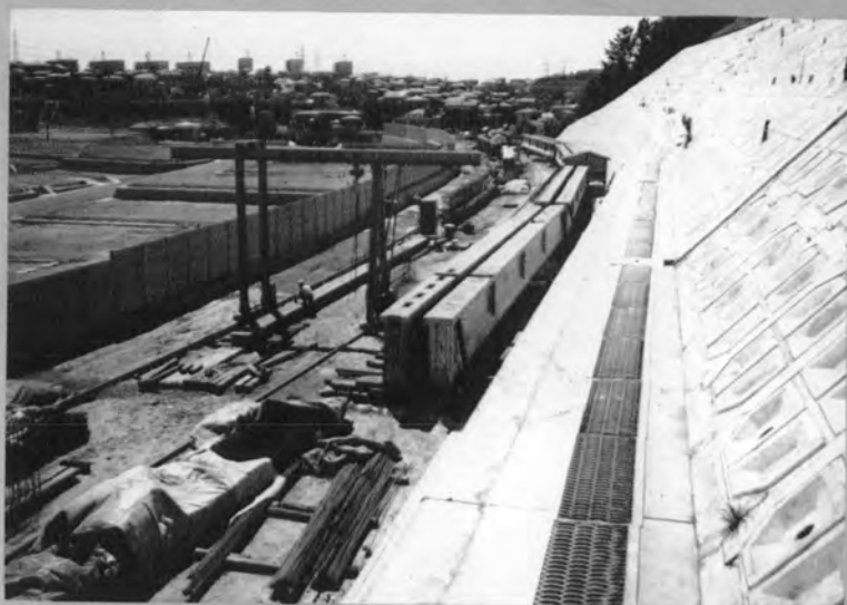
PC-I 桁製作中 (中里工区) ⇨
