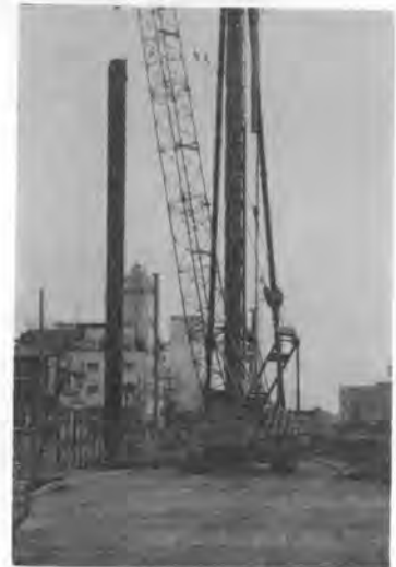
写真-2 鋼管の建込み
