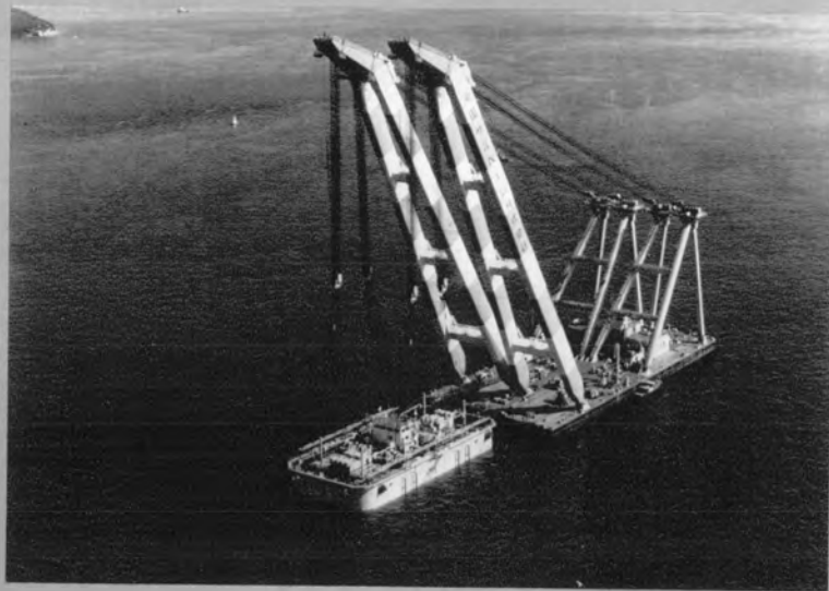
⇨大型クレーン船「武蔵」による ケーソンの沈設
