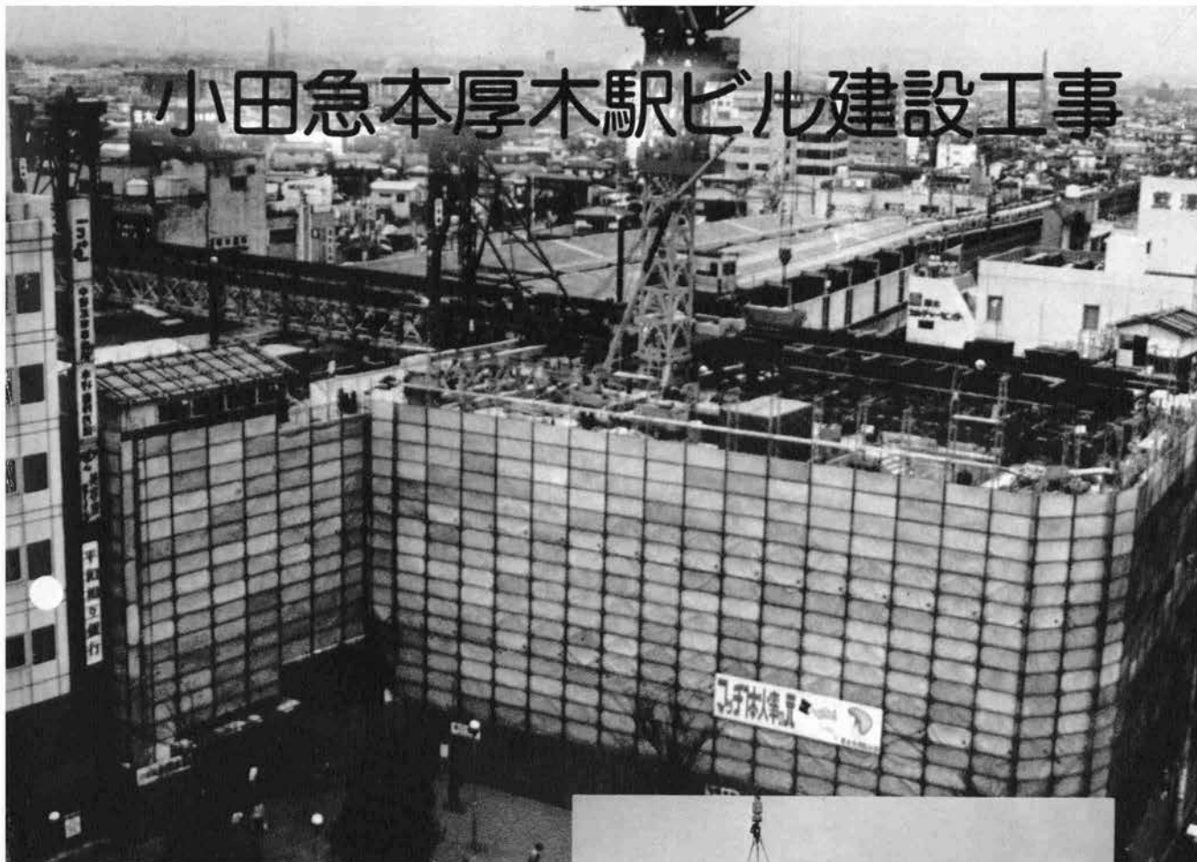
⚡ エレクショントラス架設完了
