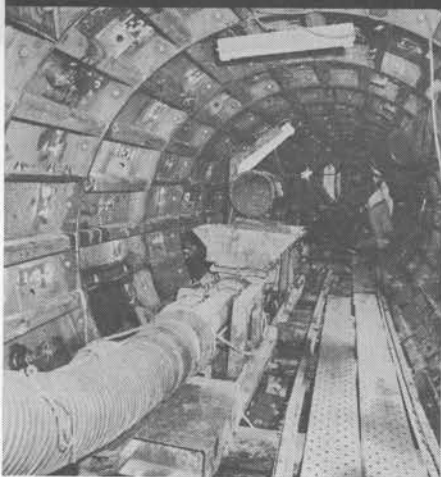
↑東京都足立区千住の管渠シールド作業現場。掘削機から送られてくる粘度の高い泥土をホッパーに受け、坑口まで任送する2NES80型。
