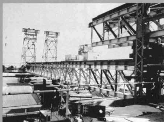
④ 2本目のエクシントラス送出し直前
