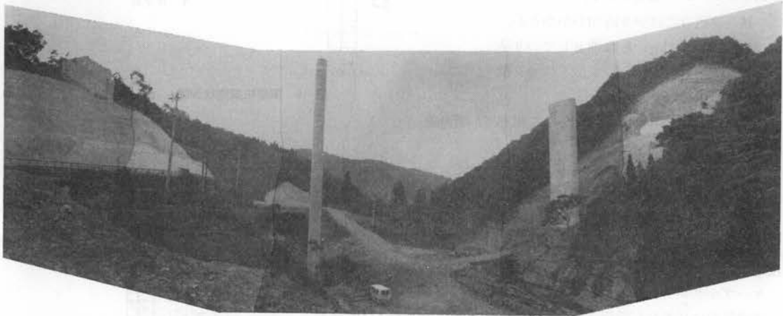
写真-2 完成した下部工（五位山橋上流部より眺む）
