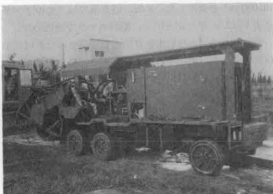
写真一七 三和機材 SIC-3520 インバートカッタ
