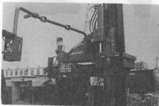
写真-5 ニッペイ NMP-200 ジャッキパイラー
