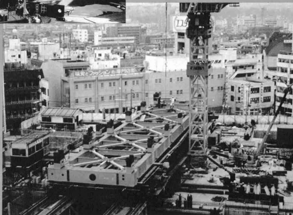
♡ ブリッジ鉄骨組立
