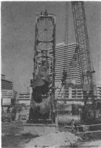
写真-4 ベント掘削機
