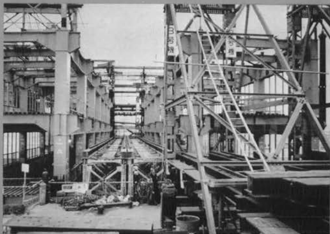
第2回ブリッジ送出し完了⇨
