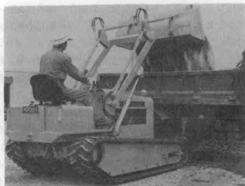
写真—11 モロオカ MS-30 ハイショベル（ゴム履帯付）
