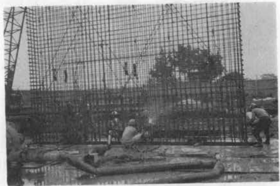
写真-5 鉄筋の建込み
