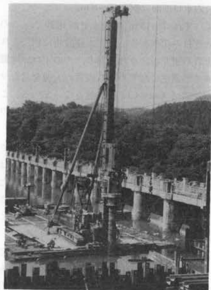
写真-2 200 t 台船とさく孔中のロックオーガ
