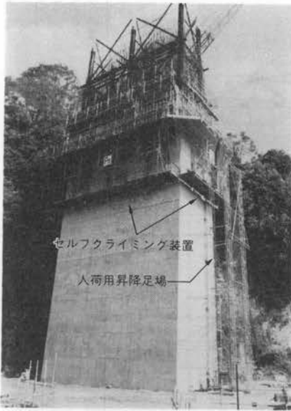
写真-3 高さ 30 m 付近を施工中の高橋脚 (P, 最終高さ 67 m)
