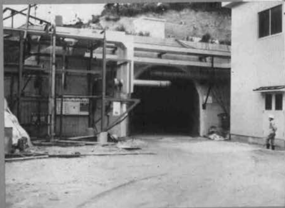
サービストンネル第2坑口（原油パイプ、計測用パイプ等が入るもので上部および左側がパイプ類が通り、右側が管理用の通路となる）
