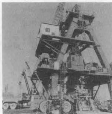
写真-3 WH 工法 (MHL 掘削機)
