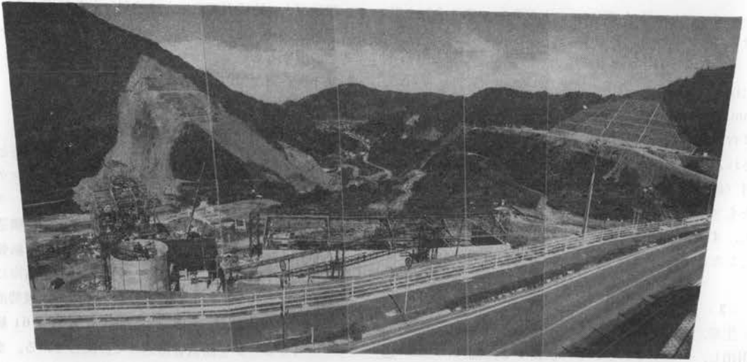
写真-1 骨材生産設備よりダムサイトを望む
