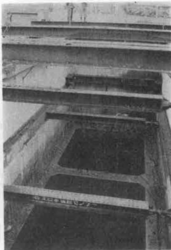
写真-1 ケーソン
