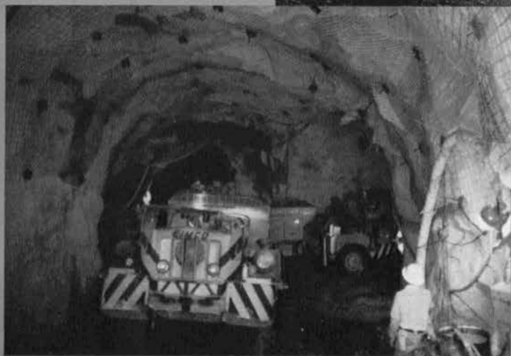
坑内専用ダンプによるずり運搬 （作業トンネル内）
