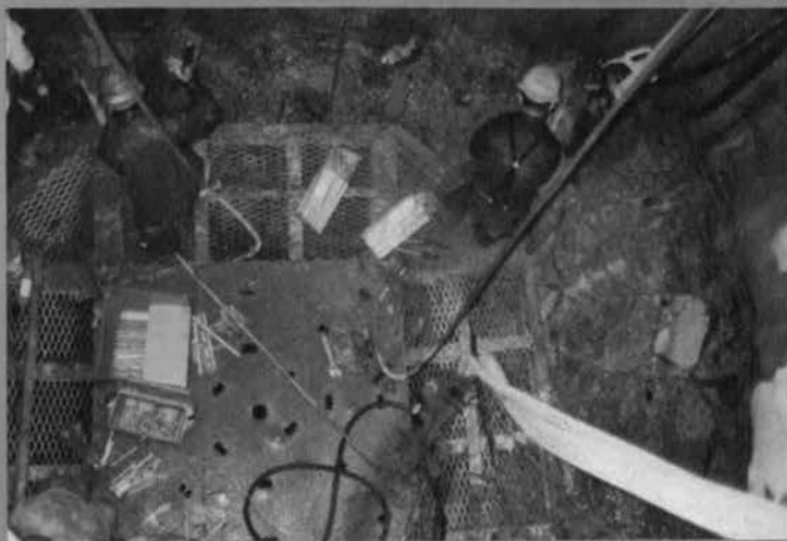
受入配管立坑切上げ作業
