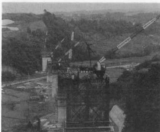
写真-2 施工中の沼尾川橋
