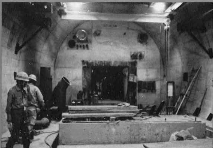
ドライポンプ室（原油払出し用ポン プおよび排水ポンプが設置される）
