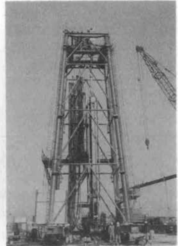
写真-4 OWS-SOLETANCHE 工法 (ハイドロフリーズ掘削機)
