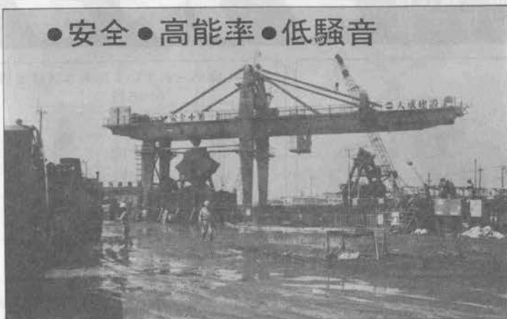
YBM-110型 バケット8M 3 能力600M 3 /h(地下40Mより)
