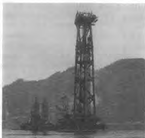
写真-3 DMM 工法作業船 (五洋建設提供)
