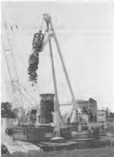
写真一 MT 120 オールケーシング掘削機
