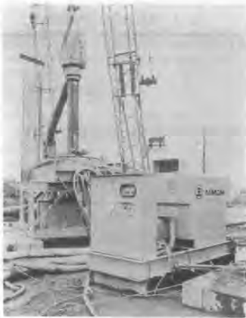
写真-2 S 450 リバースサーキュレーションドリル
