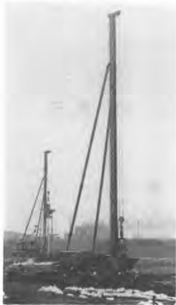
写真-1 バックドレーン工法 (不動産建設提供)
