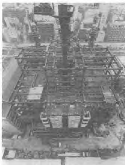
インベリアルタワー建築工事
