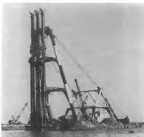
写真-2 サンドコンパクションバイル工法 (不動建設提供)
