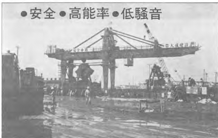
YBM-110型 バケット8M 3 能力600M 3 /日(地下40Mより)
