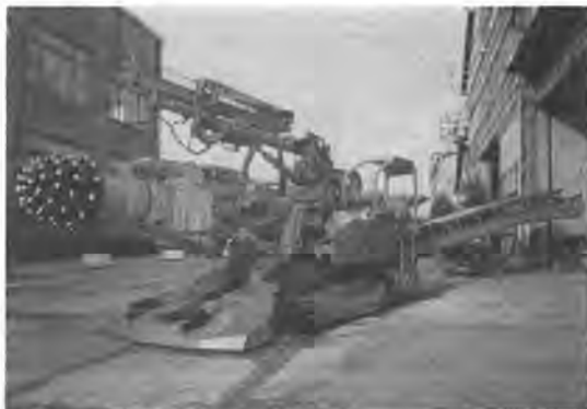
写真-1 ルーフボルト施工用のドリルを搭載した掘削機
