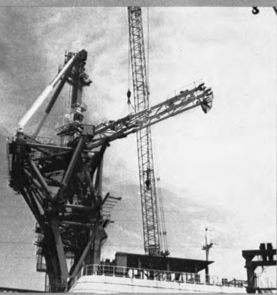
⇨ クリーパークレーンの組立作業 (3 P)
