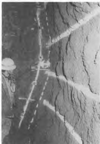
写真-5 3.3 m さく孔で 23 cm のロックアウト量を示す
