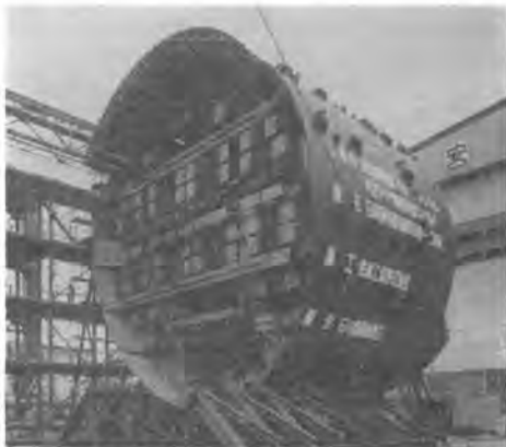
写真—1 特殊手掘りシールド (掘削径 12.84 m)
