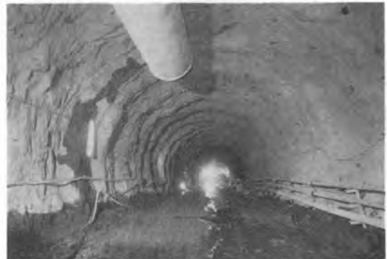
写真-2 スムーズブラスティングによる掘削状況
