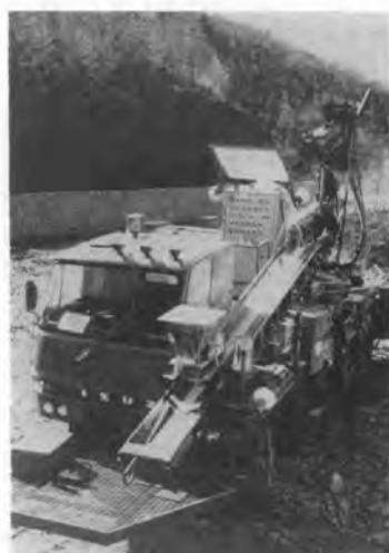
写真-6 全自動吹付ロボット
