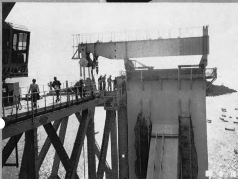
⇨ クリーパークレーンのせり上げ作業 塔柱上端の金物はつり天秤 (4 P)
