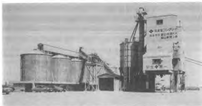
写真-1 バッチャプラントと骨材貯蔵用コルゲートサイロ
