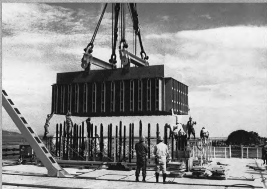
⇨ 塔柱第1段（約90t）の架設
