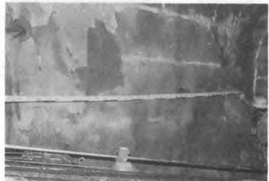
写真-4 長孔発破 3.9 m 起砕状況
