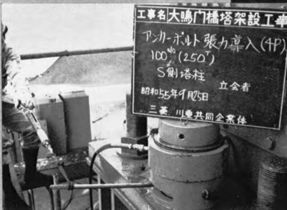
⇨アンカーボルトのプレストレス導入作業 （塔柱4段完了後）
