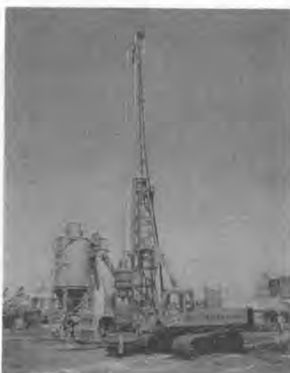
写真1 粉体噴射攪拌装置
