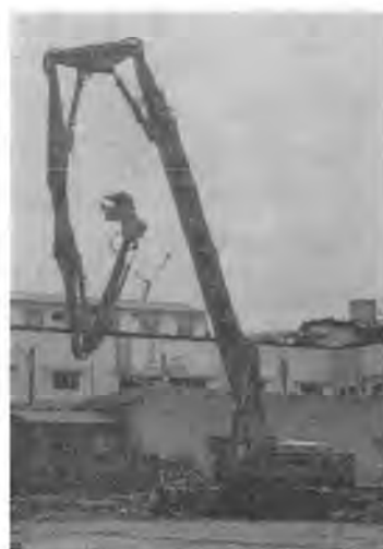
写真-11 油谷 YMN 40 W ビル解体専用機
