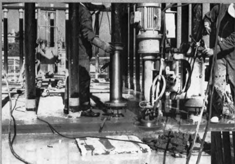
⇨ 旋回式研磨機によるコンクリート表面の水平切断（ブレードはサーキュラソー）
