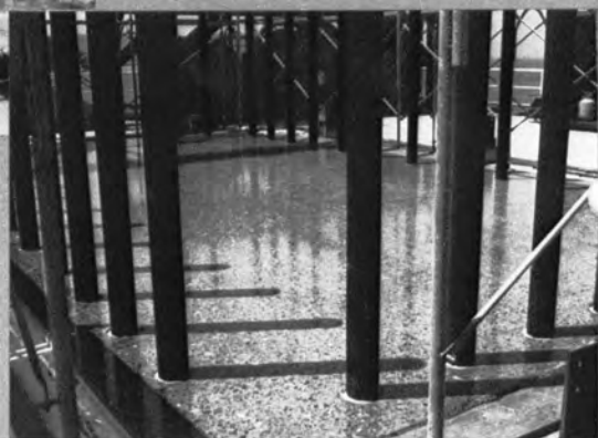
⇨ 研磨仕上げを完了したコンクリート面
