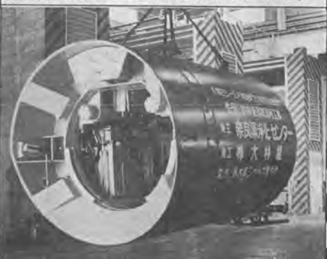
O・J手掘式シールド掘進機
