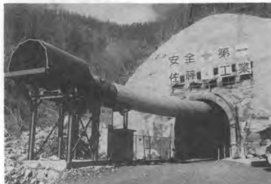
写真-8 作業坑坑口の換気設備
