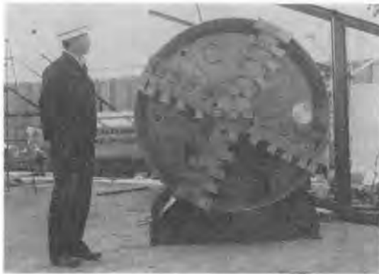
写真-2 M-2 シールド機掘削部
