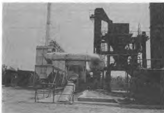
写真-10 東京工機 MTP-S 1000 アスファルトプラント
