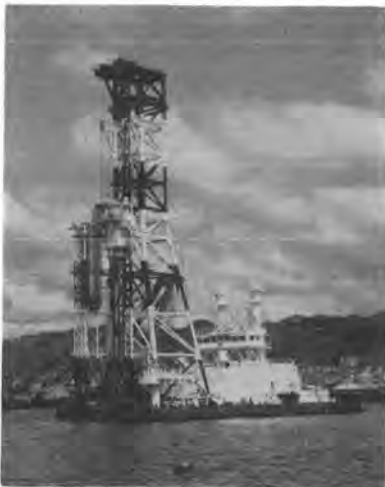
写真-5 深層混合処理船「デコム5号」
