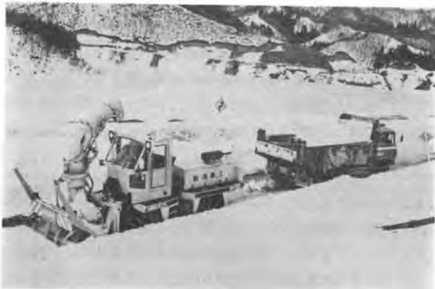
写真-9 スノーローダ（ロータリ式，新潟鉄工 NR 452）
