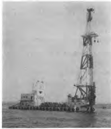
写真-3 大型杭打船「第三大都丸」
