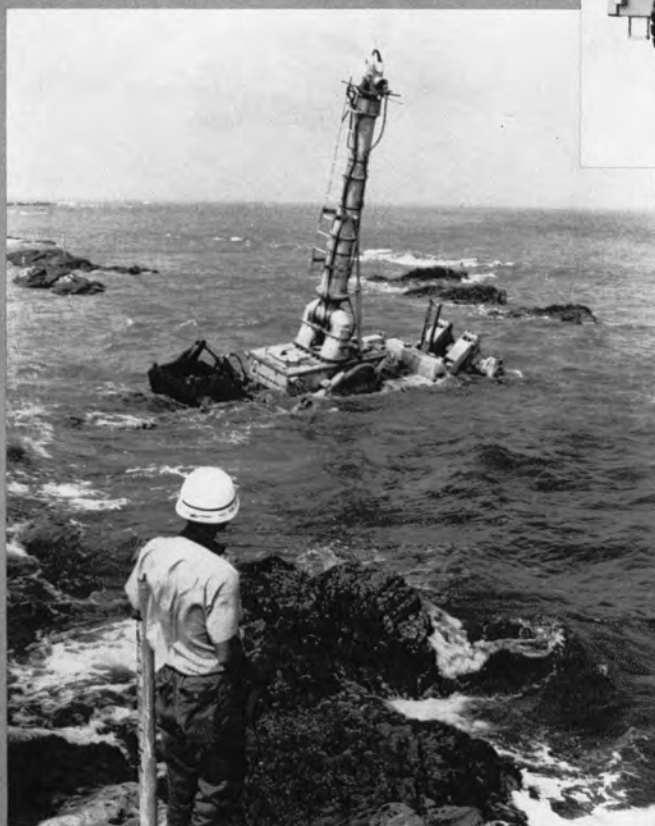
㊦ 海岸で稼働中の水陸両用ブルドーザ
