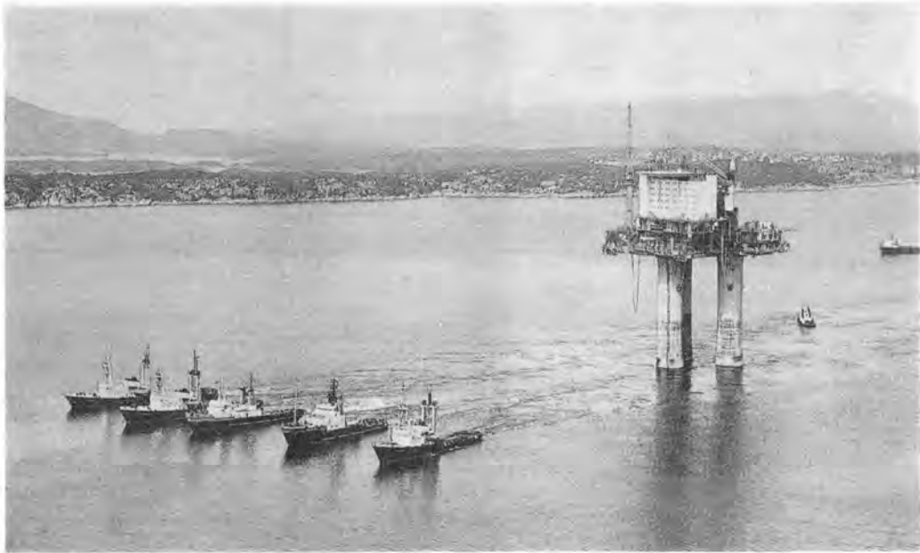
写真-3 北海へ曳航中の STATFJORD-A
