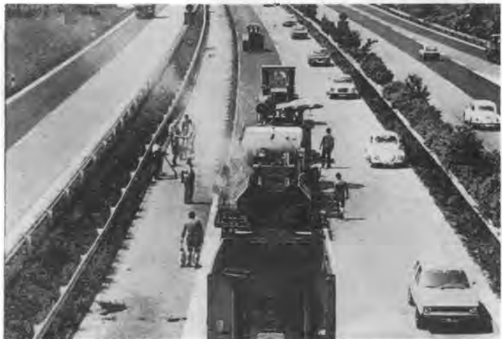
写真-2 舗装版再生機械（西ドイツ・ヴィルトゲン社）
