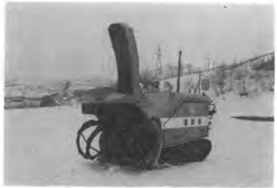
写真-12 小型除雪機(ハンドガイド式, 30 PS 級, 建設省東北技術 SC-4)
