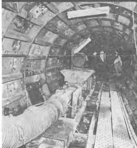
↑東京都足立区千住の管渠シールド作業現場。掘削機から送られてくる粘度の高い泥土をホッパー口に受け、坑口まで任送する2NES80型。
