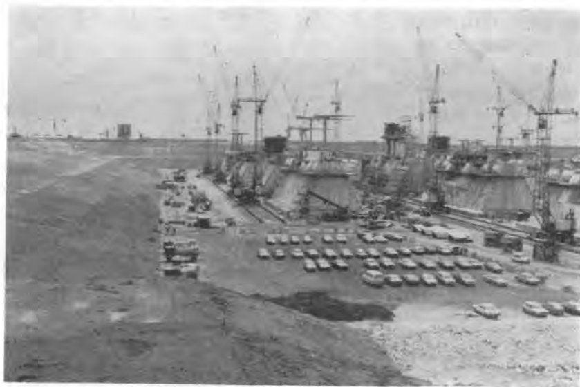
写真-5 ピア用ケーソン建造中のドライドック
