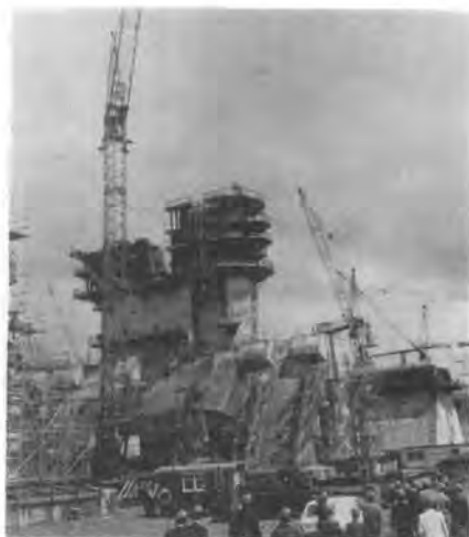
写真-4 巨大なコンクリート構造のピア用ケーソン
