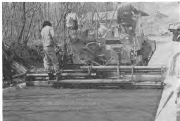
写真-1 ラックステンション付フィニッシャ(両側 80cm ぐらい張出している)
