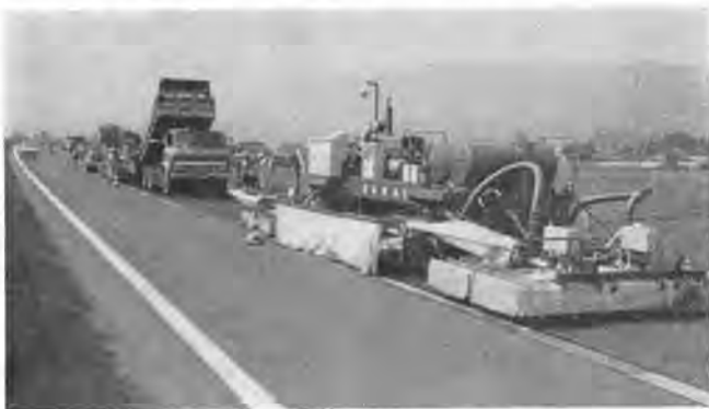
写真-1 リペービング試験工事（前方より）
