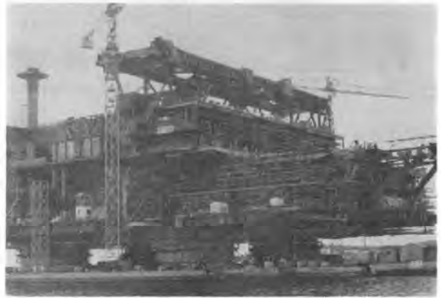
写真-2 造船所の仮受支柱上で建造中のSTATFJORD-B鋼製デッキ
