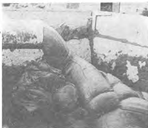
↑東京都の下水幹線工事現場。2NES100型で水平20m、垂直30m送られてホッパーに投入されるシルト (スラップ 厚10cm)
