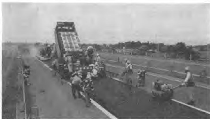
写真-2 リバーピング試験工事（後方より）
