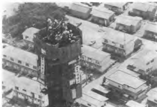
写真-5 頂部から解体開始
