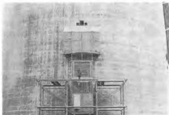
写真-4 ラック式ブラケット足場と人荷用エレベータの組立中
