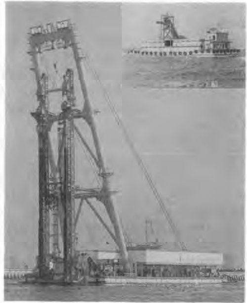
写真-5 海上施工機
