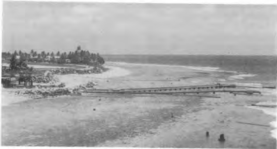
写真-1 100 kW 実証試験プラント (左端が発電プラント)
