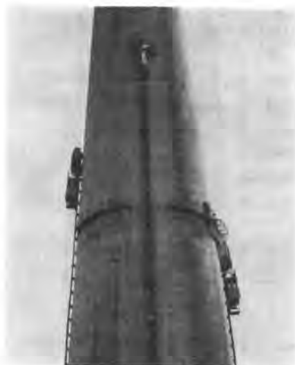
写真-3 ラック式ブラケット足場取付中
