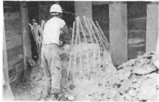
写真-20 未処理杭のはつり作業
