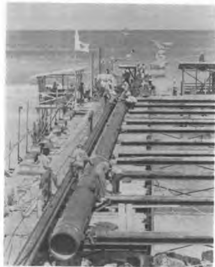
写真-4 冷水取水管の引出し状況
