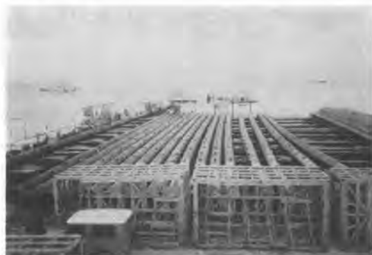
写真-2 製作完了した長管のストック状況
