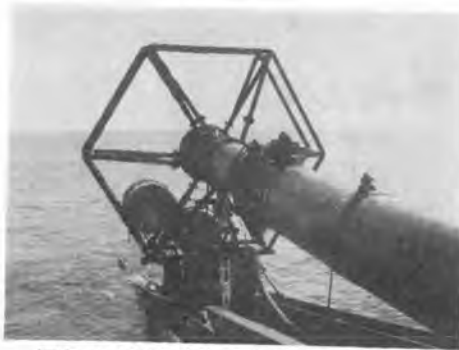
写真-3 冷水取水管の取水口部（斜路上にセットされた状態）
