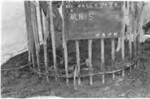
写真-19 処理杭のはつり作業
