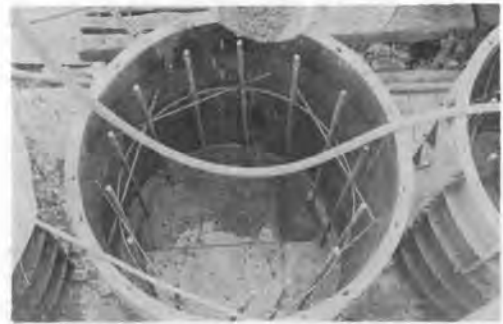
写真-8 模型杭のコンクリート打設
