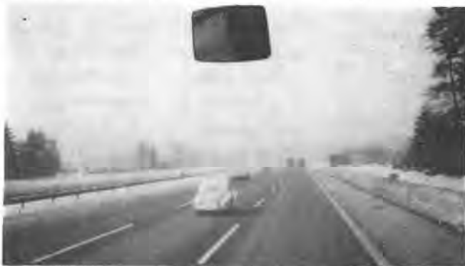
写真-1 西ドイツの高速道路の除雪状況
