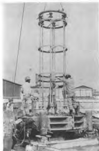
写真-16 噴射装置の建込み
