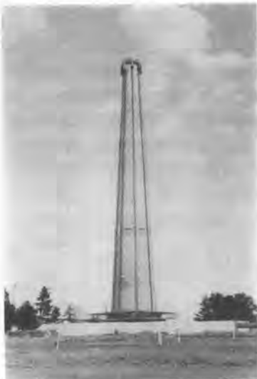
写真-2 着工後全景
