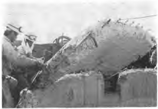
写真-6 塔体解体中
