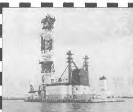
北川・深層超軟弱地盤改良処理装置
