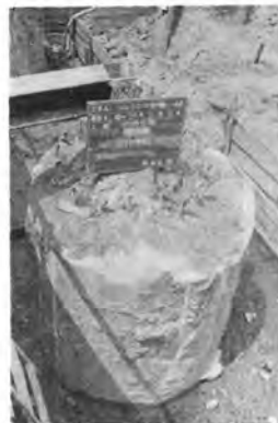
写真-6 静的破砕剤で破砕した杭
