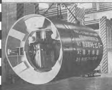
O・J手掘式シールド掘進機
