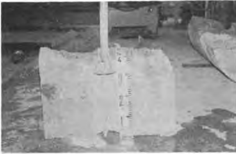
写真-4 コンクリート境界面
