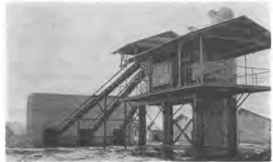
↓写真-3 コンクリートバッチャプラント（昭和56年12月末）
