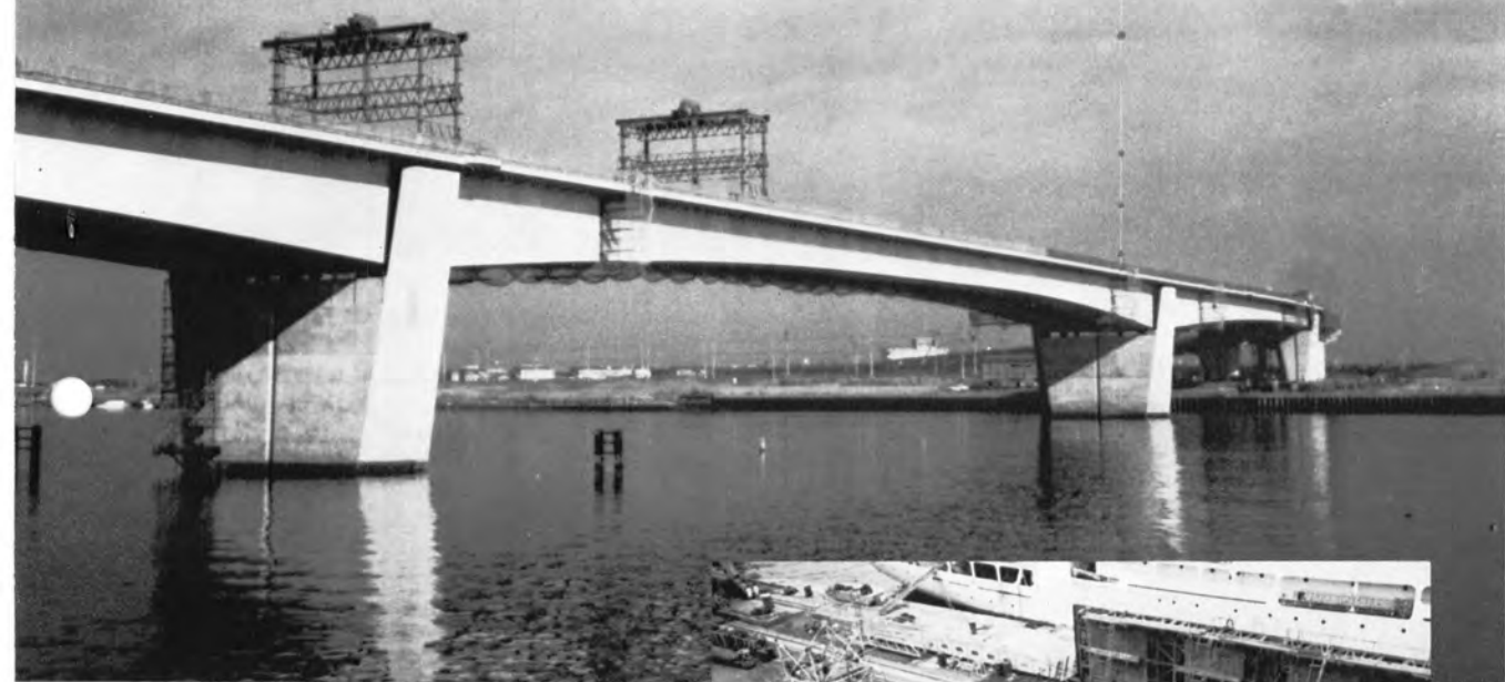
◆主桁の架設が完了した京浜運河橋
