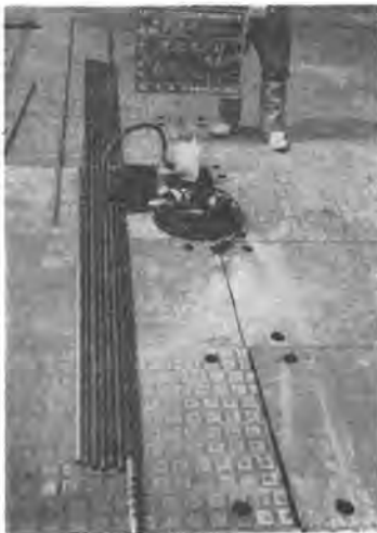
写真-1 連続沈下計
