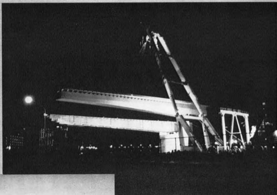
⇨ P401 ~ P402 間の No.4 ブロック架設
