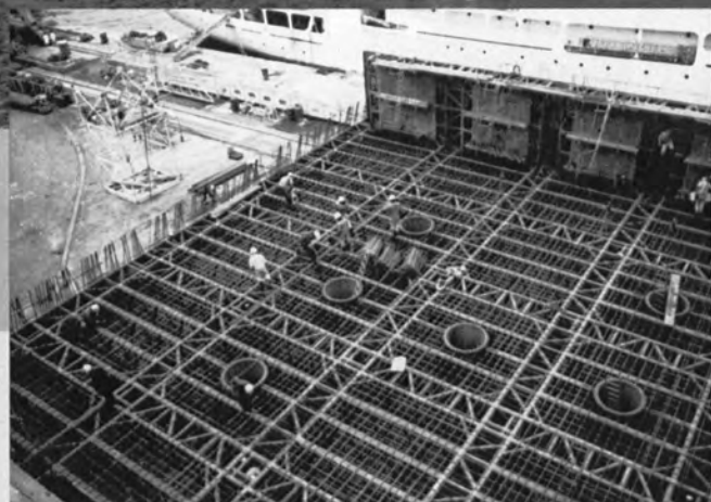
◆鋼製フローティングケーソンの工場製作
