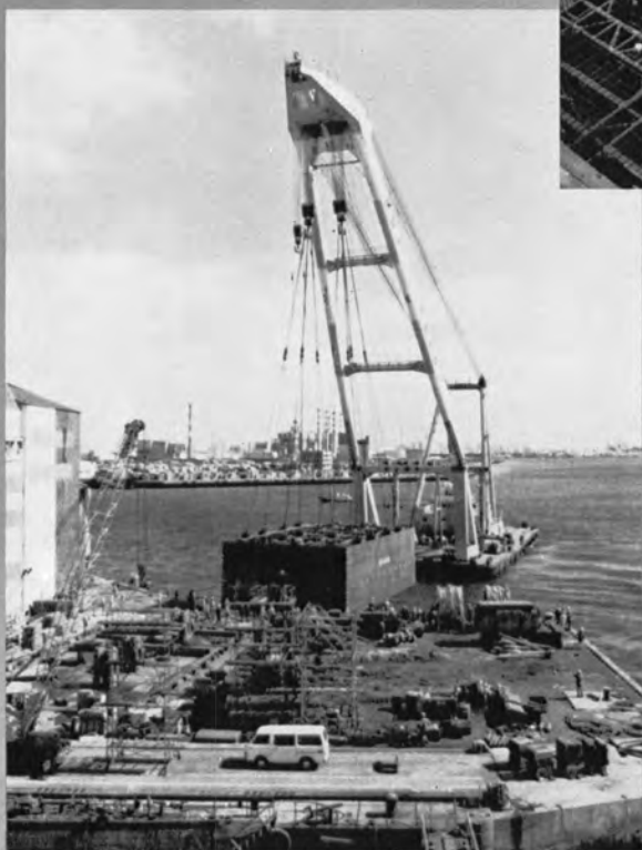
↳600 t づりクレーン船によるつり上げと着水
