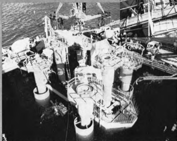
◆ピアケーソンの施工
