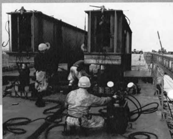
⇨ センターブロックの閉合作業
