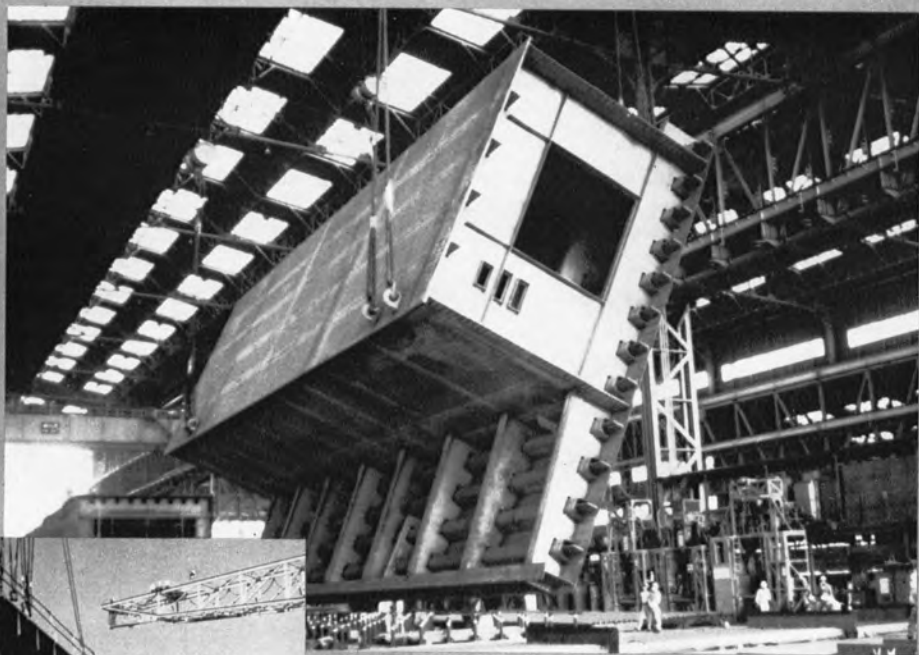
⇨箱桁製作 (約70tのブロックの反転作業)
