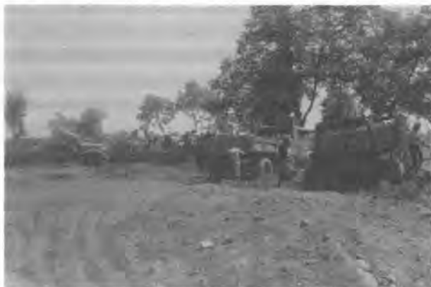
写真-1 現場仮設ヤード盛土(昭和56年1月頃。20~30年前の平ボディトラック。人力によるかき落とし)
