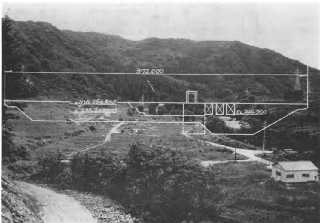
写真-1 新水ヶ湍ダム建設地点(下流側より)
