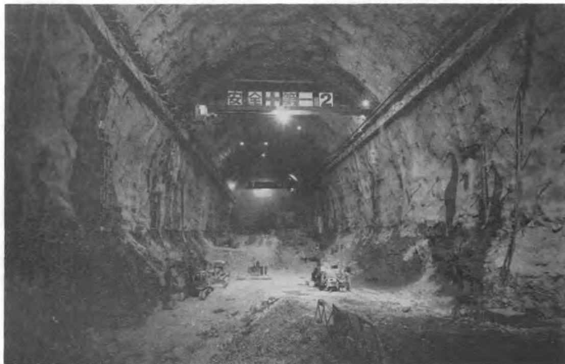
写真-1 発電所掘削状況
