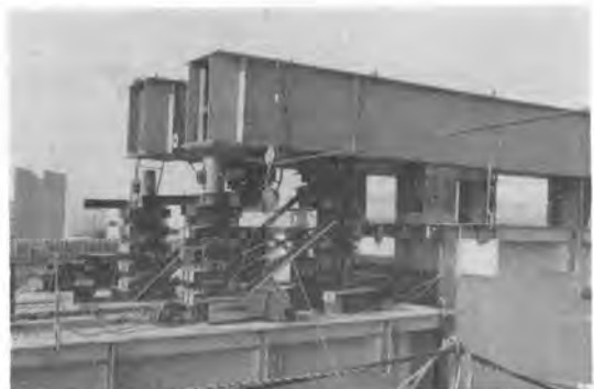
写真-4 セッティングガーダとジャッキ操作作業
