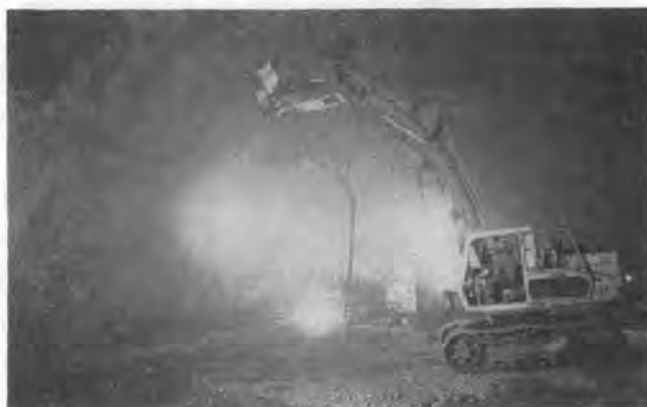
写真-3 コンクリート吹付ロボット
