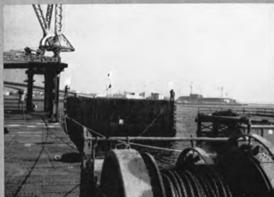
◆栈台へ押込まれるケーソン
