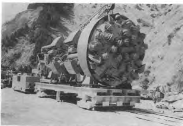
写真—1 仮組みされたパイロット機
