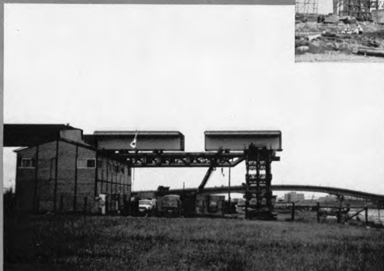
⇨G 9 と G 8 桁の縦引き作業
