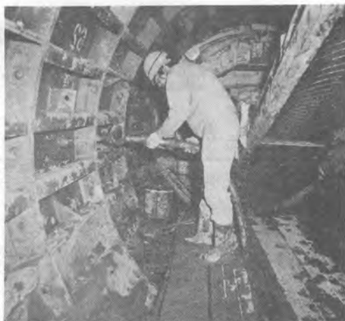
↑大阪府のKシールド作業現場、約一・二kmはなれたハイシンモノノポンプから送られてくるエアモルタルと凝結剤をセグメント裏に混合注入している。
