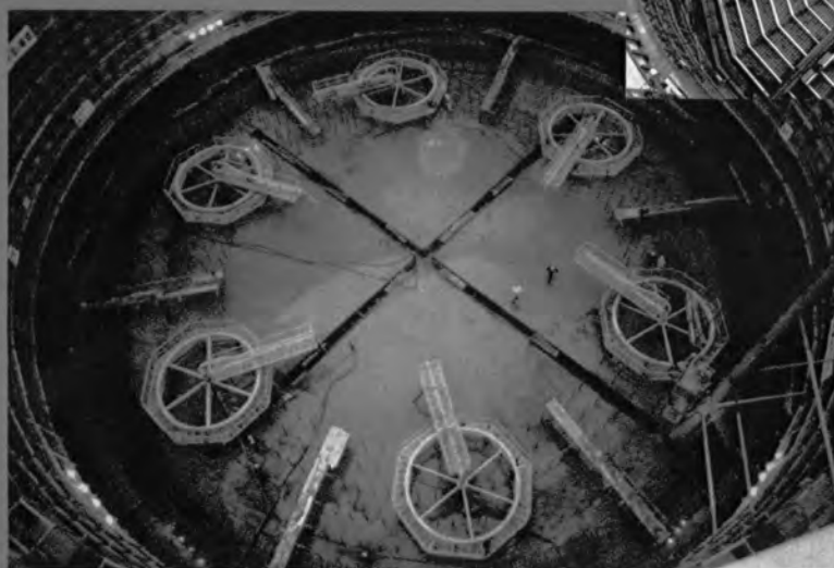
◆底版コンクリート打設機
