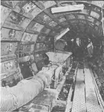
↑東京都足立区千住の管渠シールド作業現場。掘削機から送られてくる粘度の高い泥土をホッパー一口に受け、坑口まで圧送する2NES80型。
