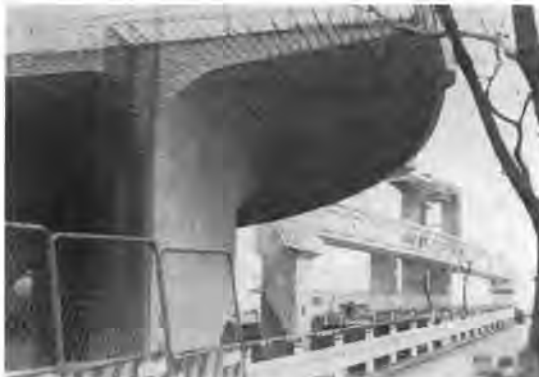
写真-4 外装を施した構造物外観
