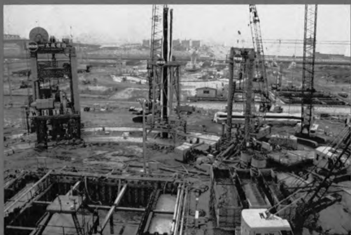
◇連続地中壁施工 (WH 工法)
