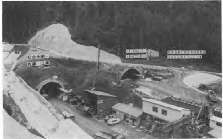
写真-1 トンネル坑口全景
