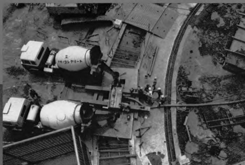
連続地中壁 コンクリート打設
