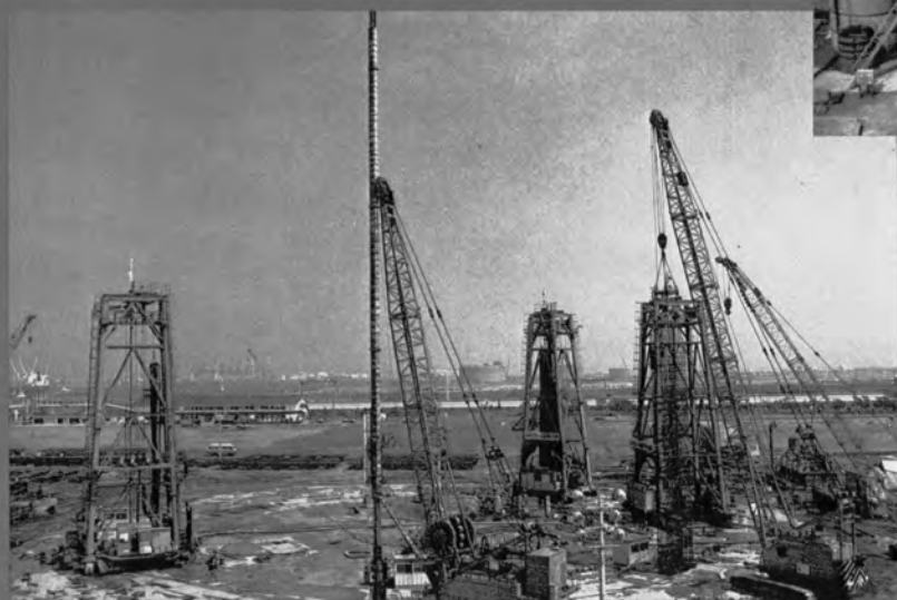
◇連続地中壁施工 (OWS-SOLETANCHE 工法)
