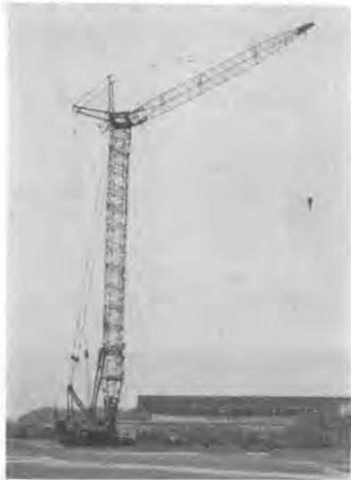
写真-7 石川島 CCH 1500 タワークレーン
