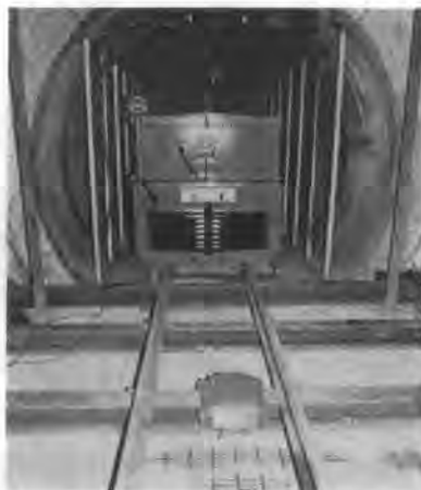
写真-3 永久磁石の設置状況
