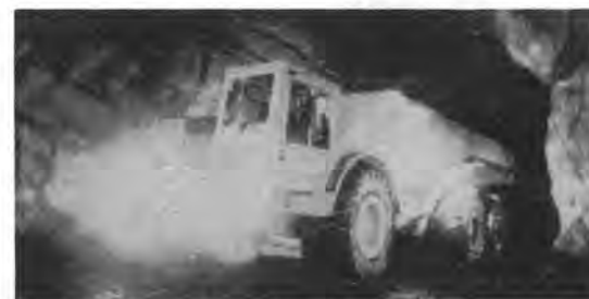
写真—4 低床式によるトンネル内作業
