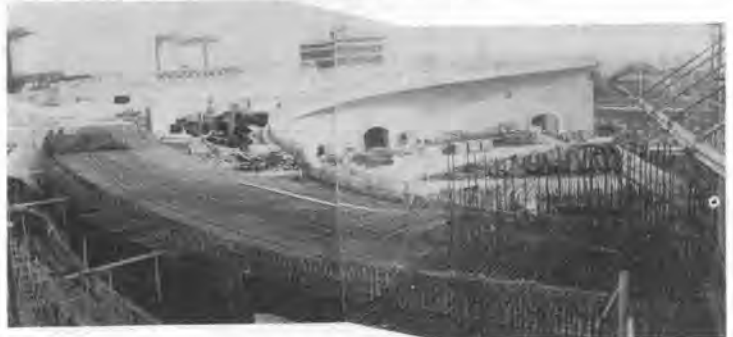
写真-3 床版の配筋状況
