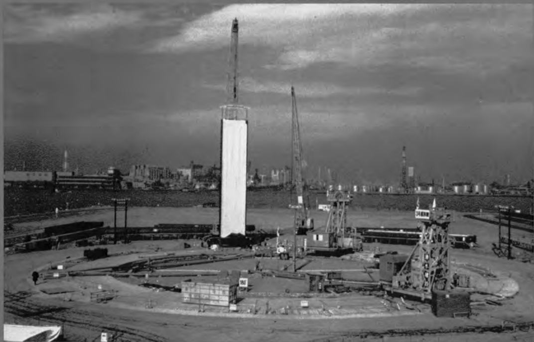
◇連続地中壁施工 (SSS 工法)
