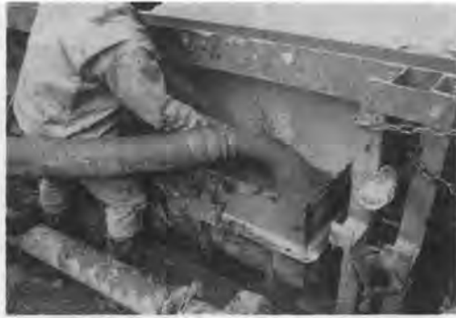
写真-1 側壁コンクリート打設
