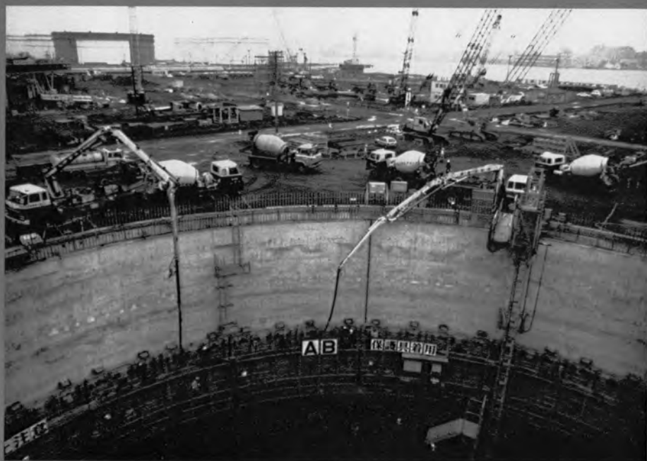
⇨側壁コンクリート打設
