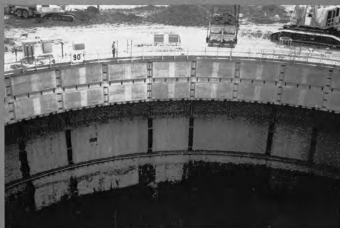
連続地中壁面および側壁第1段
