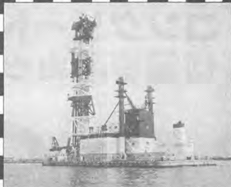
北川・深層超軟弱地盤改良処理装置
