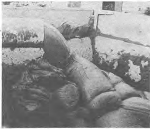
↑東京都の下水幹線工事現場。2NES100型で水平20m、垂直30m送られてホッパーに投入されるシルト (スランプ 直径10cm)
