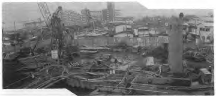
写真-2 基礎杭の施工状況
