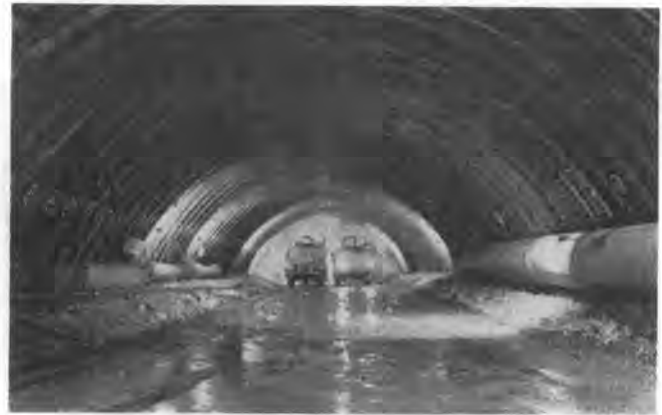
写真-2 上半掘削
