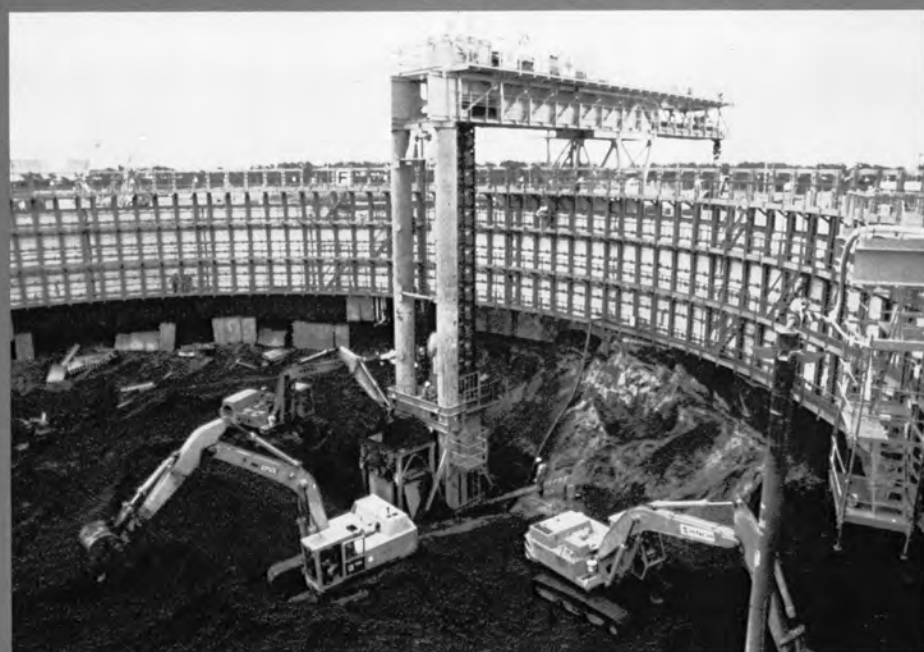
掘削土搬出機 (ユニバーサルトレイリフト)
