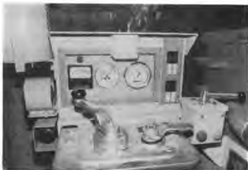
写真-2 運転操作部
