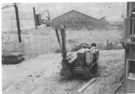
写真-29 コンクリート吹付ロボット
