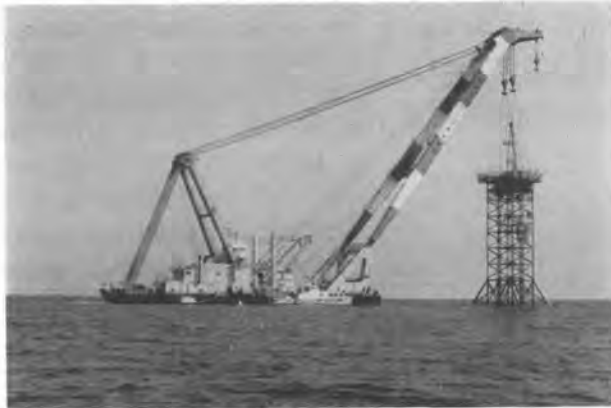
写真-1 足場やぐらの移動
