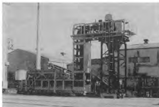
写真-8 掘削土排出用垂直搬送機
