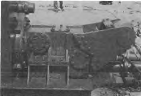
写真-20 小口径れき泥水シールド用クラッシャ
