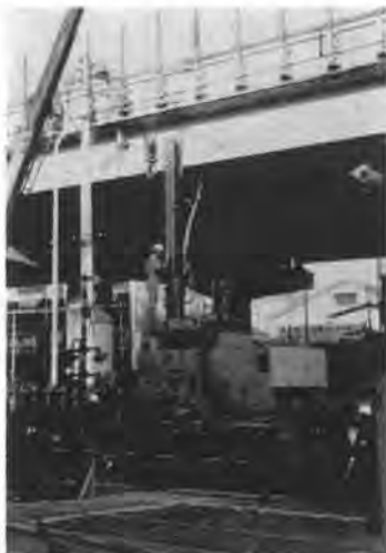
写真-5 無振動・無騒音杭圧入機
