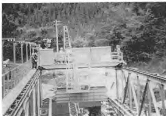
写真-15 高速排土装置
