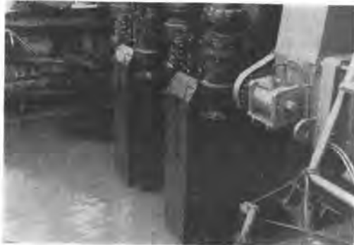
写真-2 方向制御板取付状況
