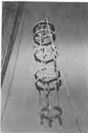
写真-10 杭頭処理装置
