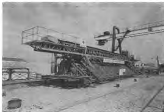
写真-32 コンクリート表面遮水壁舗設機
