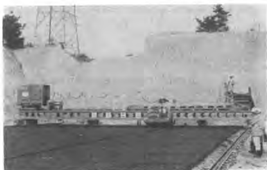
写真-37 テニスコート舗装用機械
