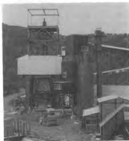
写真-14 立坑開削設備
