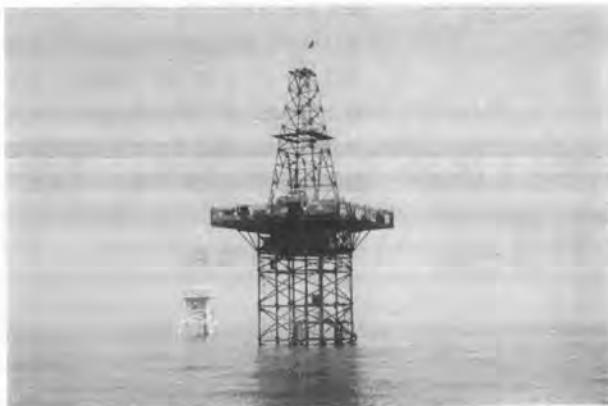
写真-2 足場やぐら据付後の状況
