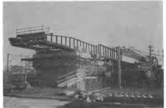
写真-24 RS 押し出し工法
