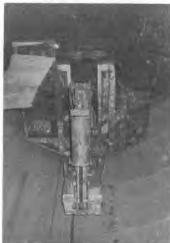
写真-13 懸垂式立坑ずり積込機
