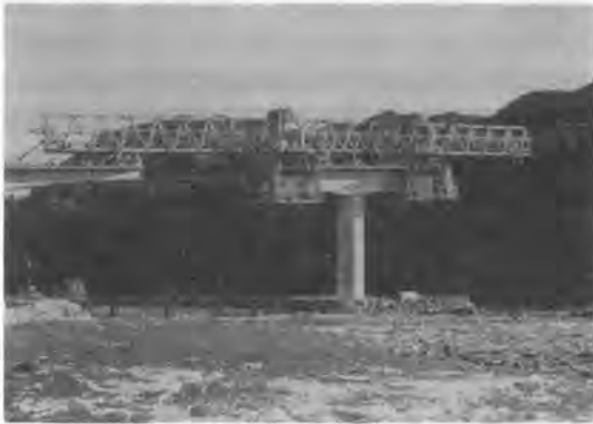
写真-23 P & Z 移動支保工装置
