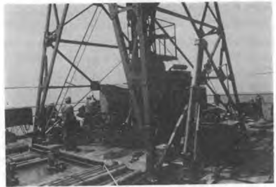
写真-3 上段ステージの状況
