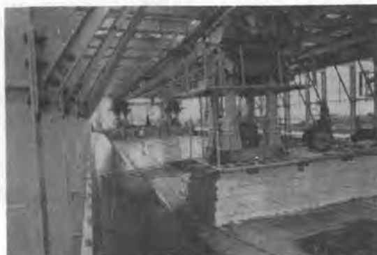
写真-4 工程⑦の状況 (移動つり支保工および型枠セット完了)
