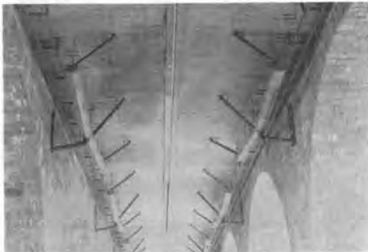
古い橋梁の補強工事(裏側)
