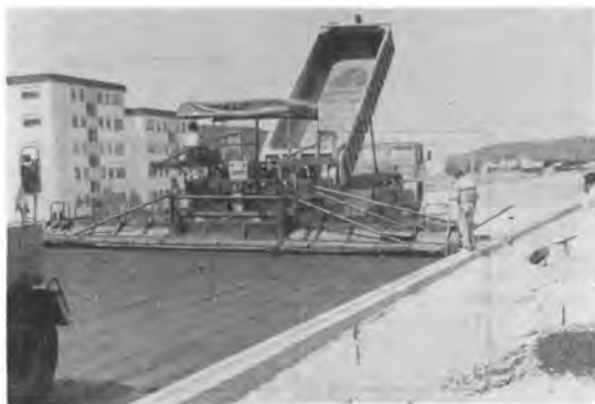
アウトバーン路盤舗装工事
