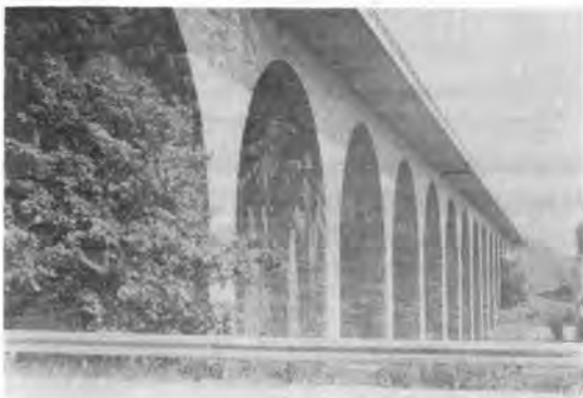
古い橋梁の補強工事(外観)
