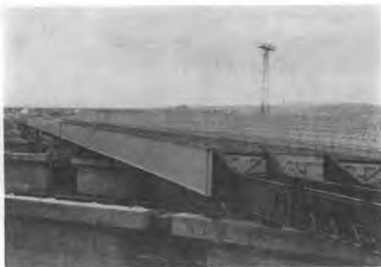
写真-8 第2回桁送出し作業状況
