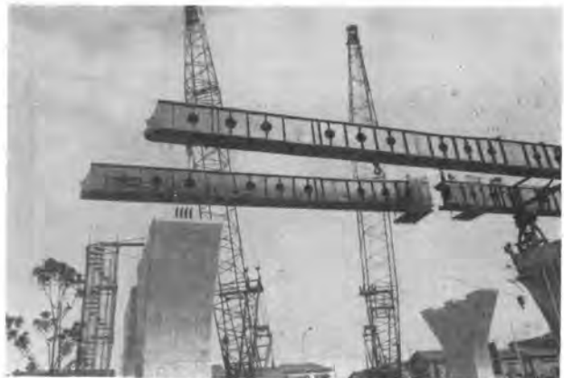
写真-7 メインガーダ組立中の1号機
