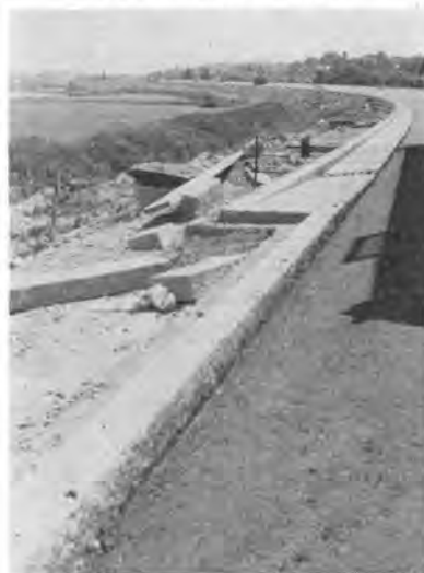
アウトバーンの天然石の縁石
