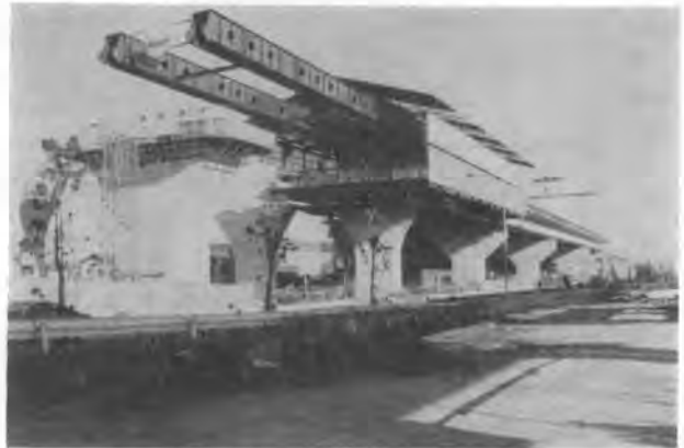
写真-1 移動つり支保工1号機
