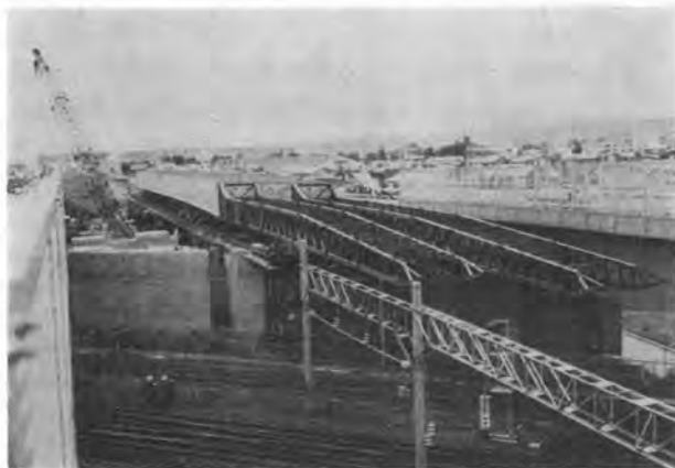
写真-7 下り線第1回桁送出し状況
