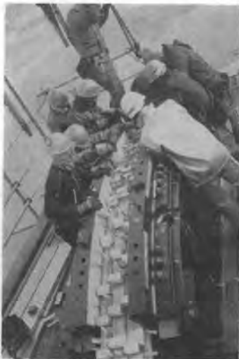
写真-4 塔部サドル (ケーブル整形作業)
