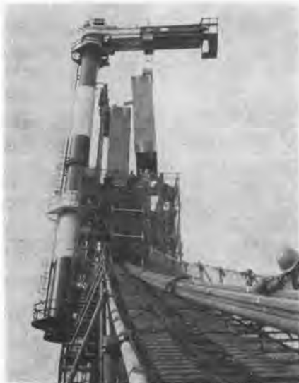
写真-6 クリーバクレーンによる塔架設
