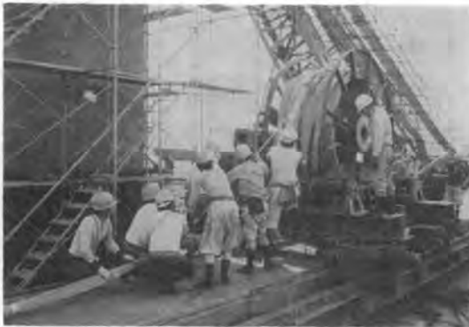
写真-3 ケーブル (PWS 217) 展開作業
