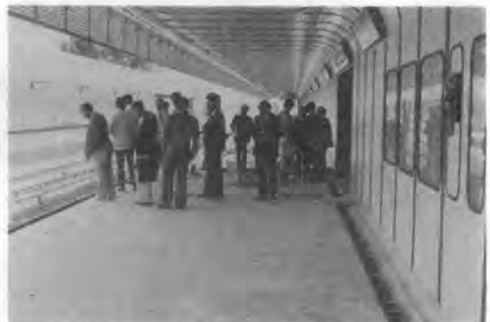
ウィーン市地下鉄建設中の駅部見学
