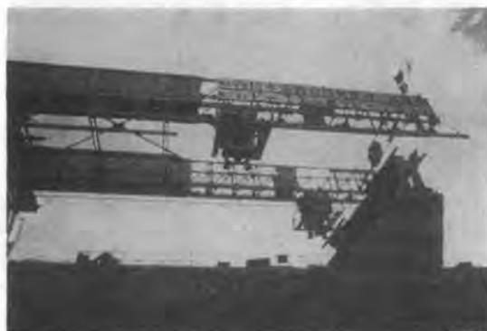
写真-3 工程⑥の状況 (前方支持台 R 1 の移動)
