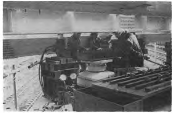
写真—4 すべり装置による桁送出し作業
