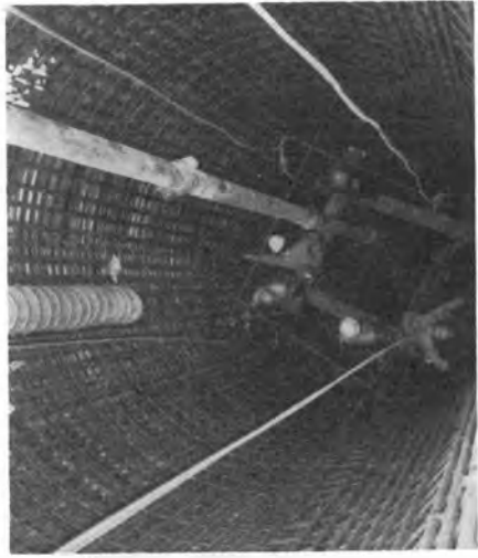
写真-4 中詰コンクリート打設状況
