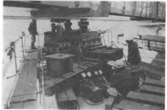
写真-2 送出し装置による桁送出し作業
