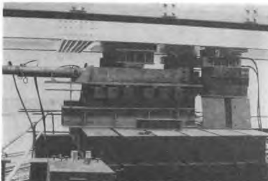
写真-1 送出し装置
