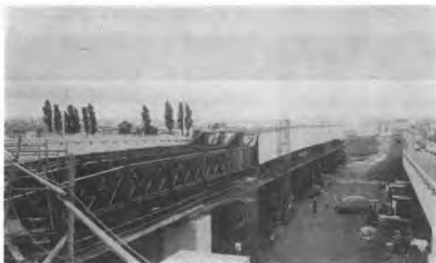
写真-6 上り線第1回送出し分析組立完了
