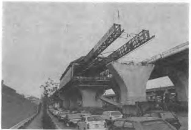
写真-2 移動つり支保工2号機
