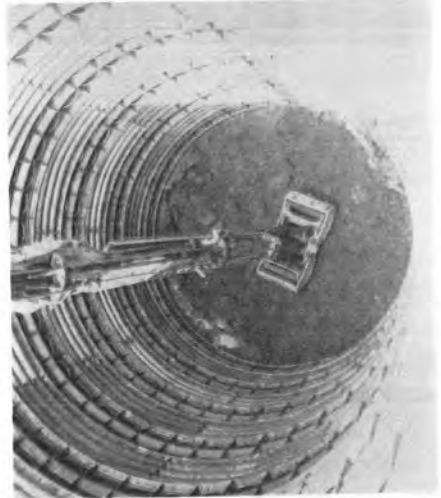
写真-3 孔内の掘削状況
