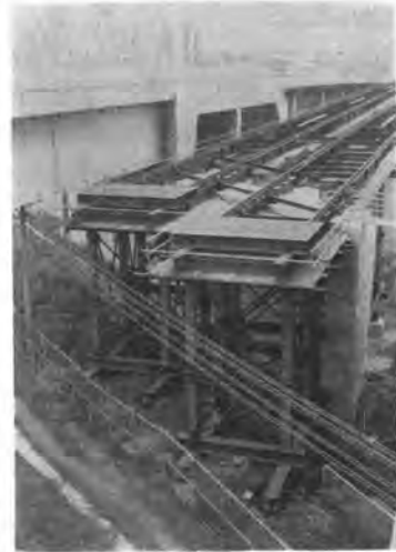
写真—5 上り線仮設ステージング組立完了状態
