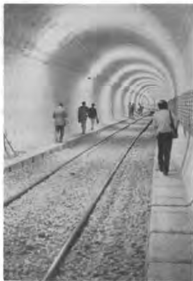
ミュンヘン市地下鉄工事見学
