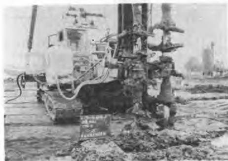
写真-2 同上地盤改良工(その2)
