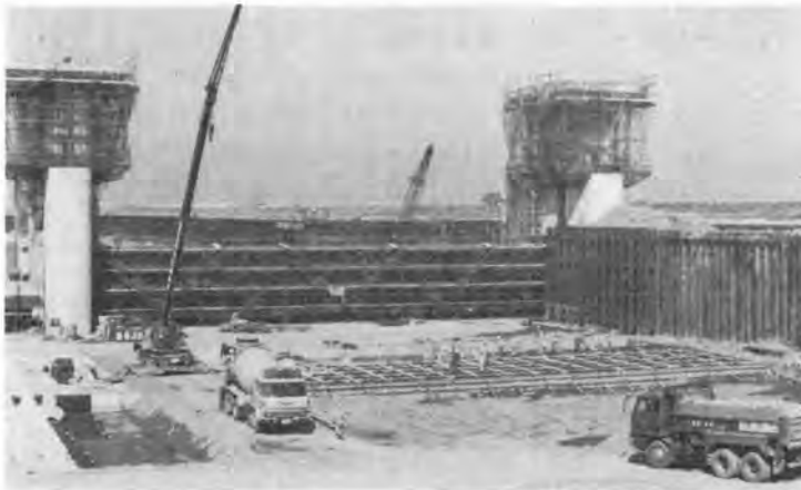
写真—4 筑後大堰工事状況
