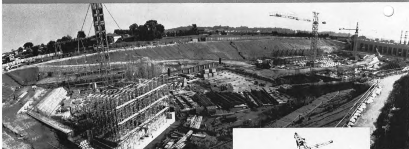
⇨ 調圧水槽および沈砂池の構築
