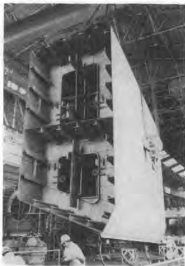
写真-1 扉体中央ブロック仮組み
