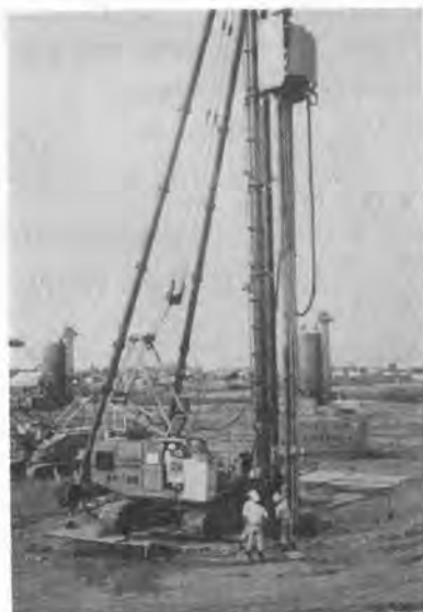
写真-1 深層攪拌混合工による地盤改良工 (その1)
