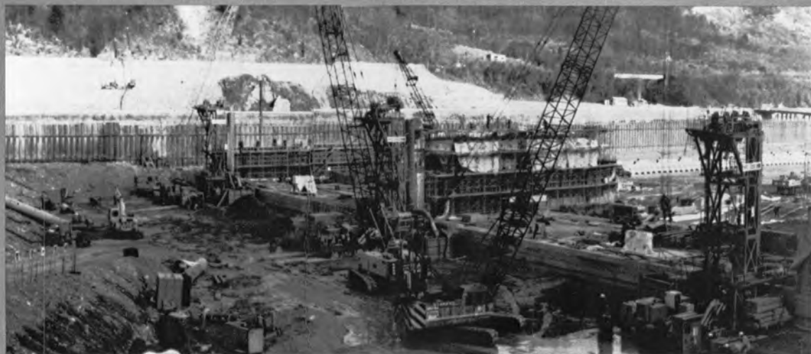
♡止水矢板建込みに先だって上質土と置換えるための重錘掘削作業
