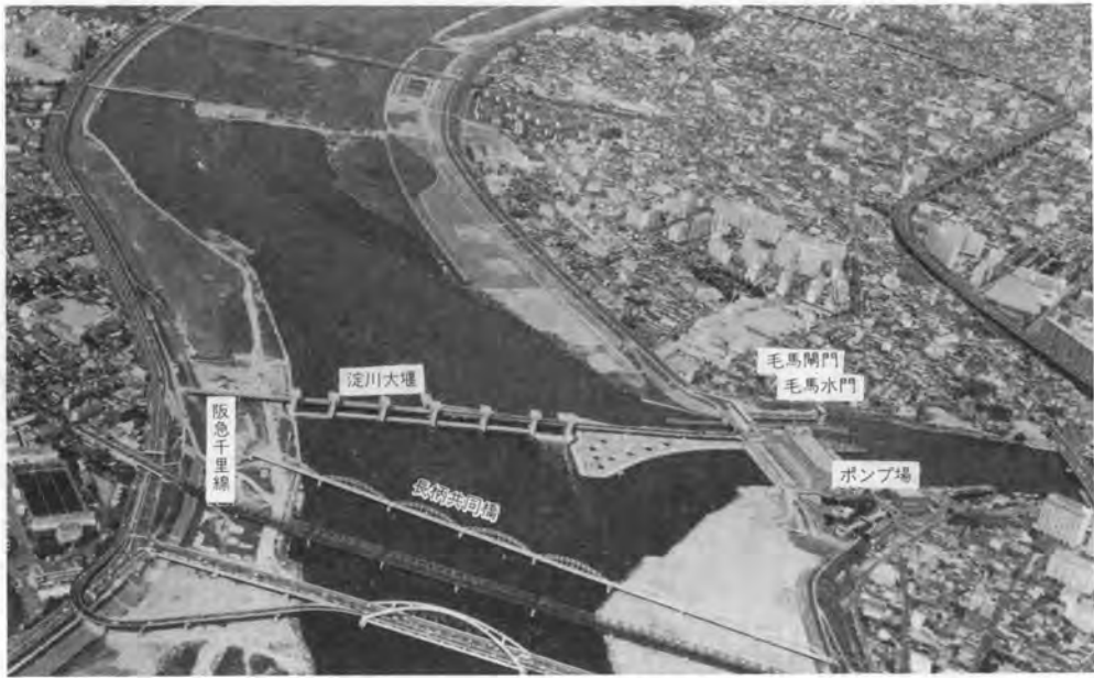
写真-1 上空より淀川大堰関連施設を見る
