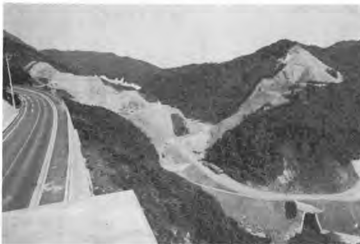
写真-2 上流より掘削中のダムサイトを望む
