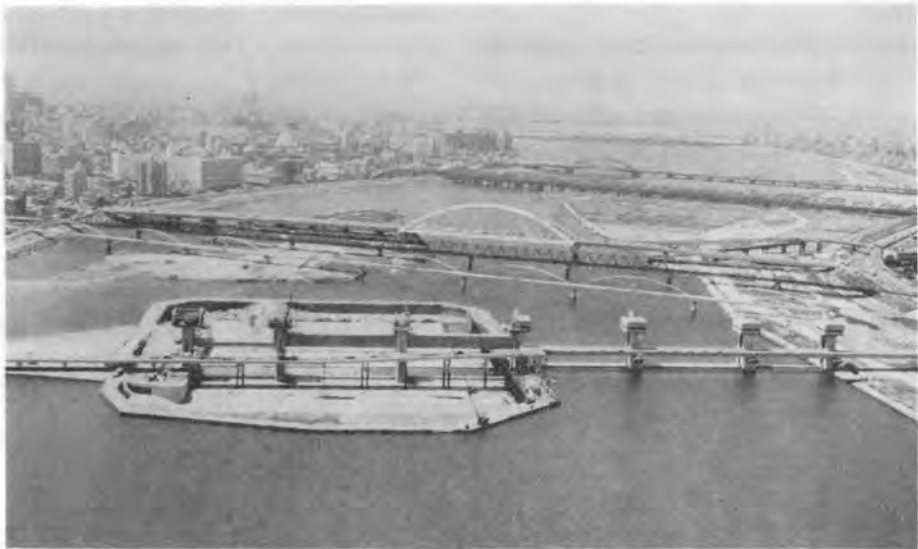
写真-2 完成間近な淀川大堰（上流側より下流を見る）
