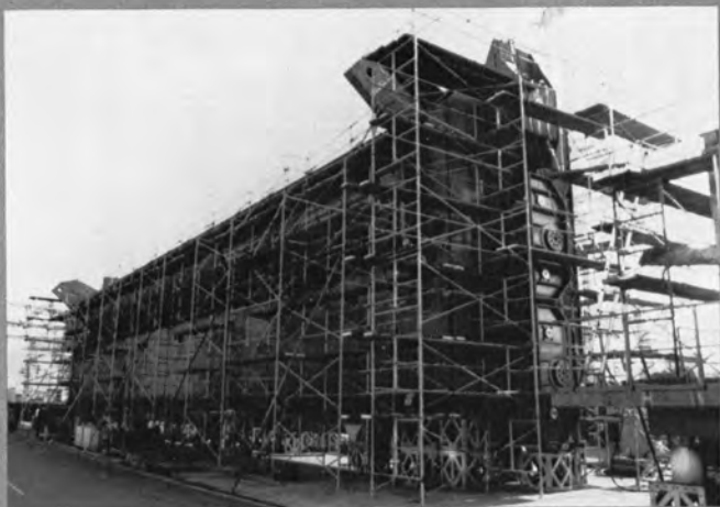
⇨調節ゲートの工場仮組み
