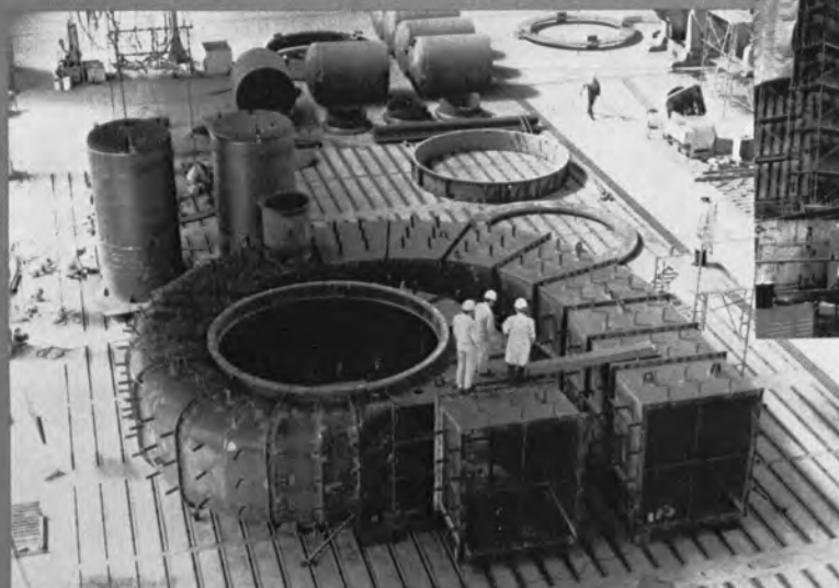
⇨ 30 \text{ m}^3/\text{sec} ポンプポリュートケーシングの工場仮組み
