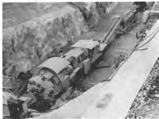
写真-8 香川用水工事に使用されたトンネルボーリングマシン
