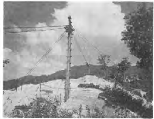
写真—6 ケーブルクレーンの揺動塔
