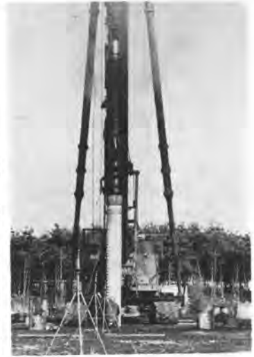
写真2 ディーゼルハンマ (IDH-35) の試験状況
