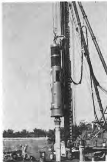
写真1 油圧ハンマ (HNC-80) の試験状況
