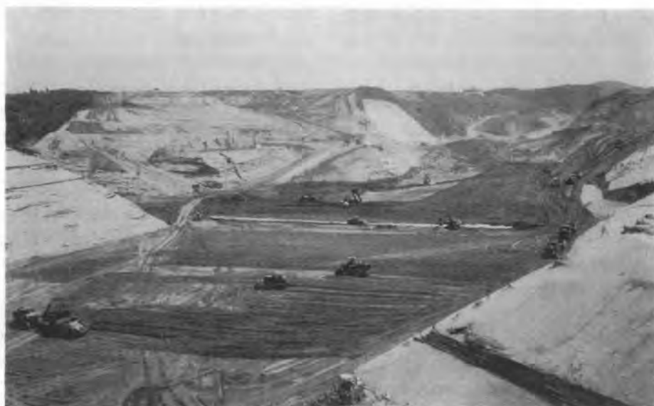
写真-1 長柄ダムの工事状況
