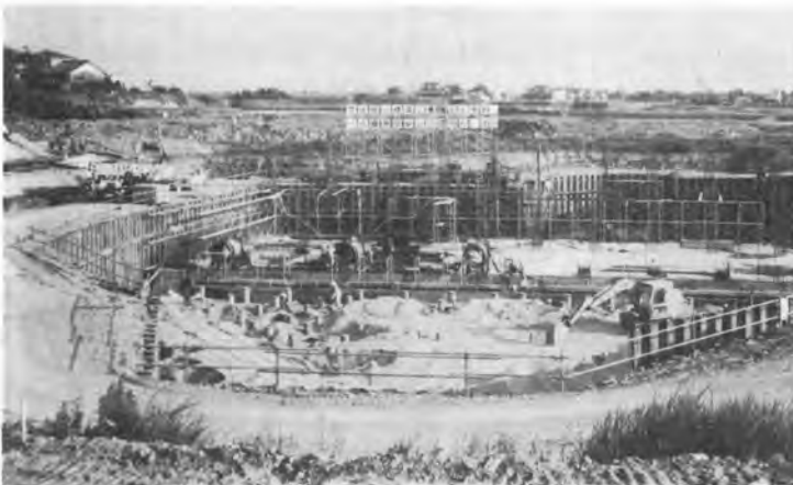
写真—5 筑後揚水機場工事
