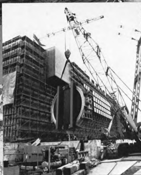
⇨ \phi 5,400 mm 吐出合流管用弁の機場つり込み
