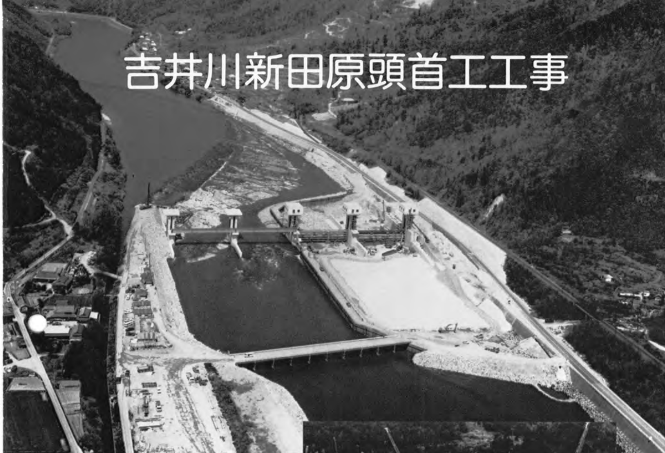
◆吉井川新田原頭首工工事全景
