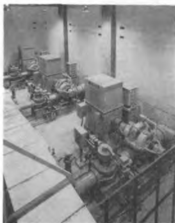
写真-2 東庄揚水機場の一部
