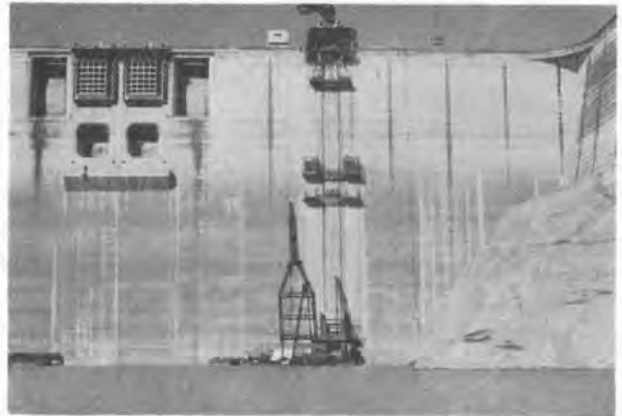
写真-10 表面取水設備の据付工事
