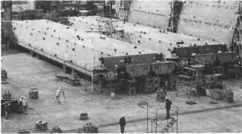
写真-3 扉体仮組み検査
