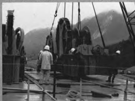
⇨ピア上への巻上機の据付
