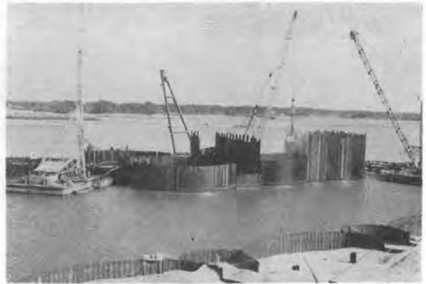
写真-9 利根河口堰工事のセル施工状況
