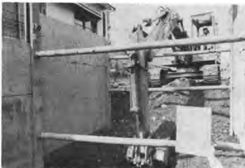
写真-5 掘削状況
