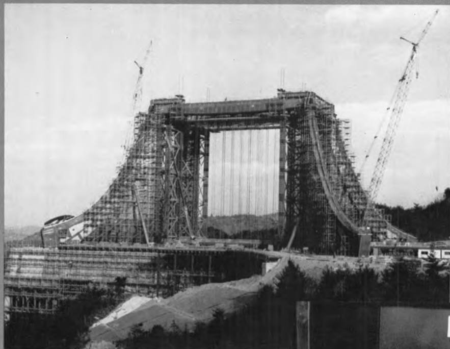
⇨リフトアップ完了
