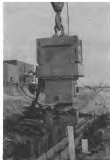
写真-1 試験施工状況
