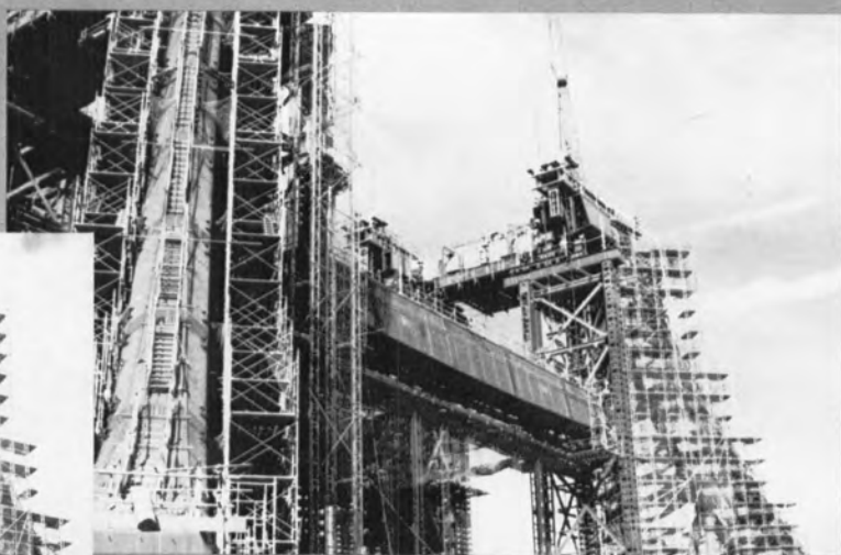
⇨トップガーダのリフトアップ作業
