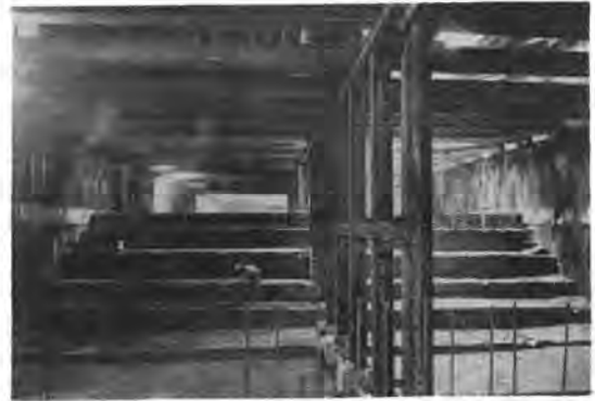
写真—4 埋戻し工事状況
