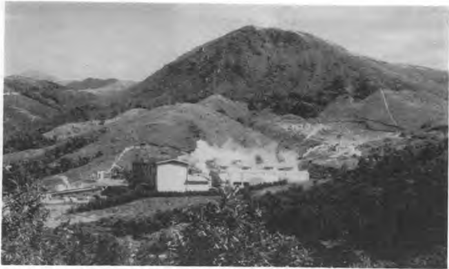
写真-1 八丁原発電所全景
