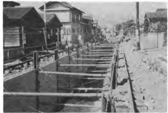
写真-6 土留工完了
