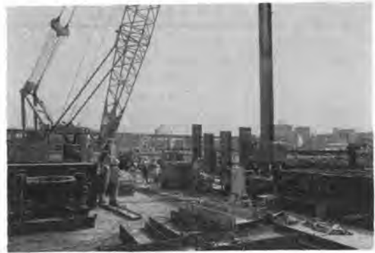
写真-2 H鋼回収引抜状況
