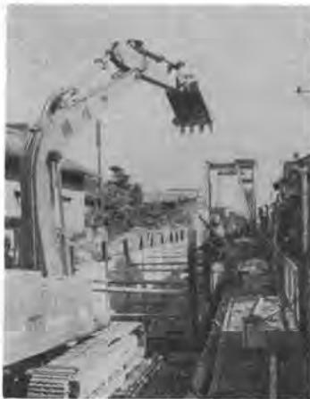
写真-4 上部パネルたて込み
