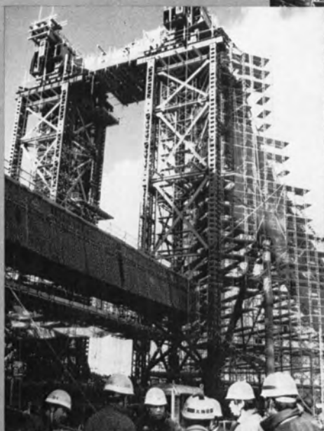
⇨リフトアップ第2段階
