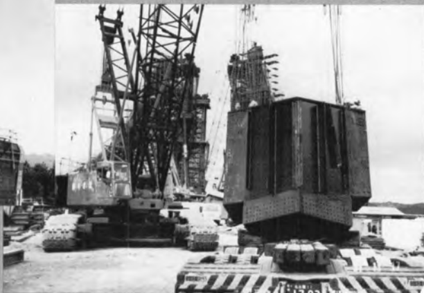
⇨大型クレーンによる柱頭ブロックつり込み
