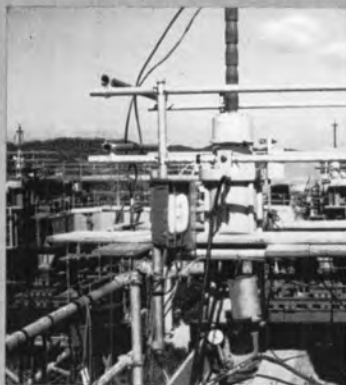
⇨リフトジャッキの取付
