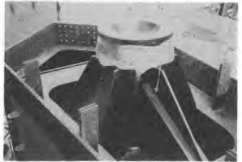
写真-2 柱頭ブロックを受けるピン受座
