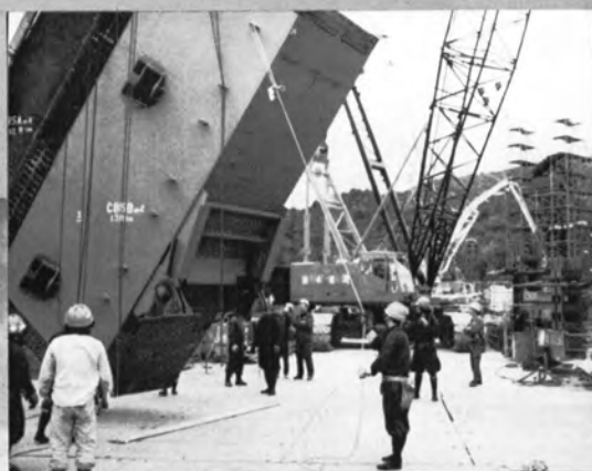
◆コーナーバットレス 中間ブロックつり上げ
