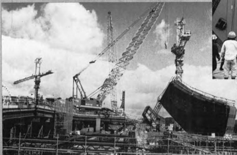
◆大型クレーンによる コーナーバットレス据付
