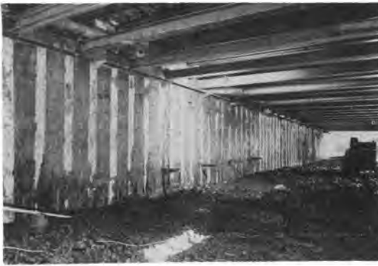
写真-1 H鋼ソイルモルタル土留壁
