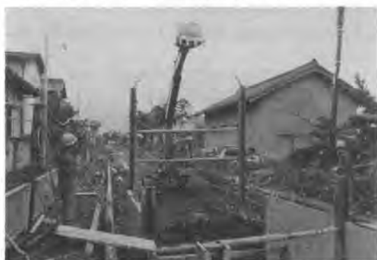
写真-3 ガイドレールたて込み
