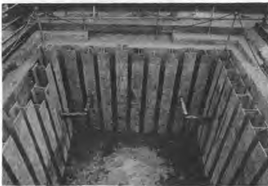
写真-3 ラップPIPで施工した立坑
