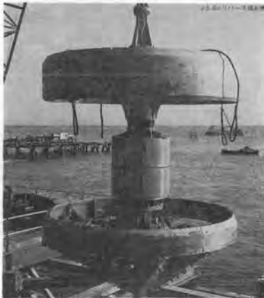
写真-3 S 600 リバース掘削機
