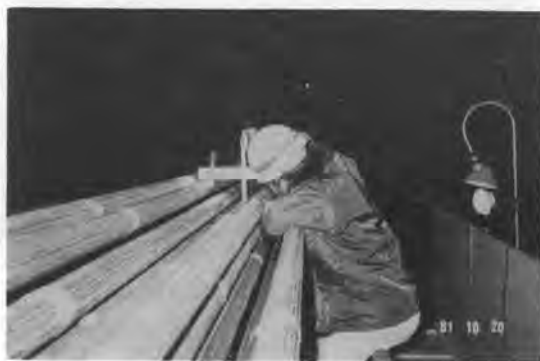
写真一8 ストランドのサグ調整
