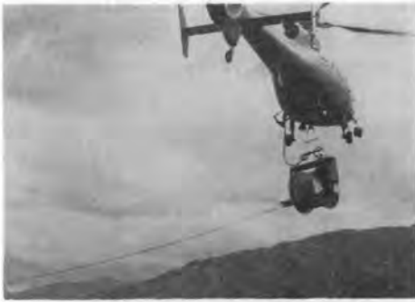
写真-3 ロープ延線 (その1)
