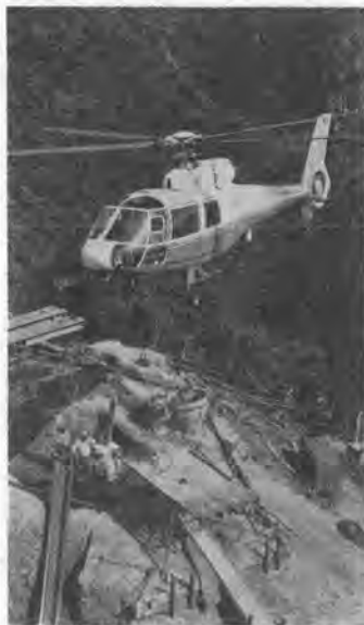
写真-1 鉄塔の基礎の生コン打設
