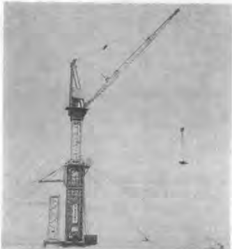
写真-10 日立 CT 36 鉄塔建設用クライミングクレーン
