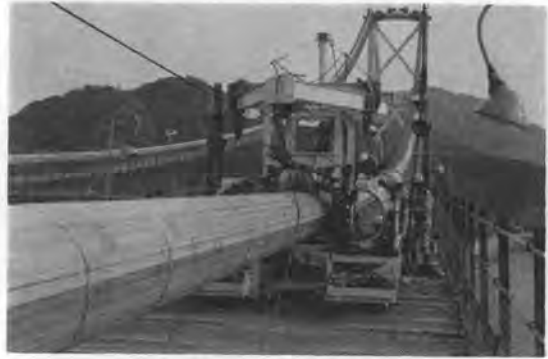
写真-12 ケーブルバンドの架設
