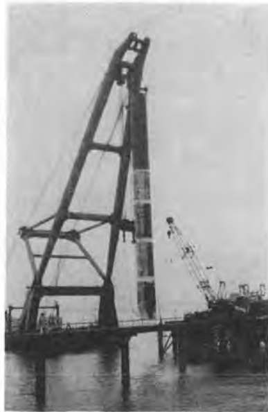
写真-4 本管建込み
