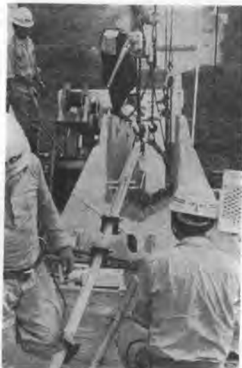
写真一7 ストランドの整形
