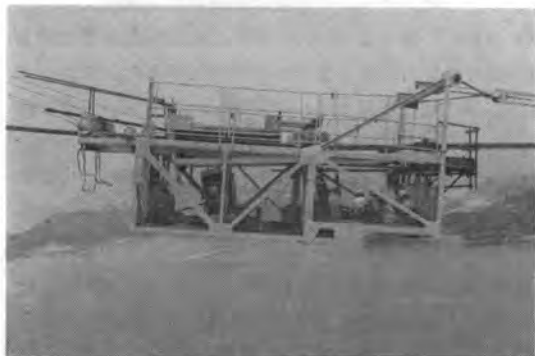
写真-2 架設台車工法
