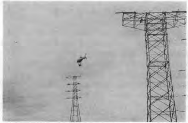
写真-4 ロープ延線 (その2)
