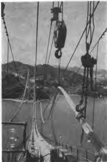
写真一6 ストランドの仮引き
