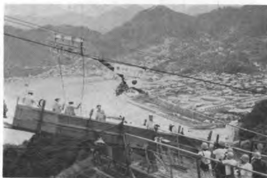
写真-5 ストランドの引出し
