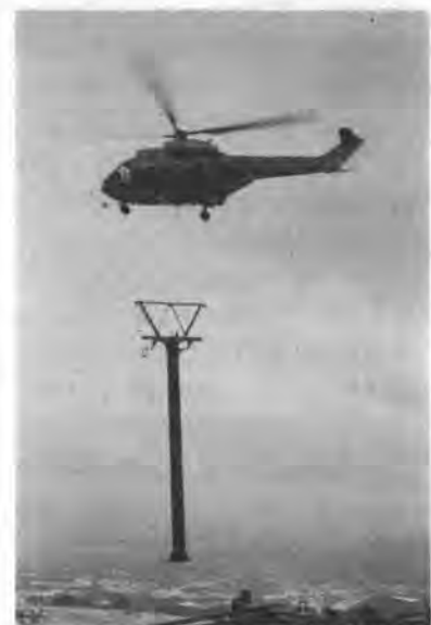
写真-2 スキーリフトのマスト運搬(2.5t)
