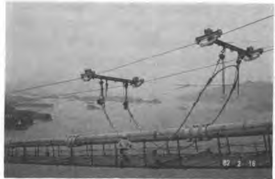
写真-14 ハンガーロープの架設
