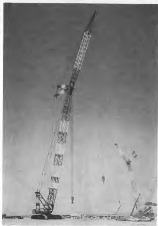
写真-1 5650型大型クローラクレーン
