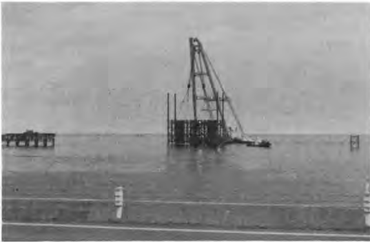
写真-1 海上作業床の据付
