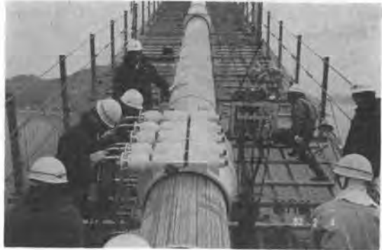
写真-13 バンドボルトの締付
