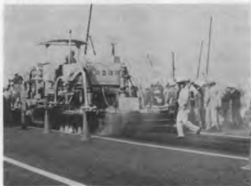
路上表層再生処理工法の実演
