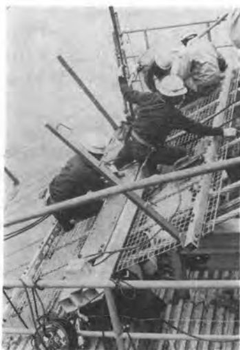
写真-1 滑り出し工法
