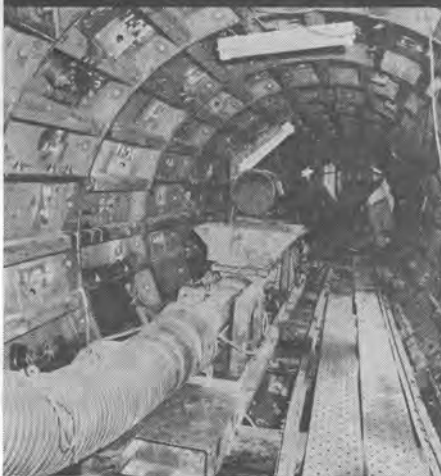
↑東京都足立区千住の管渠シルド作業現場。掘削機から送られてくる粘度の高い泥土をホッパー口へ受け、坑口まで圧送する2NES80型。
