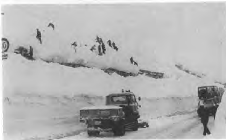
写真-2 防雪柵上の積雪・雪庇の人力除去
