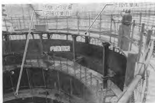
写真-2 内張鋼板建込状況
