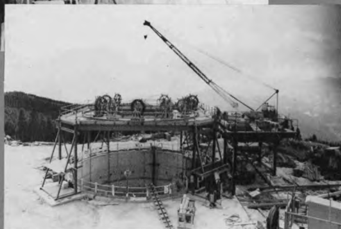
導水路サージタンク型枠スライド設備▶
