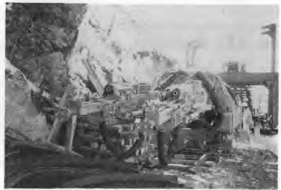
写真-3 油圧式 2 boomガントリー式ジャンボ (2号下口)
