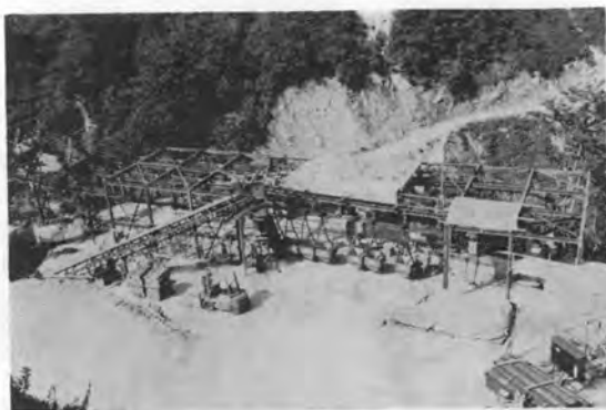
写真-3 目附谷線山麓停留所
