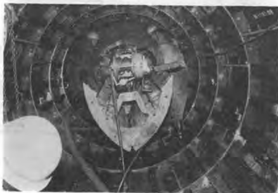
写真-3 インバートフォームのセット (φ1,500mm)
