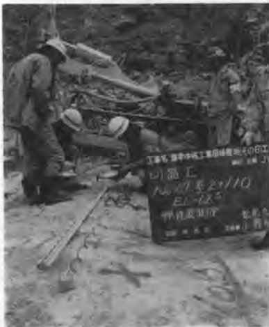
写真一2 弾性波測定状況
