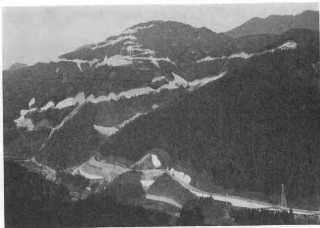
写真-1 上下間連絡道路（工事中）
