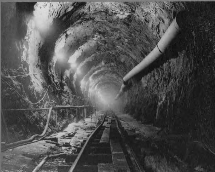
⇨ 放水路トンネル掘削
