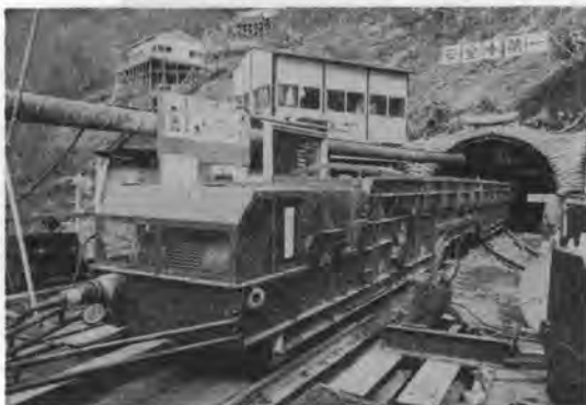
写真-5 2号下口におけるシャトルカー
