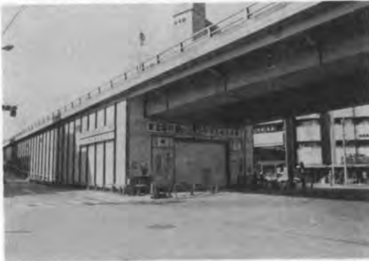
写真-3 現場外形
