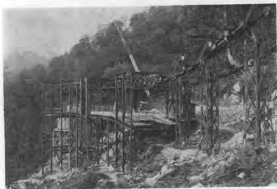
写真-2 目附谷線キワダラ谷中間停留所
