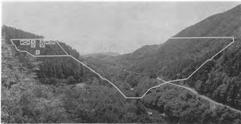
写真-1 ダムサイト下流より望む
