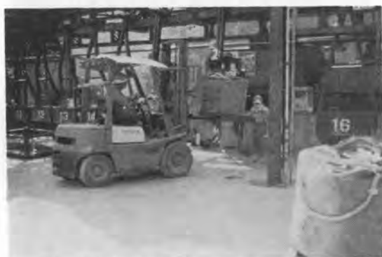
写真-5 同上セメント荷積み作業状況
