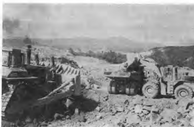
写真-1 ショベル・ダンプによる積込作業(集土量は86t級)
