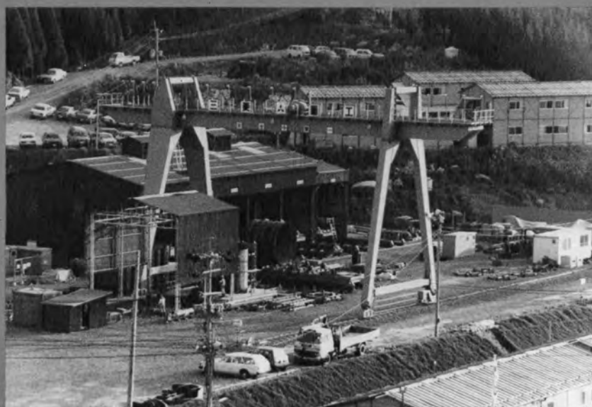
◀ 水圧鉄管仮工場
