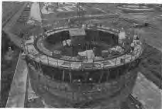
写真-3 スリップフォーム構台
