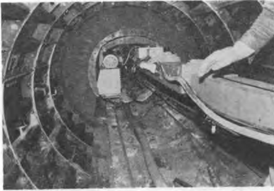
写真-4 クラウン・サイドフォームの移動 (φ1,500 mm)
