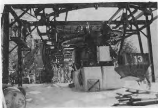
写真-4 目附谷線山麓停留所骨材運搬状況
