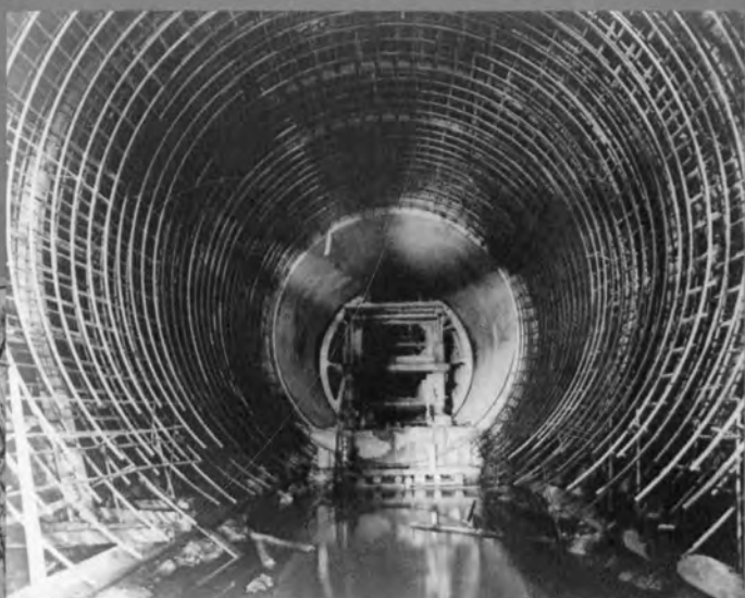
⇨ 放水路トンネル鉄筋組立
