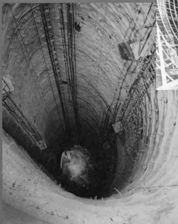
⇨ 放水路ゲート立坑盤下げ
