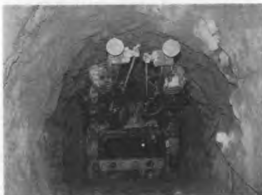
写真-1 トンネル断面
