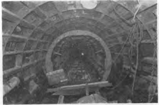
写真-5 組立完了 (φ1,500 mm)
