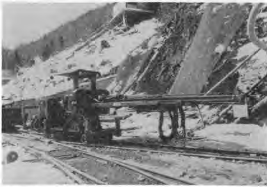
写真-2 油圧式 2 boomミニレールジャンボ (2号上口)
