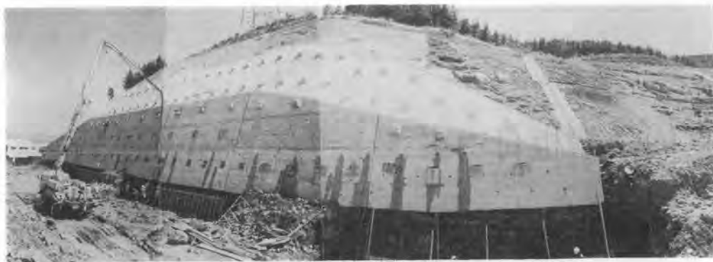
写真-3 施工状況
