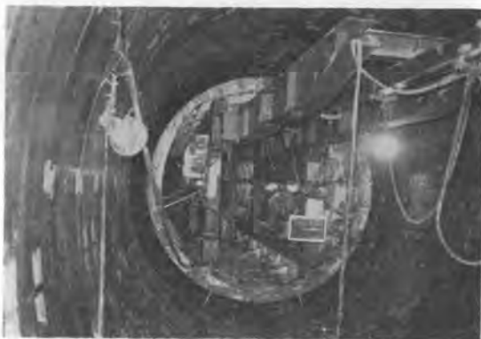
写真-2 セット状況
