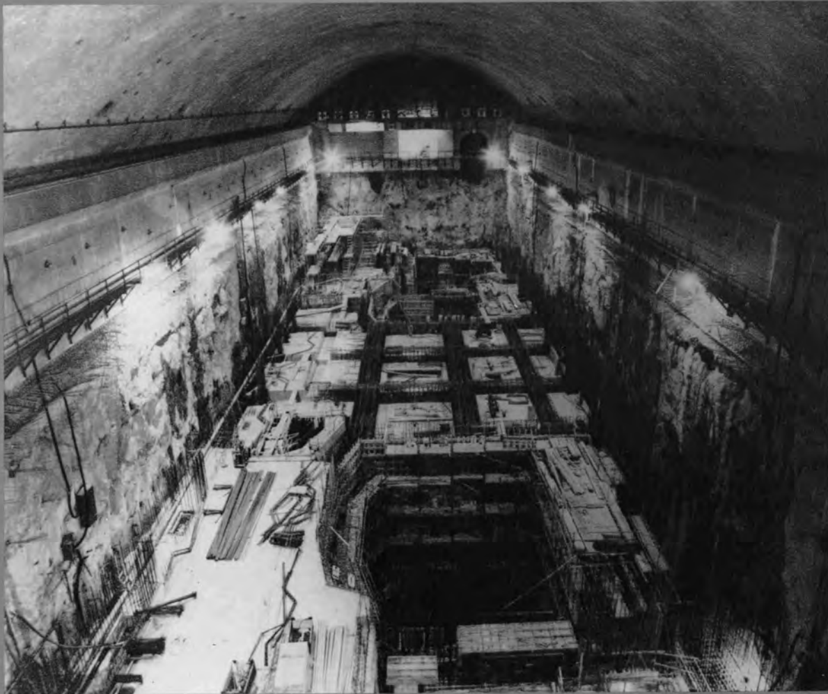
命 発電所本体コンクリート打設
