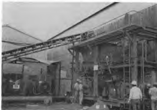
写真-2 風送設備台車
