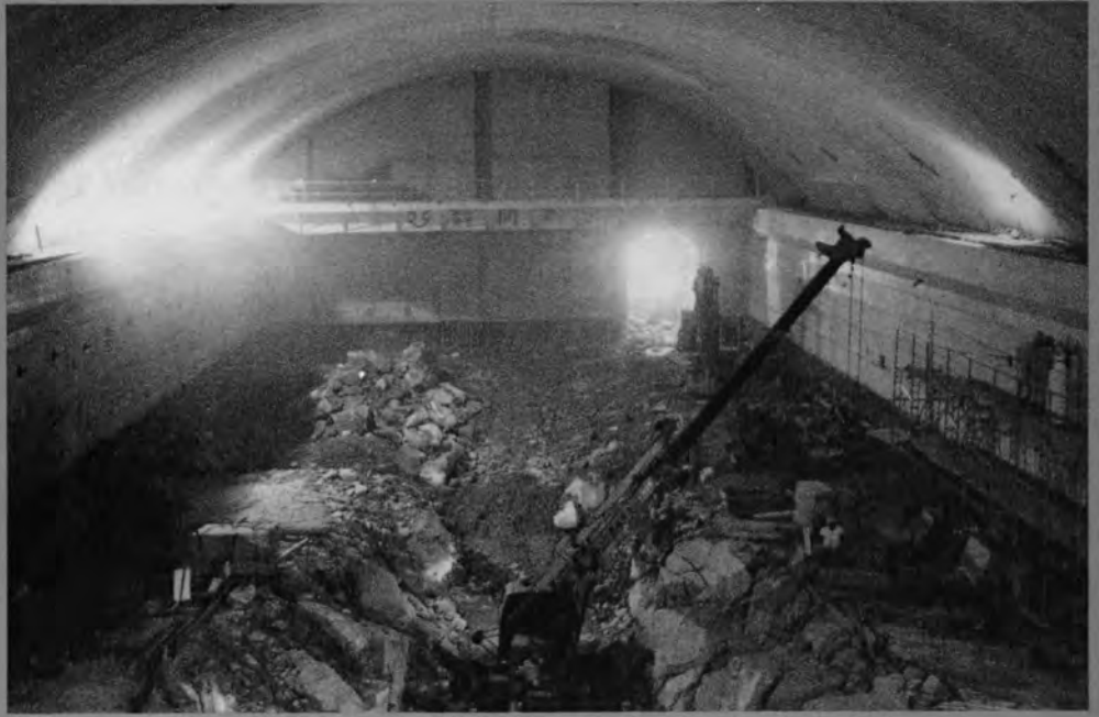
命 発電所本体盤下げ
