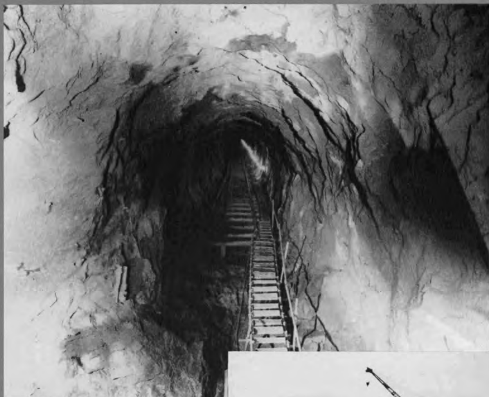
◀ 水圧管路掘削 (斜坑 48°)
