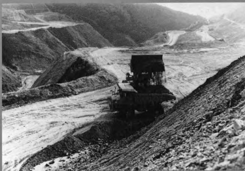
上部ダム右岸側掘削・積み
