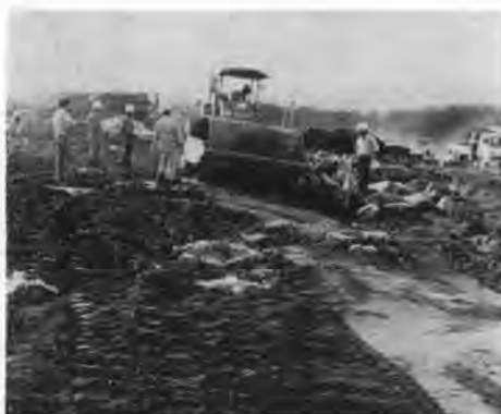
写真-1 振動ローラ BW 210 による転圧
