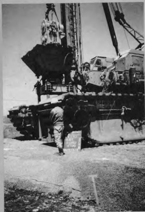
㊩ パーチカドレーンケーシング打込中 (甲府南IC)
