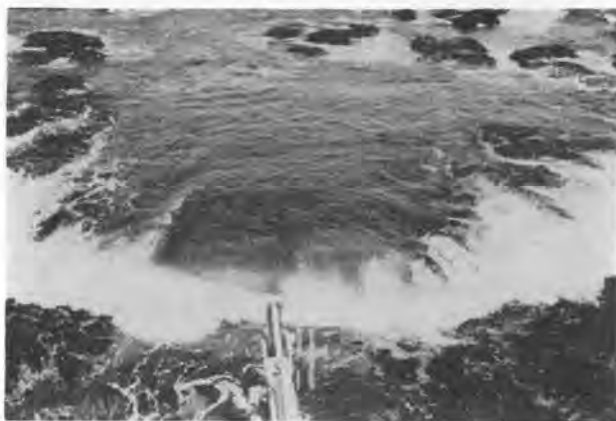
写真-1 開口部掘削
