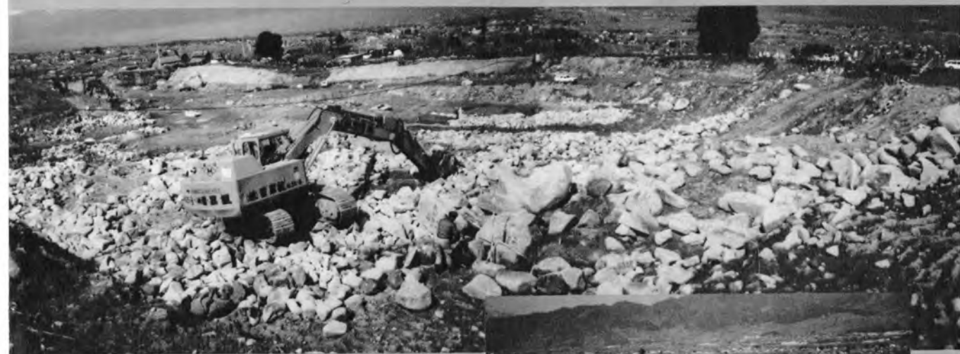
◆ブレーカによる転石小割り状況 (釈迦堂PA)
