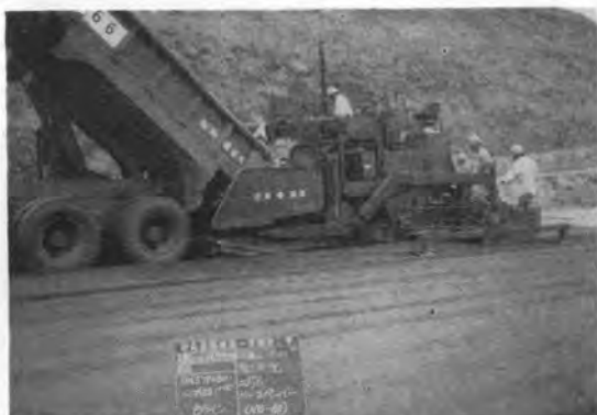
写真-7 ベースペーパーによるセメント安定処理路盤工敷きならし
