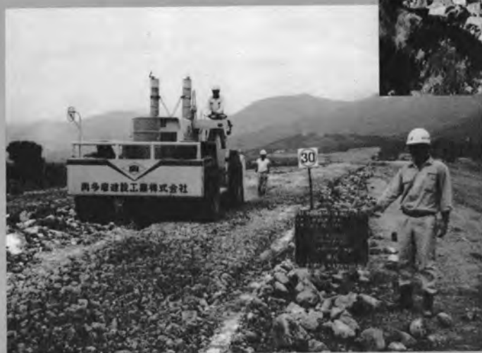
◆盛土部上部路床での スタビライザによる石灰混合
