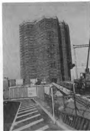
写真-3 コンクリート打設完了
