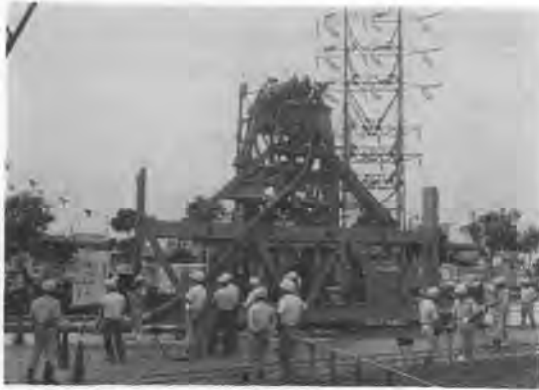
写真-2 連続地下壁掘削機
