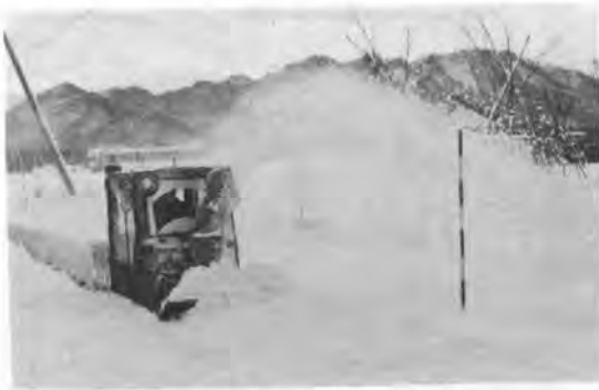
写真-2 全断面除雪試験 (積雪 70 cm)
