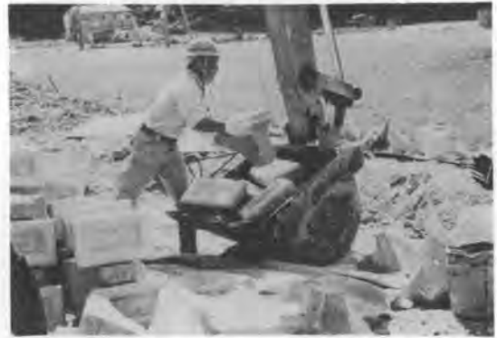
写真-1 バケットを利用した積ブロックの上下運搬
