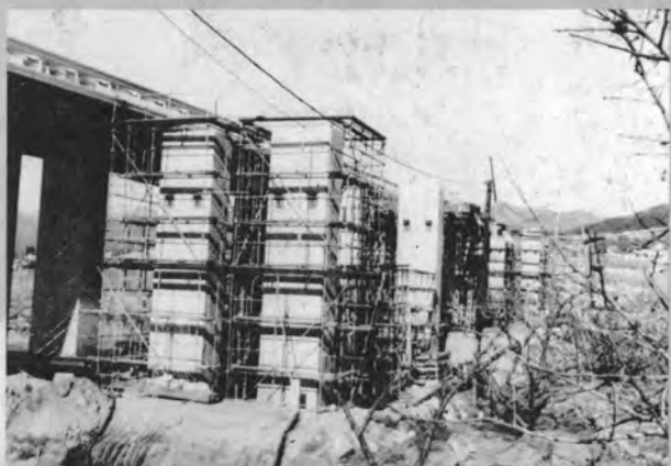
⇨ 一宮高架橋下部工の施工状況
