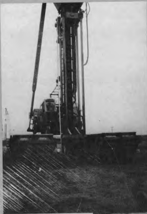
㊦ パーチカドレーン施工前 (甲府南IC内)
