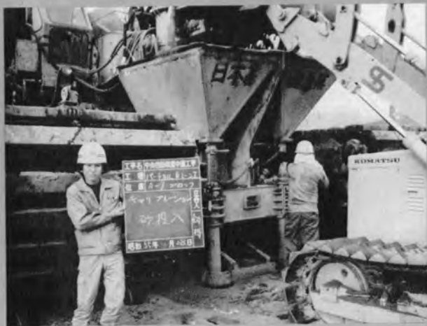
㊨ パーチカドレーン中詰砂投入 (甲府南IC)
