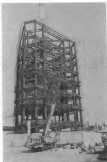
写真-2 鉄骨建方完了
