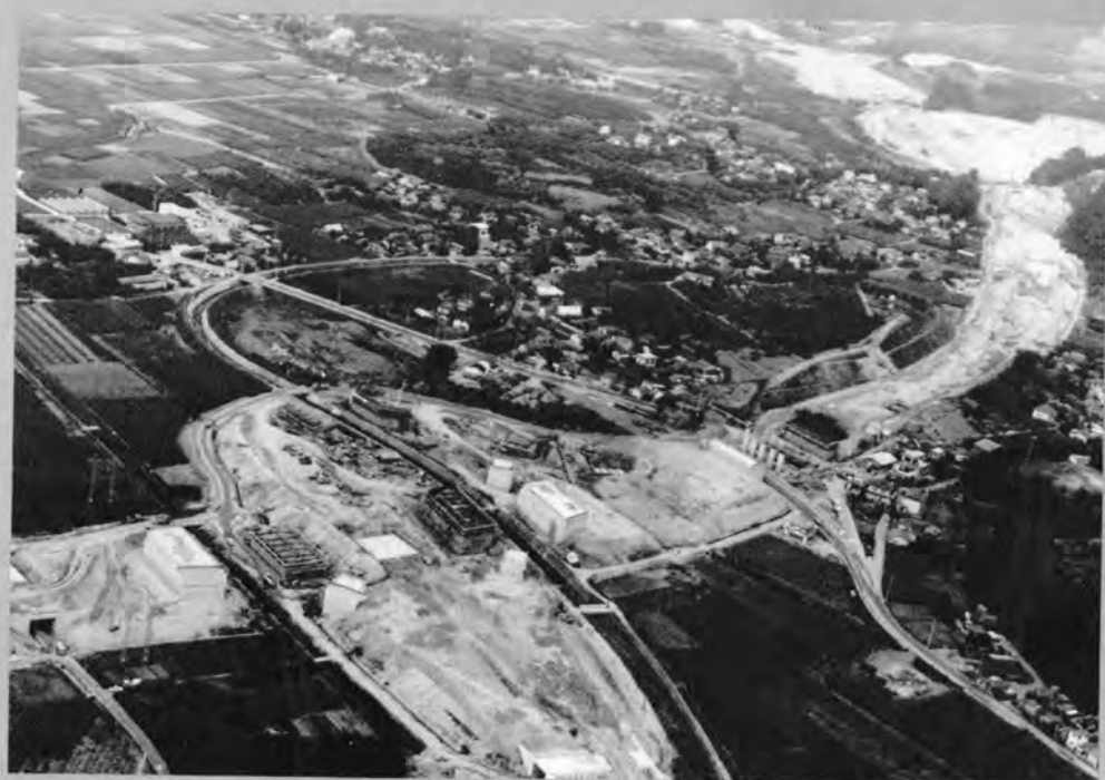
⇨施工中の甲府南IC
