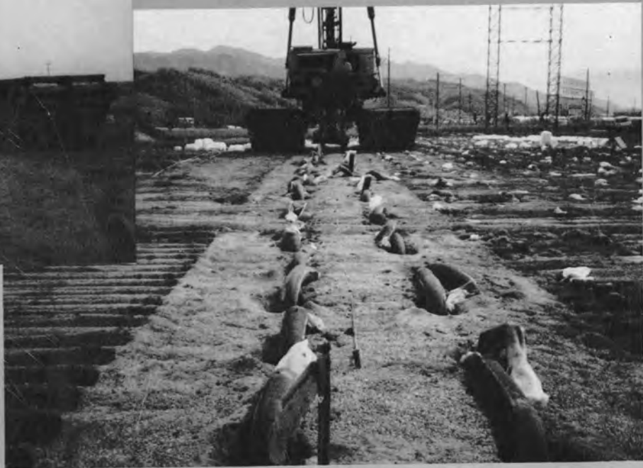
㊧ パーチカドレーン完了 (甲府南IC内)
