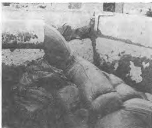
↑東京都の下水幹線工事現場。2NES100型で水平20m、垂直30m送られてホッパーに投入されるシルト (スラップ 幅10cm)
