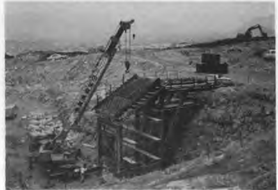
写真-3 スクリーンの仮設
