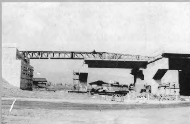
⇨ 手延工法による 神明第二橋架設状況
