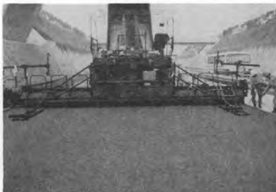
写真-8 スーパー 2000 による施工
