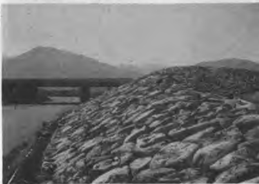
写真-2 IC ランプの転石張り
