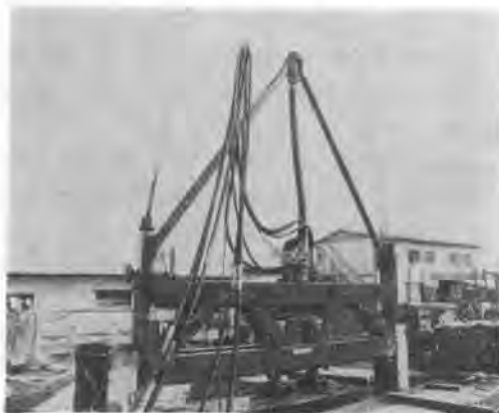
写真-1 連続地下壁掘削機
