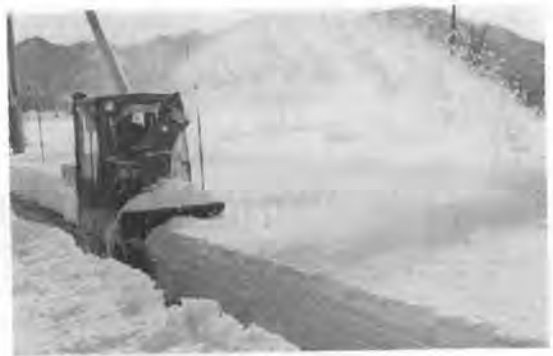
写真-3 拡幅除雪試験 (積雪 70 cm)
