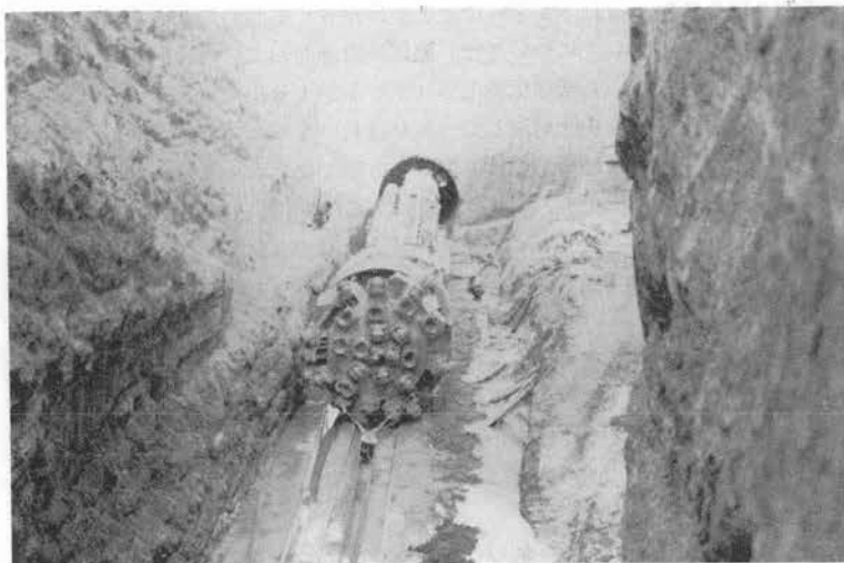
写真-1 中間立坑に引出される TBM
