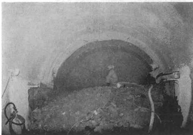
写真-3 先進導坑の吹付コンクリート
