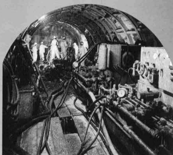
⇨切羽注入作業
