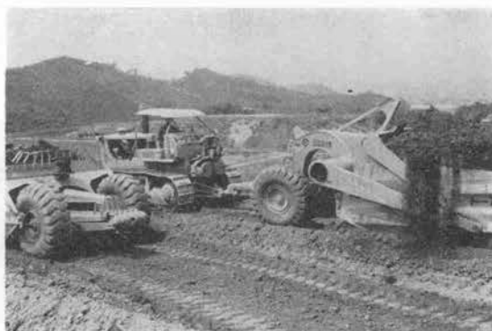
写真-8 被けん引式スクレーパによる掘削運土作業
