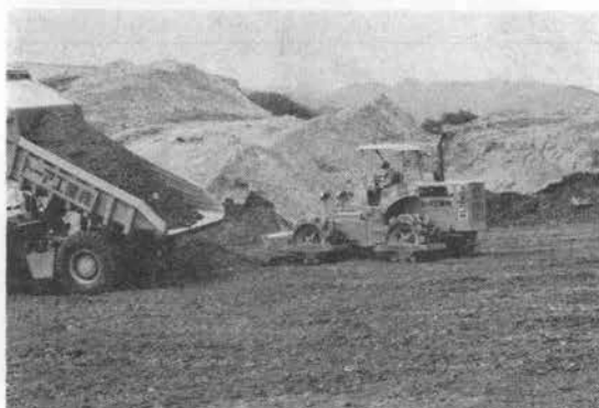
写真-9 815コンパクタによる転圧
