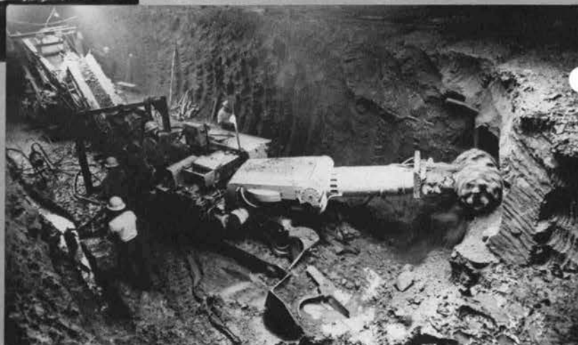
◇本坑下半部の機械掘削
