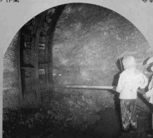
⇨切羽コンクリート吹付作業
