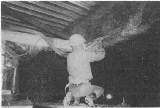
写真-4 熟練作業者によるティーチング作業
