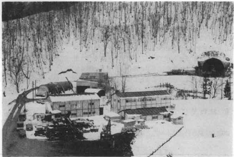
写真-1 第1森越トンネル (東) 工区坑口付近
