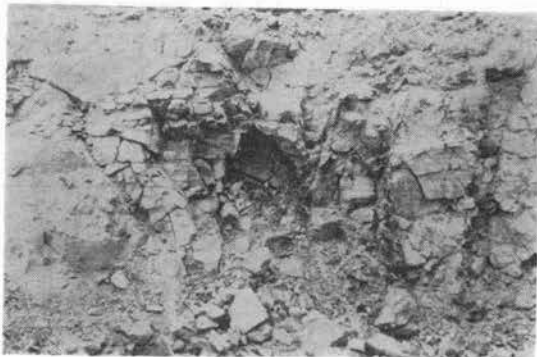
写真-2 予備発破後の岩盤断面
