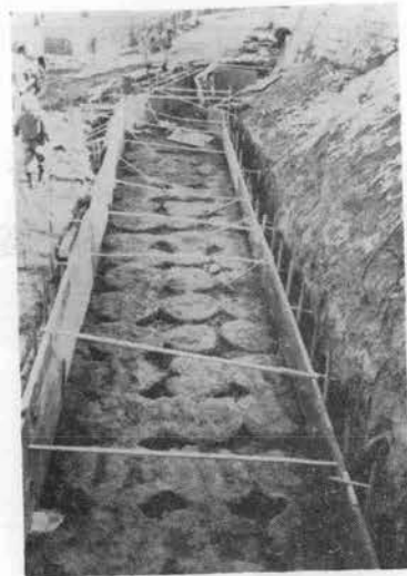
写真-6 擁壁基礎地盤の改良
