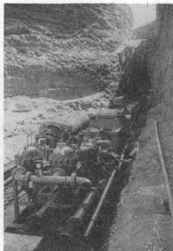
写真-2 中間立坑で組立てられたスラリー輸送装置
