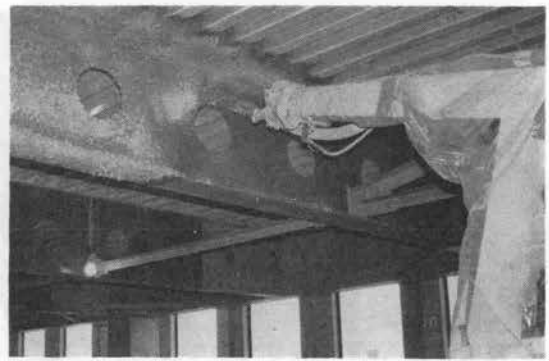
写真-5 吹付作業
