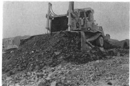
写真-6 D 9 L によるドーピング作業
