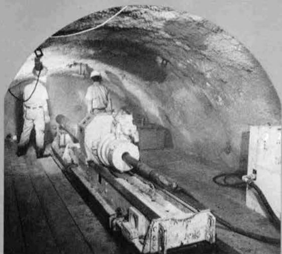
⇨切羽ボーリング作業
