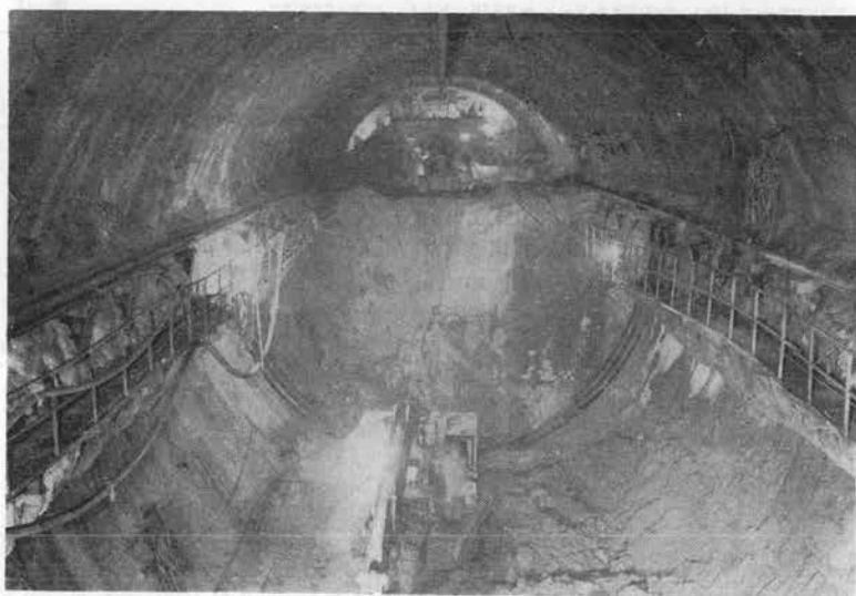
写真-5 周壁導坑先進円形ショートベンチ工法
