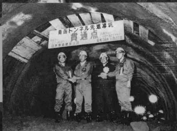
⇨先進導坑貫通
