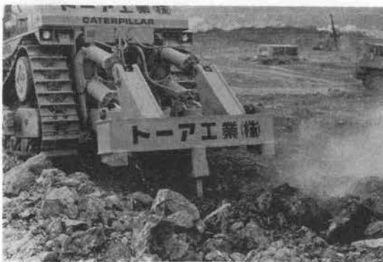
写真-5 D 9 L によるリッピング作業(1本シャック)
