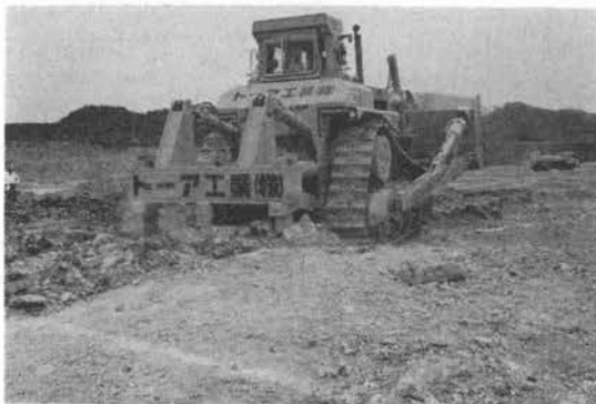
写真-4 D 10 によるリッピング作業(2本シャック)
