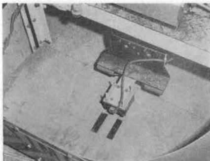
写真-2 けん引車前部に取付けられた誘導用のコイルと近接センサ
