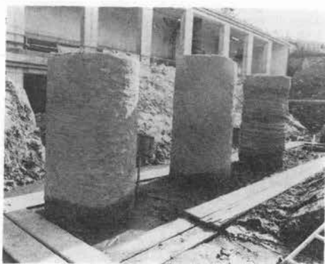
写真-5 掘削後に現われたパイル
