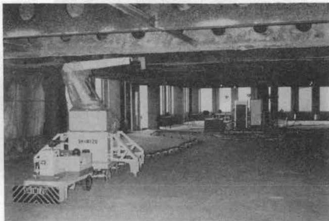
写真-3 移動中の吹付ロボット
