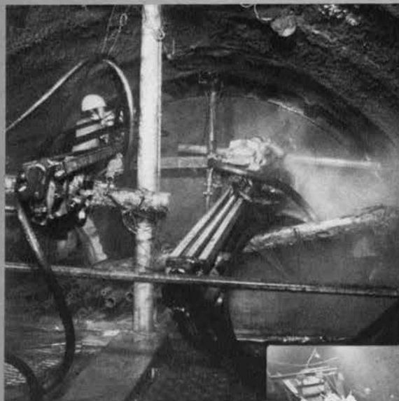
◇先進導坑の切羽せん孔
