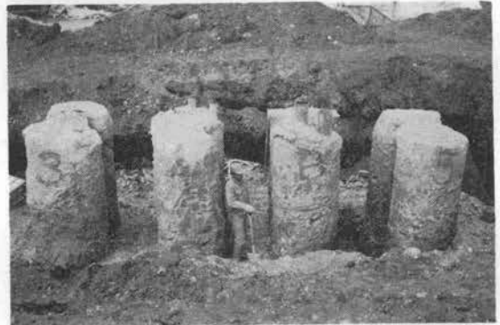
写真-3 造成した 8 本のパイル
