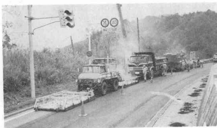
写真-1 再生サーフェース工法施工状況
