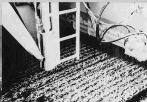
◇ 大成道路・ヒートリフォーマ (かき起し後吸油材散布状況)
