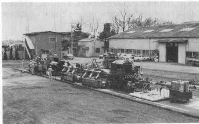
写真-1 試験施工状況
