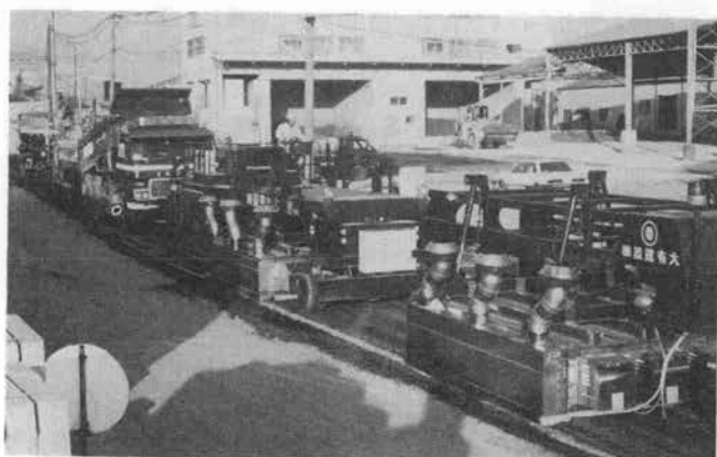
写真-1 リペーブ工法施工状況
