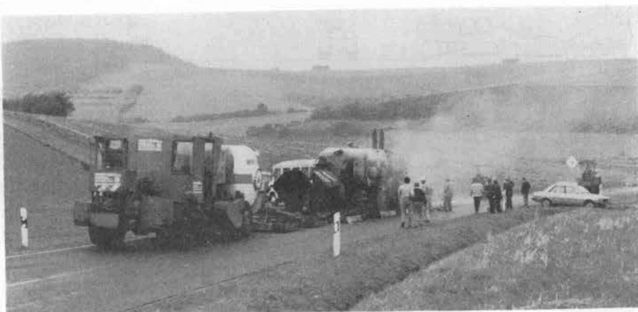
写真-1 西独ケルン郊外リペーパー工事（ヴィルトゲン社リペーパーおよびプレヒータ）
