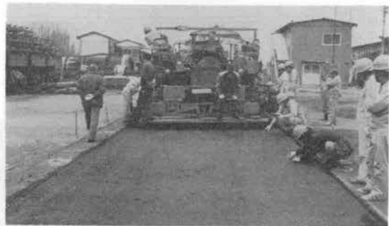
写真-2 リペーバで舗設した直後の状況
