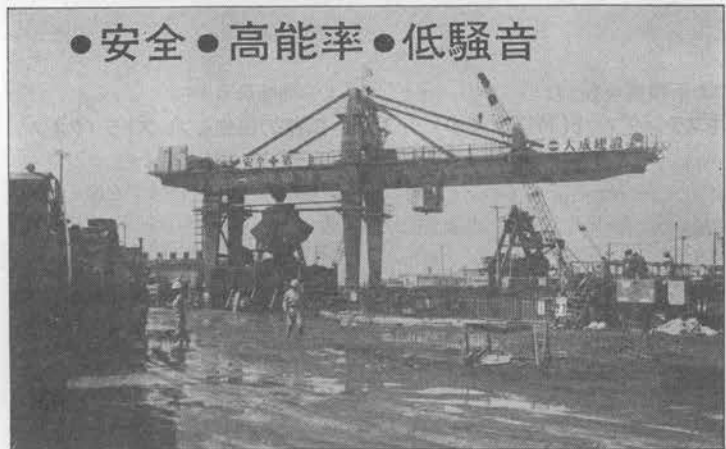
YBM-110型 バケット8M 3 能力1000M 3 /6(地下25Mより)
