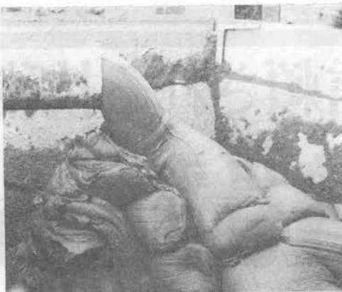
↑東京都の下水幹線工事現場。2NES100型で水平20m、垂直30m送られてホッパーに投入されるシルト（スランプ10cm）
