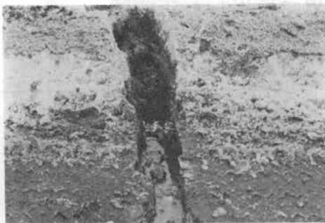
写真二 氷盤破碎跡 (確保された排水路)
