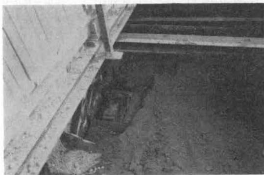
オープンカット工事
