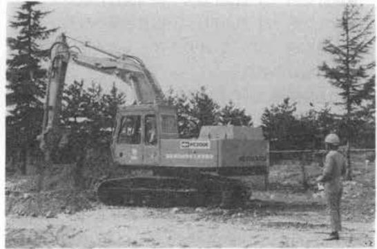
写真一 ラジコン式油圧ショベル
