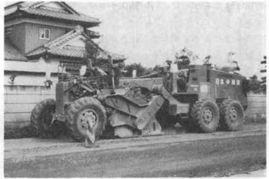
写真-2 ホイール式のグレーダ型路上再生機
