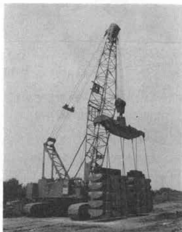
写真-6 日本車輛 DH 1500 クローラクレーン
