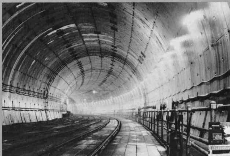
◇ 鷺谷～上野間シールド 1次覆工完成
