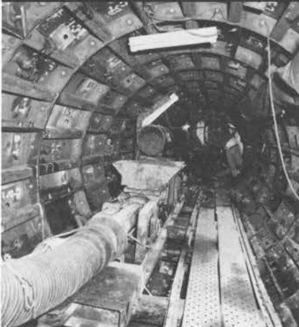
↑東京都足立区千住の管渠シールド作業現場。掘削機から送られてくる粘度の高い泥土をホッパー口に受け、坑口まで送る2NES80型。
