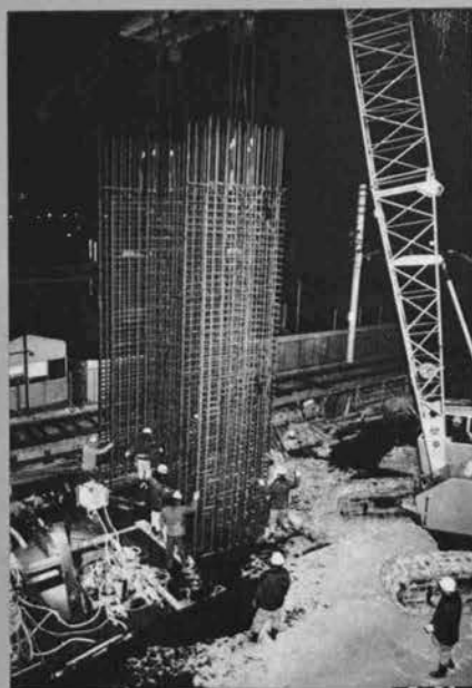
◆王子駅前連壁剛体基礎 鉄筋かご建込状況
