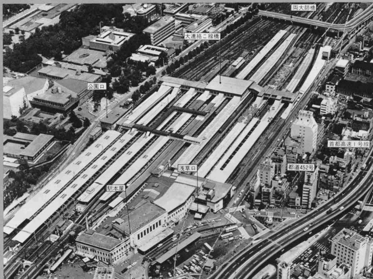
◇上野地下駅（点線内施工中）
