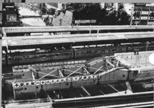
◇ 間の坂架道橋 (下路 PC 橋押し出し工法)
