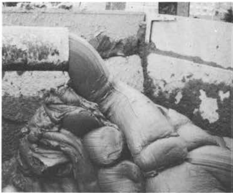
↑東京都の下水幹線工事現場。2NES100型で水平20m、垂直30m送られてホッパーに投入されるシルト (スラップ 幅10cm)
