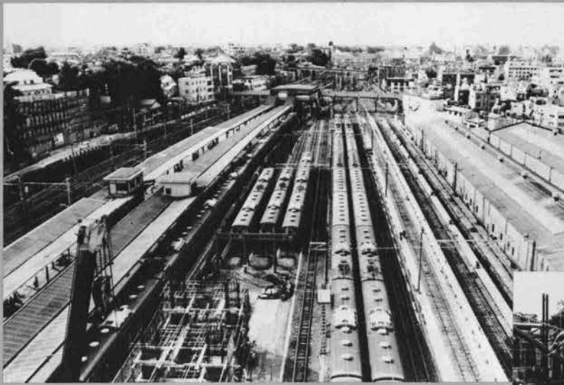
⇨東十条駅構内工事中の高架橋
