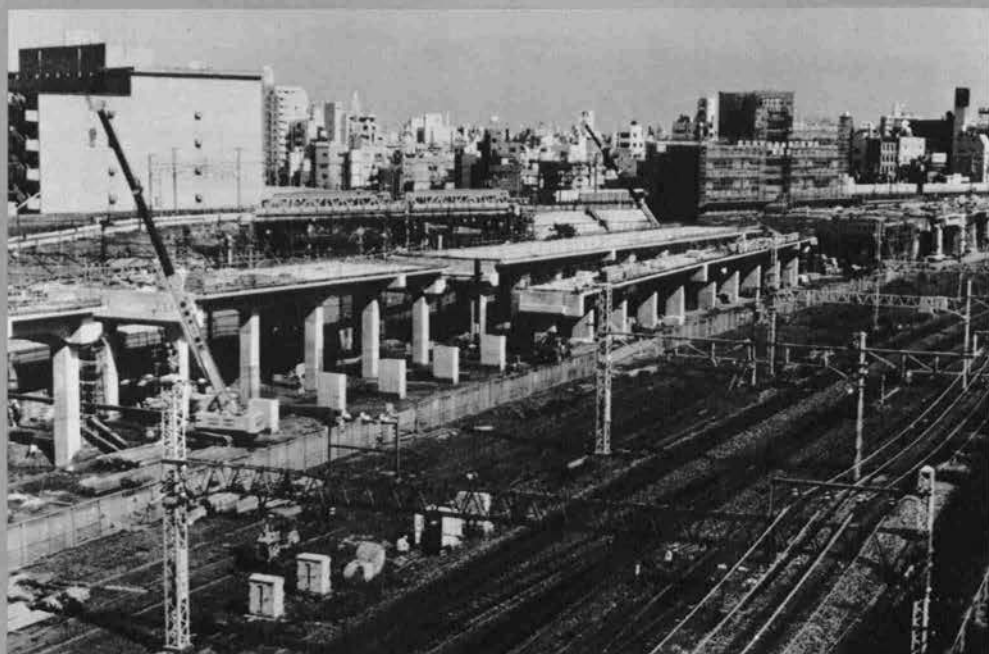
◇ 工事中の田端南部高架橋
