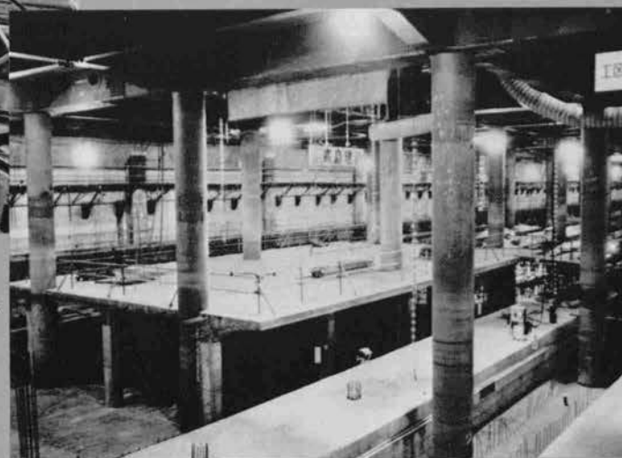
地下4階乗降場床版の施工◇
