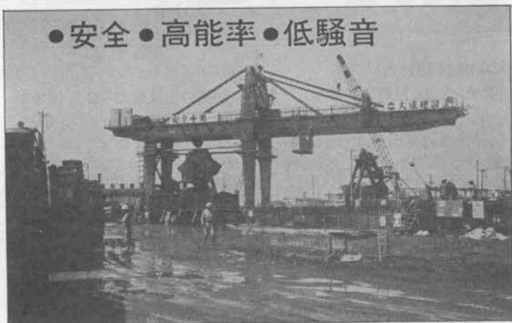
YBM-110型 バケツ8M 3 能力1000M 3 /6(地下25Mより)
