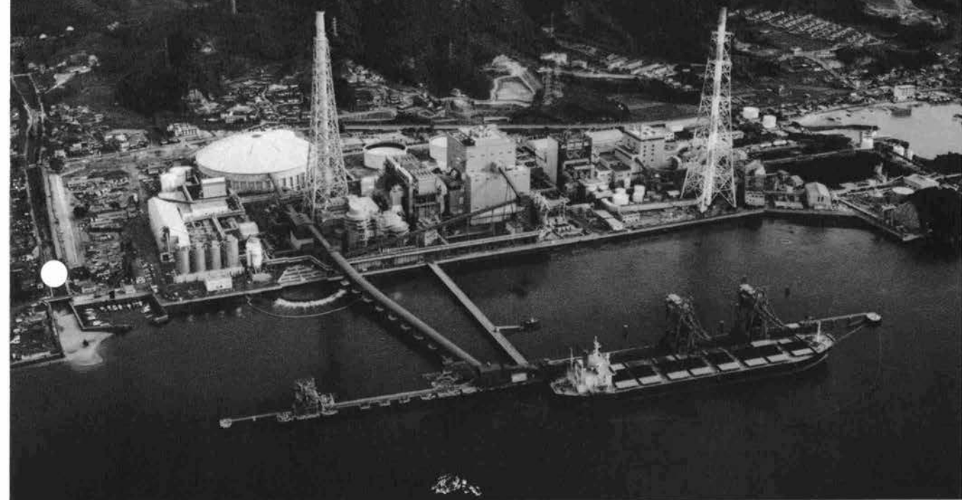
◀竹原火力発電所全景
