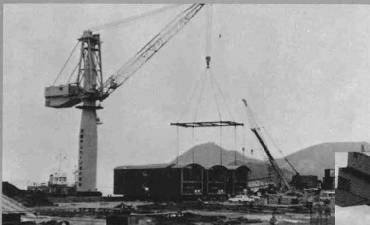
⇨ 敷地内地組場で地組み完了した海上ギャラリガードを100tフローティングクレーンによりバージ船に載せる
