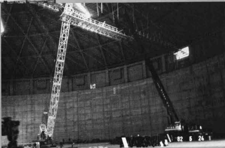
受入 No.5 コンベヤフレーム (屋内貯炭場内) 上架状況⇨
