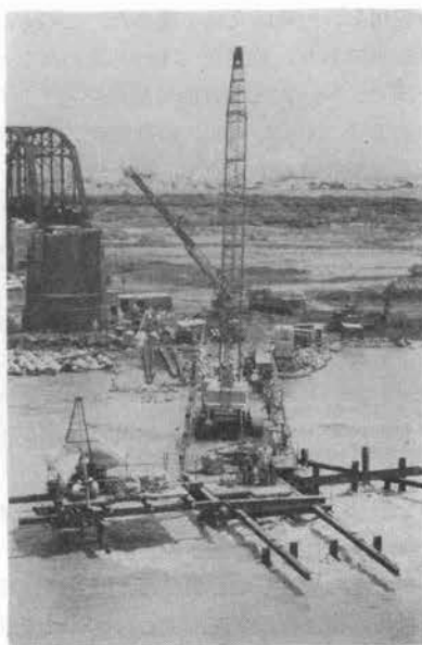
写真-1 仮橋の施工
