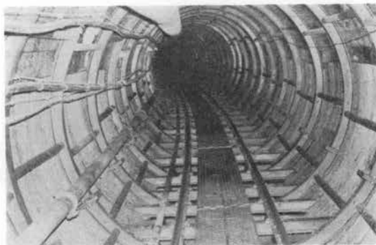
写真-2 掘削後の坑内
