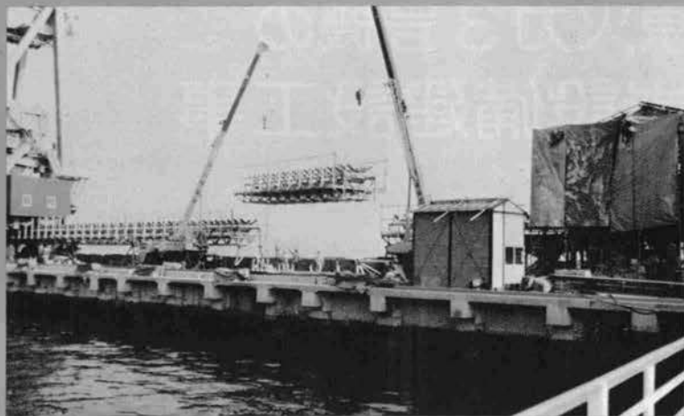
⇨ 棧橋上コンベヤガード据付
