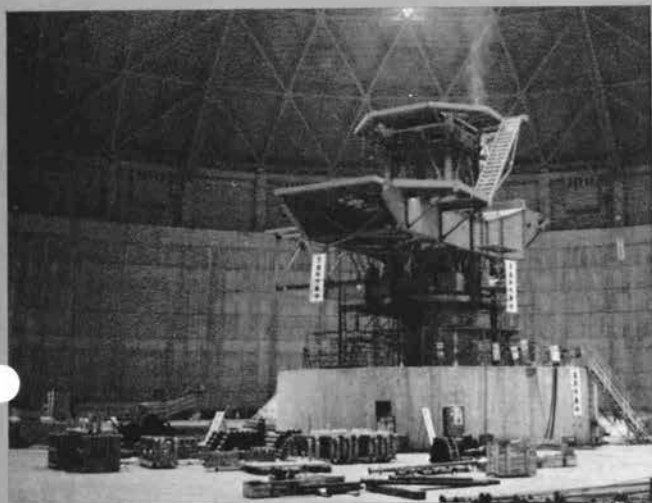
⇨ センターポストの組立 (リクレーマ部)
