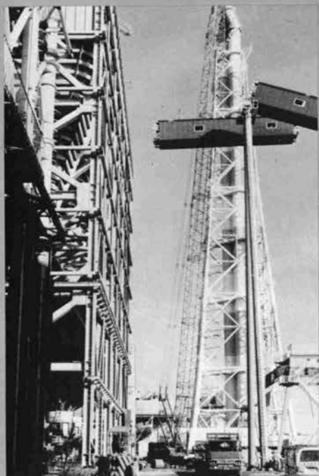
⇨ 150 t クローラクレーンを使って 50 m の 高さへ上架されるコンベヤガラリガード
