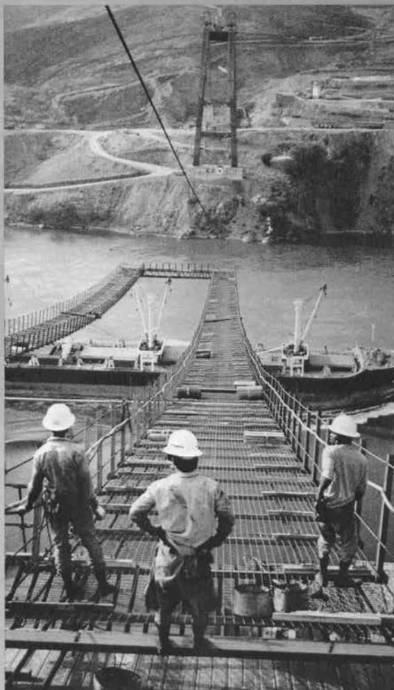
センタースパンのキャットウォークの引出し (タワーからスパン中心に向かって引出した) ◆ (1981年9月)
