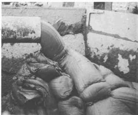
↑東京都の下水幹線工事現場。2NES100型で水平20m、垂直30m送られてホッパーに投入されるシルト (ふるい10cm)
