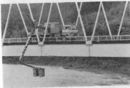
写真-1 Gondola 式橋梁点検車による点検作業
