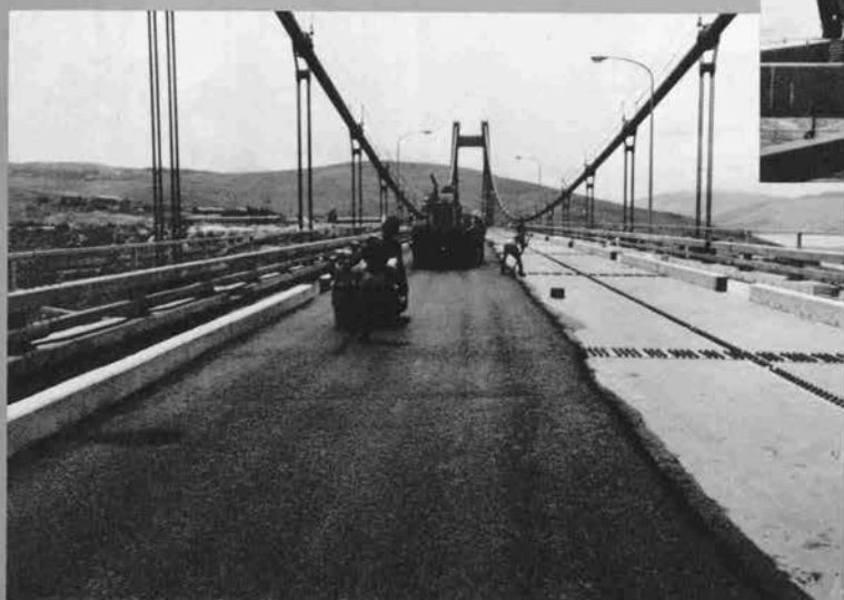
⇨ 橋床版舗装施工中 (1983年2月)
