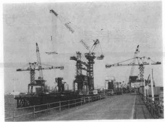
写真-6 作業機台上の仮設備
