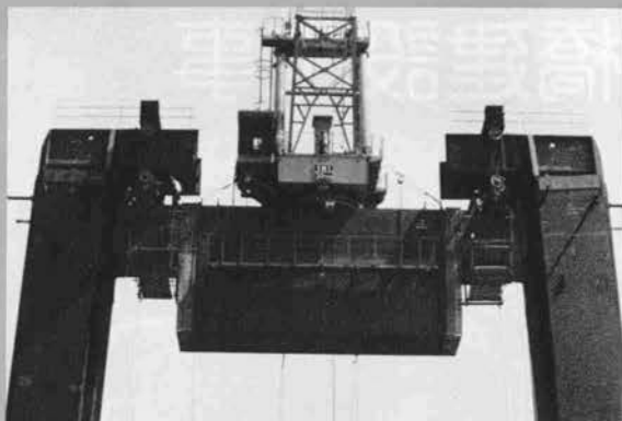
⇨塔頂水平材の架設 (水平材は上下2段になっている。1981年3月)
