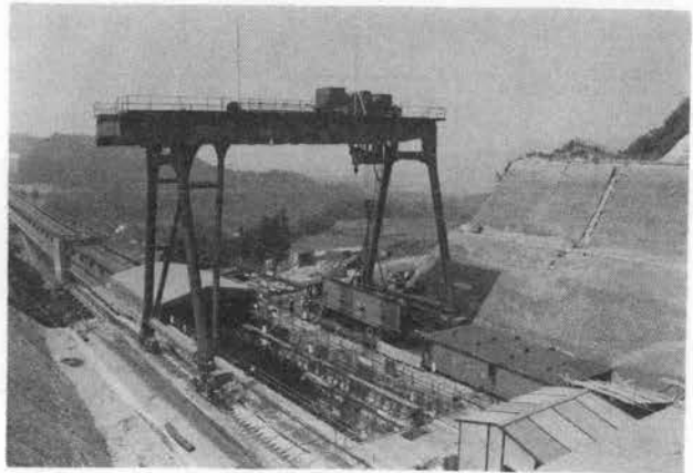
写真-4 送出しヤード全景
