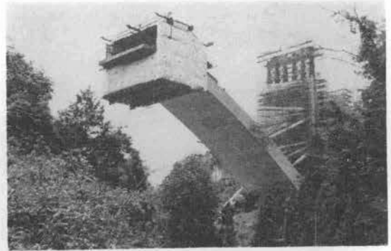
写真—3 ピロン・メラン併用工法による宇佐川橋
