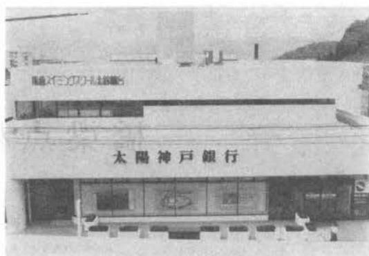
写真-2 竣工時作業所全景
