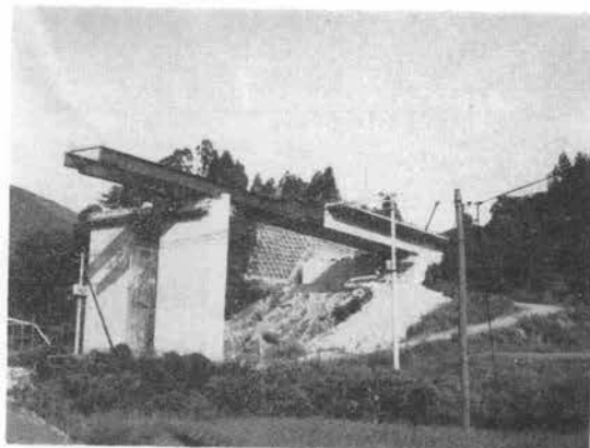
写真-7 押し出し工法
