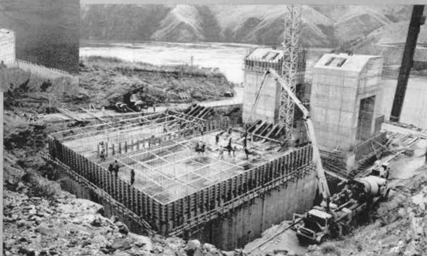
♡コンクリート打設中のアンカーレッジ (コンクリート打設はマスコン方式をやめ、多ブロック方式にした。1981年5月)
