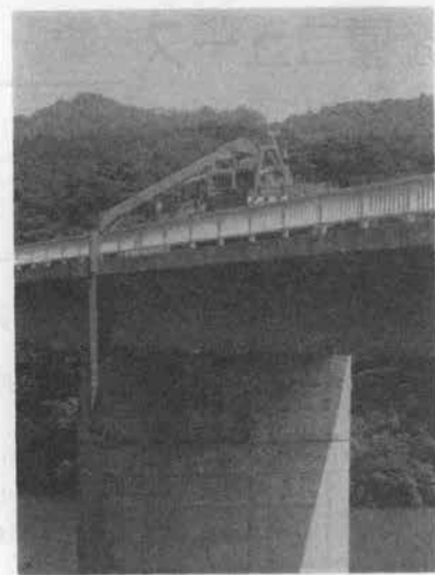
写真—3 モニタ式橋梁点検車（実験機）による点検作業
