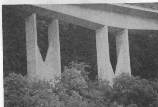
写真-8 ション高架橋の橋脚
