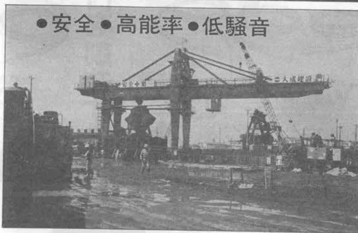
YBM-110型 バケット8M 3 能力1000 M 3 /%(地下25Mより)
