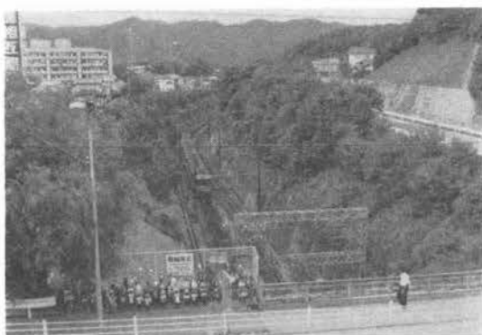
写真-1 着工前作業所全景
