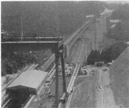
写真-2 送出しヤード側より望む沼尾川橋
