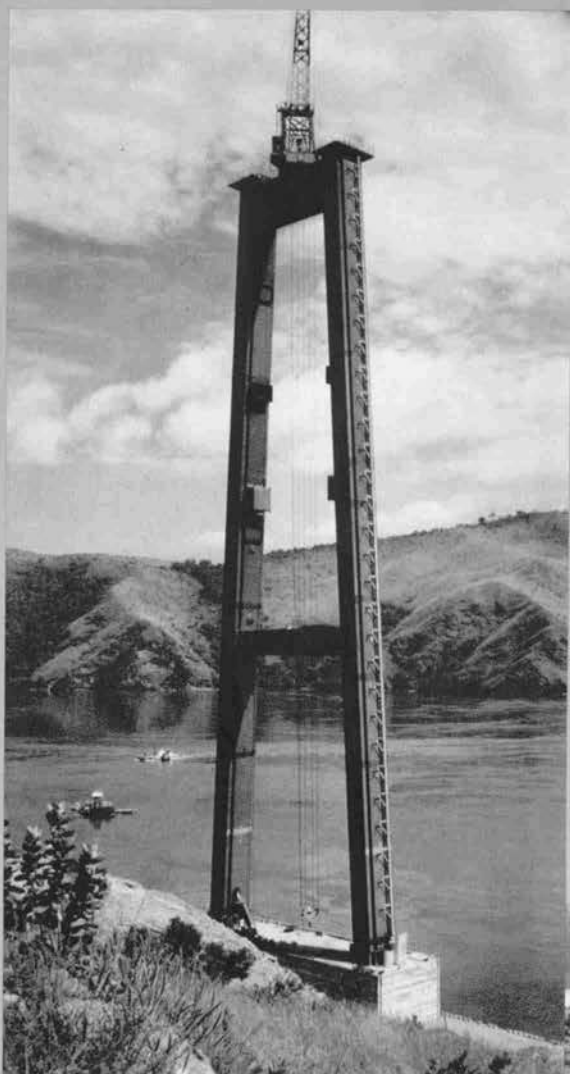
⇨架設の完了した主塔 (1981年4月)
