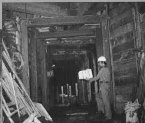
⇨ トレンチ坑 (神戸高速鉄道)
