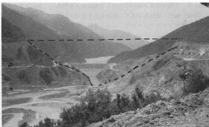
写真-1 下流よりダムサイト上流側を見る
