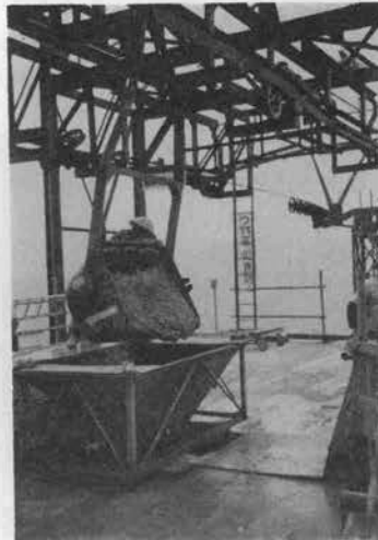
写真-5 尾添索道上部停留所
