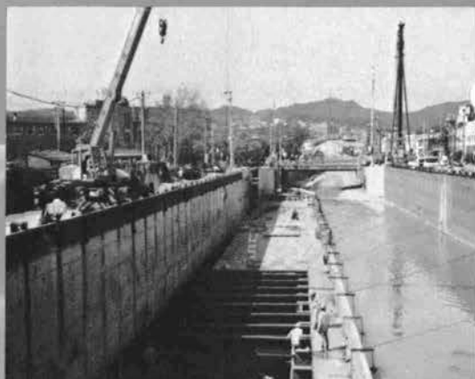
◆新湊川横断部鉄橋架設
