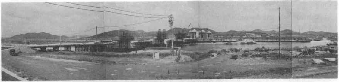
写真-4 工事全景 (左岸より右岸を望む)
