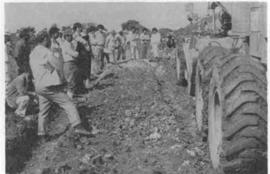
写真-3 施 工 状 況
