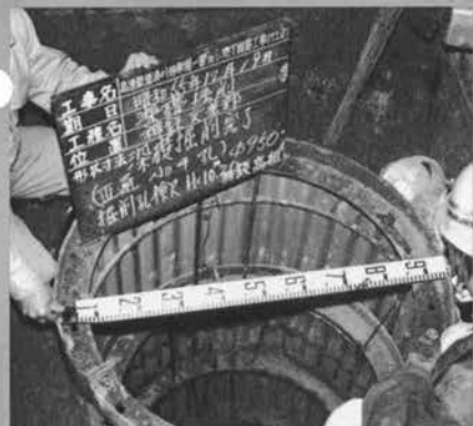
⇨ 深礎掘削 (神戸電鉄)
