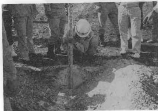
写真-5 コーラル盤の切削状況
