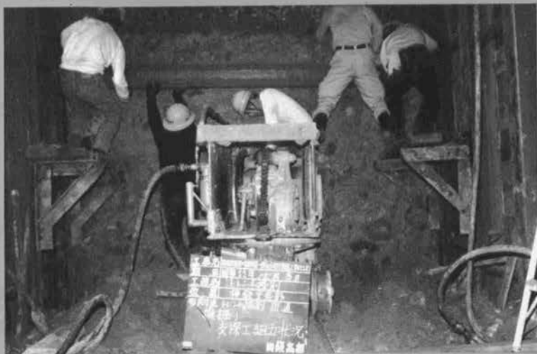
ロッカーショベルによる トレンチ掘削 (神戸電鉄) ⇨
