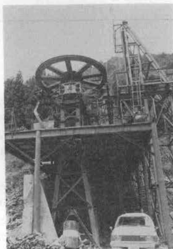
写真-10 小坂川索道下部停留所
