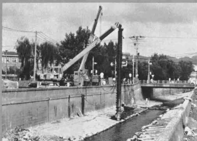
◆新湊川横断部 栈橋支持杭の施工状況
