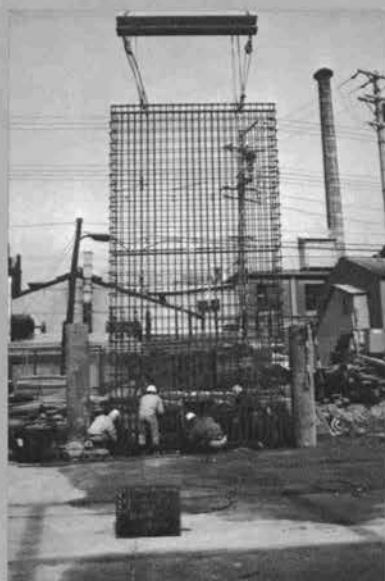
連続土留壁鉄筋かご 建込み状況
