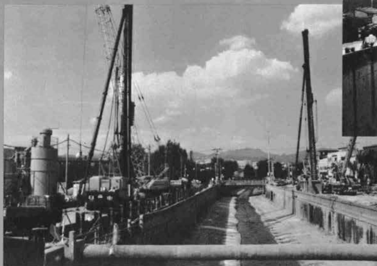
◆新湊川横断部 土留杭の施工状況
