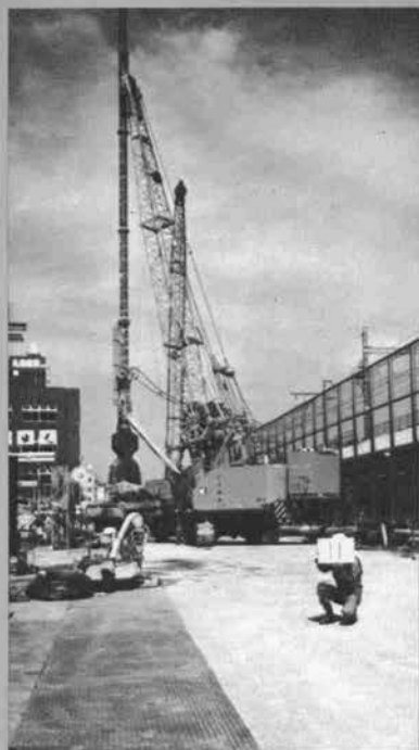
国鉄山陽本線沿の 連続土留壁掘削機
