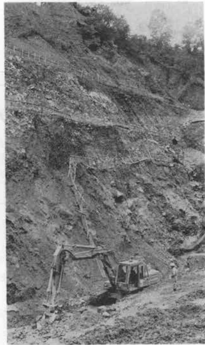
写真-5 施工状況
