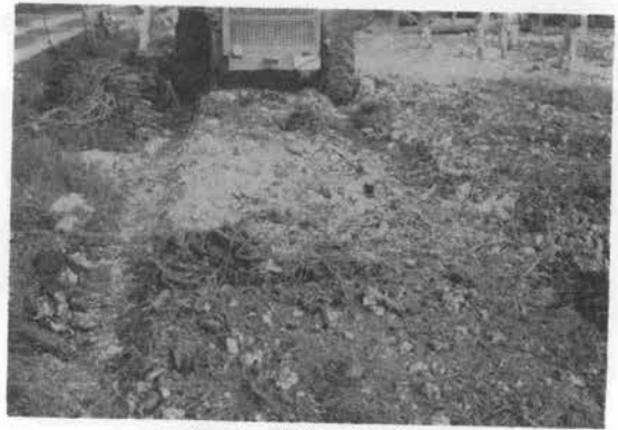
写真-4 根株類の破砕状況
