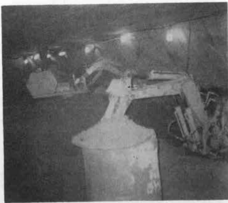
写真-5 函内掘削状況
