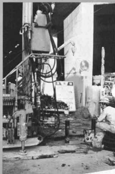
湊川トンネル（橋梁）注入さく 孔機（パーカッション式）
