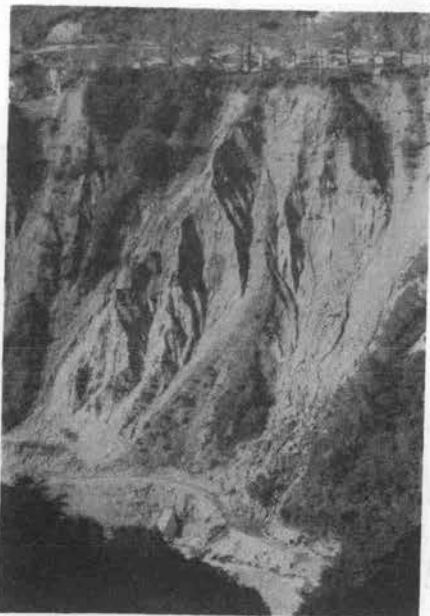
写真—1 水谷平の崩壊現況
