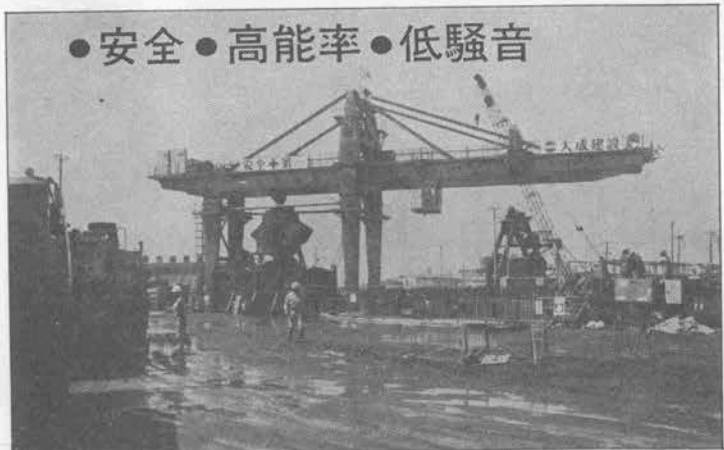
YBM-110型 バケット8M 3 能力1000M 3 %(地下25Mより)
