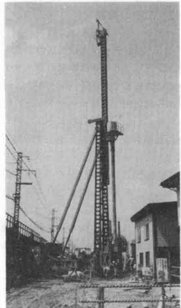
写真-1 山形におけるフンデックス杭の施工
