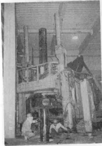
写真-2 基山におけるチューベックス杭の施工
