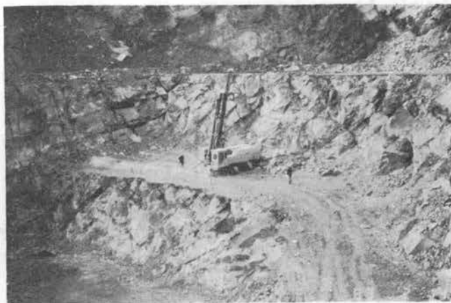
写真-2 MCD 15 G 稼働状況
