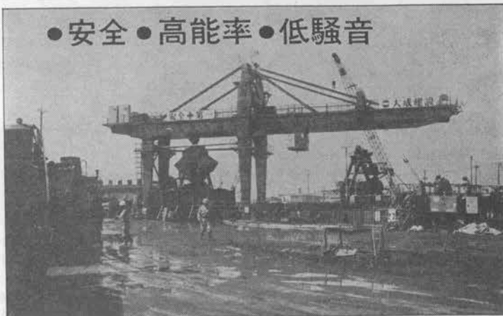
YBM-110型 バケット8M 3 能力1000M 3 /日(地下25Mより)
