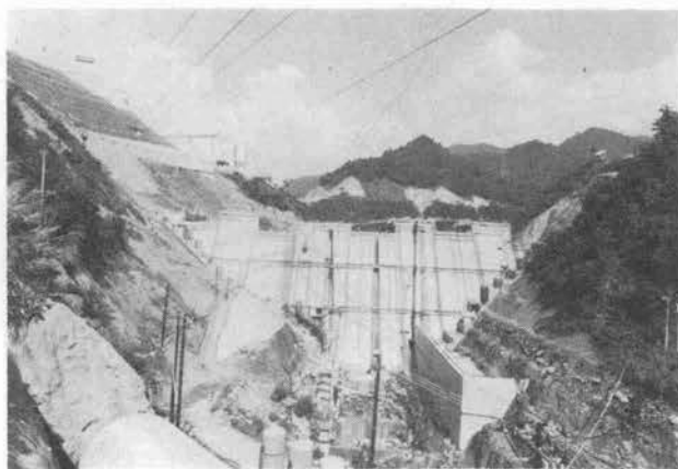
写真-1 破間川ダム工事全景
