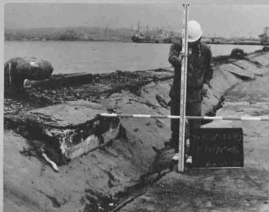
上部工が全長にわたり陸側に傾斜し、 クラックが発生 (向浜 2 号岸壁) ⊕
