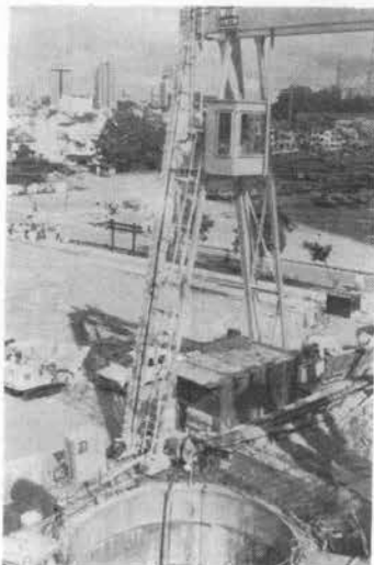
写真-2 橋形クレーン
