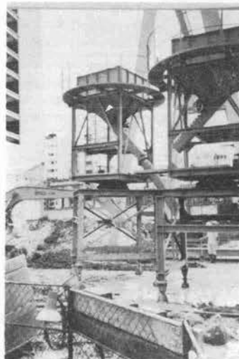
写真-3 回転式コンクリートホッパ
