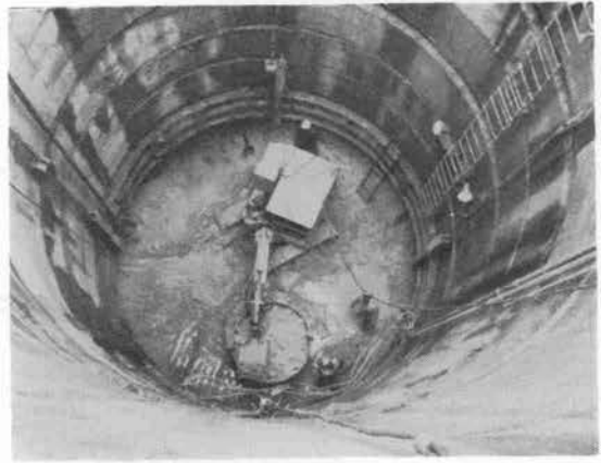
写真-5 バックホウによるケーソン掘削
