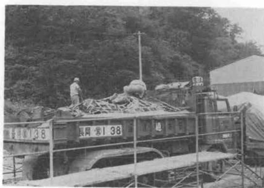
写真-3 ネットシート掛け
