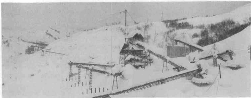
写真-2 骨材製造設備積雪状況
