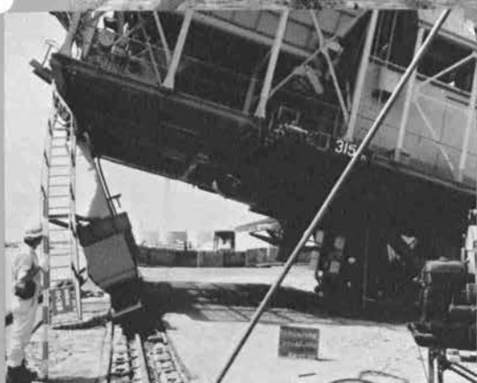
◆アンローダの崩壊 (中島 2 号岸壁)
