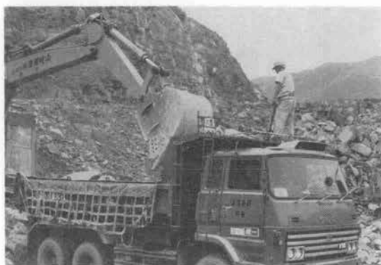
写真-2 原石山での積荷の目測管理
