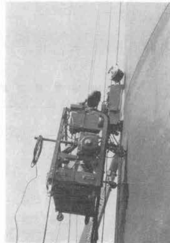
写真—7 EGW による溶接
