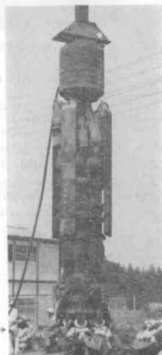
写真—11 利根 TRR 15 → 大口径硬岩掘削機
