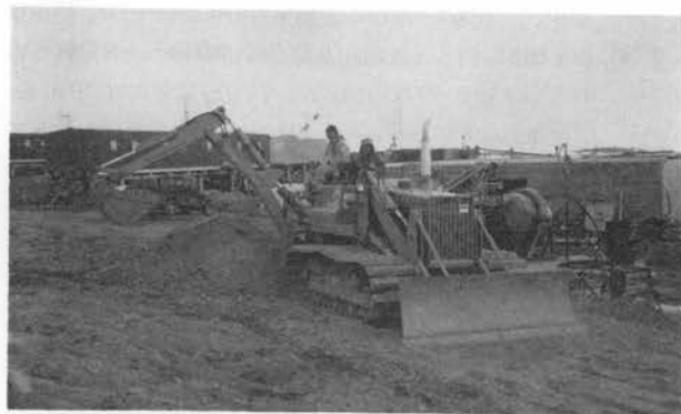
写真-1 新発電棟の建設現場
