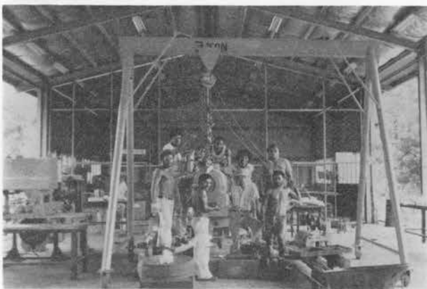
写真-8 3t ガントリークレーン
