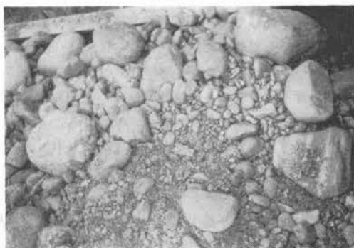
写真-1 GL-4.5m 付近の玉石混りれき
