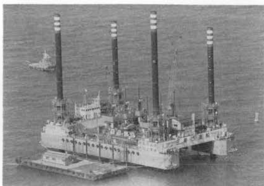
写真-3 SEP「たまの」によるせん孔作業 (7A)
