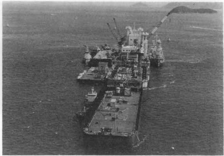
写真-5 注入船団係留状況
