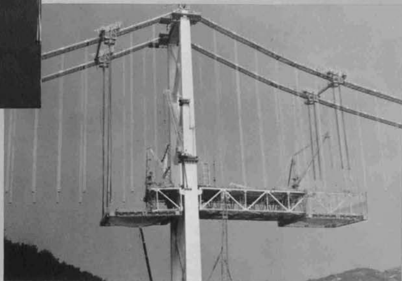
⇨ 補剛桁の架設状況
