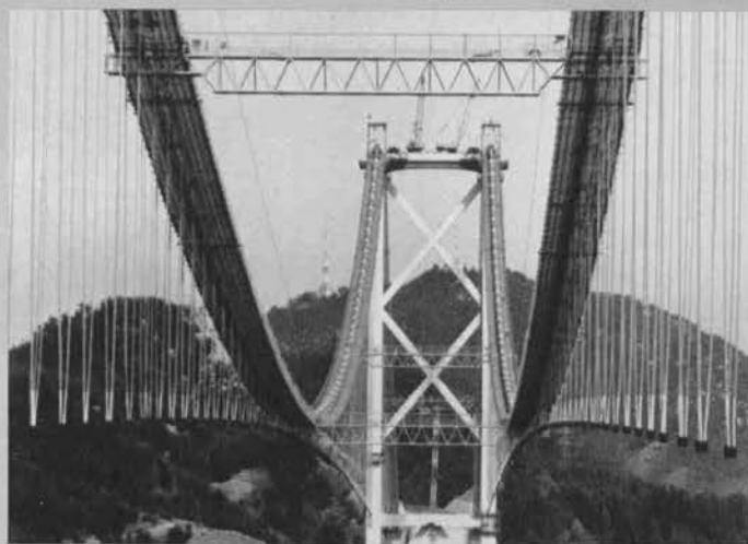
⇨ ハンガーロープの架設完了
