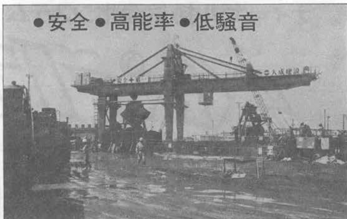
YBM-110型 バケツ8M 3 能力1000M 3 /日(地下25Mより)
