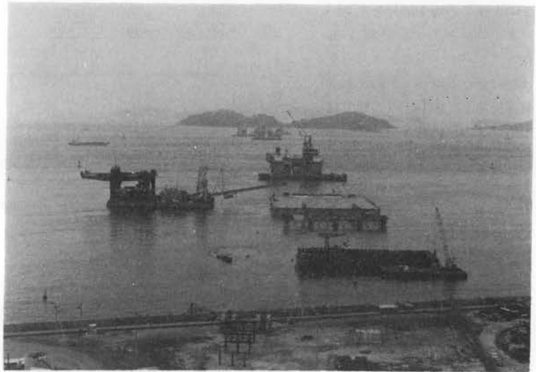
写真-1 粗骨材充填状況 (7A)
