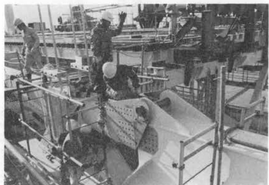
写真-5 架設ヒンジ
