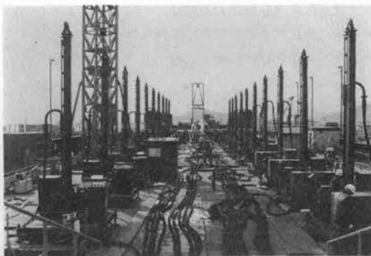
写真-4 ケーソン上の注入機器
