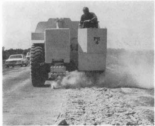
写真-2 PB4 による施工
