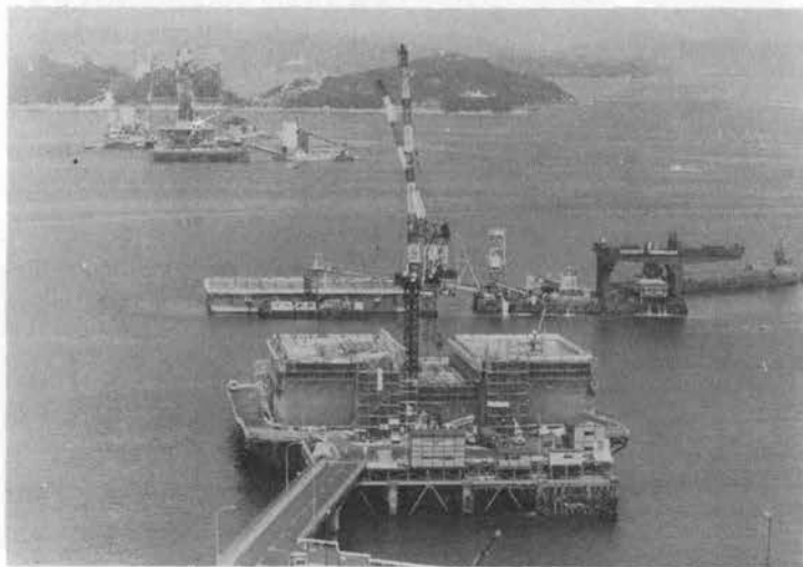
写真-1 南北備讃瀬戸大橋下部工事（昭和 58 年 9 月）
