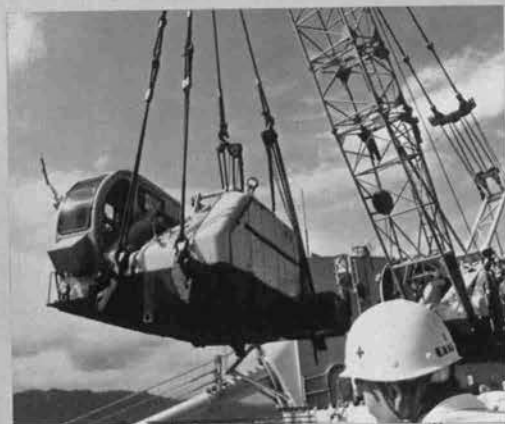
⇨ 塔頂クレーンの解体
