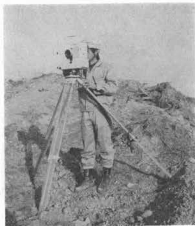
写真-2 エレクトロ・タキオメータ
