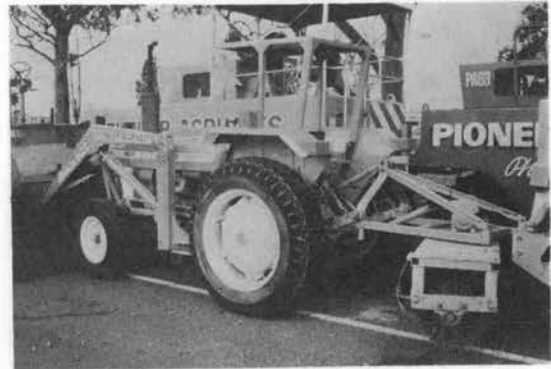
写真—2 拡幅工用機械群
