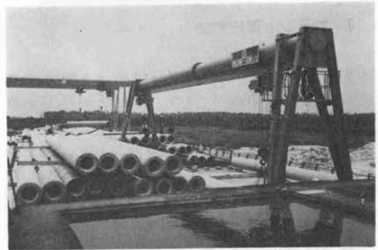
写真—3 水中養生槽とストック中の φ 800 PC 杭
