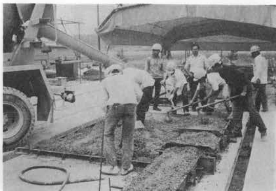
写真-3 PC版のコンクリート打設
