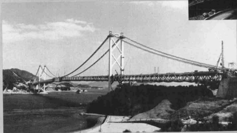
⇨ 補剛桁の閉合
