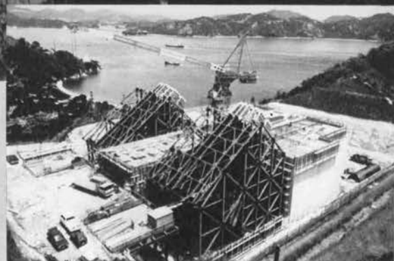
橋台アンカーフレームの設置
