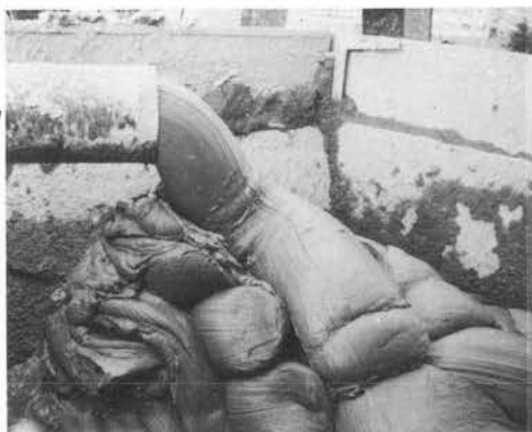
↑東京都の下水幹線工事現場。2NES100型で水平20m、 垂直30m送られてホッパーに投入されるシルト (スランプ 10cm)
