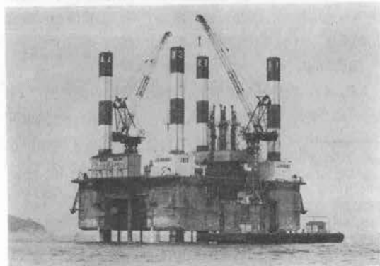
写真-2 SEP「盤石」によるセン孔作業 (5P)
