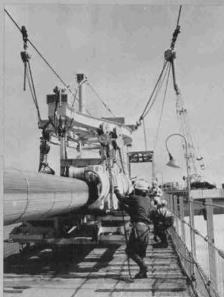
⇨ ケーブルバンドの架設
