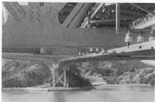
写真-6 支持罫子の取付状況
