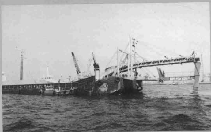
④地盤改良工 (砂置換)
