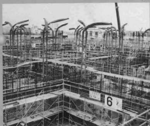
ケーソン圧入用ケーブル配置状況
