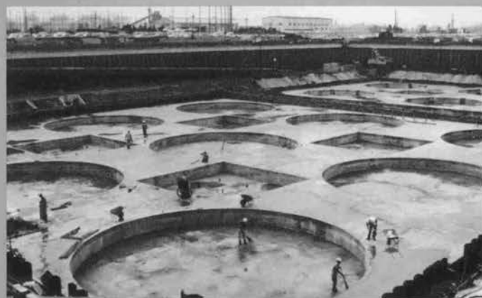
ドックの渠底完成
