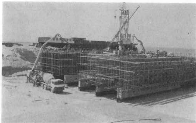
写真-5 下部コンクリート打設状況
