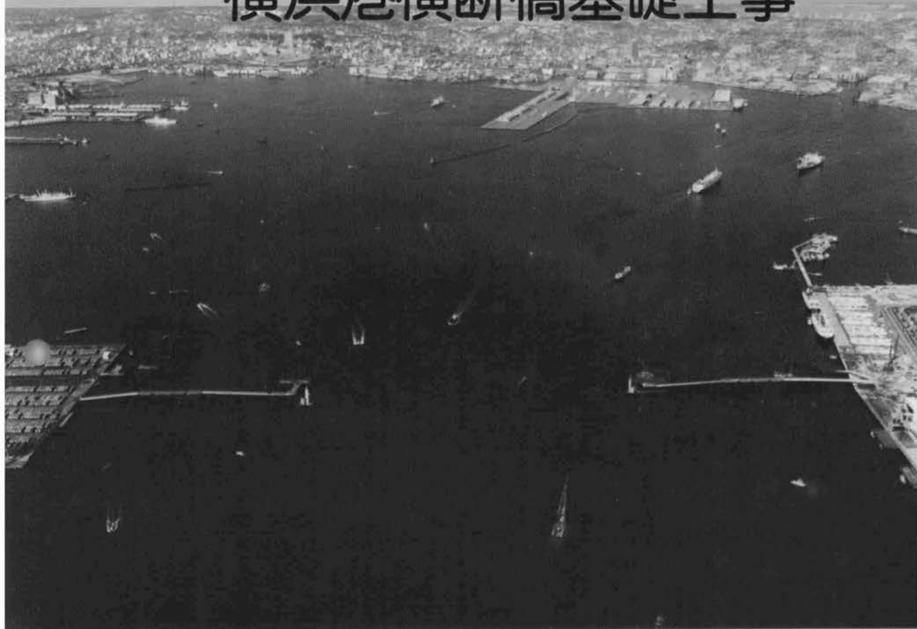
◆海上仮設工事完成
