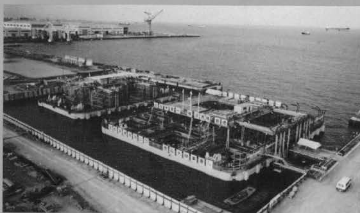
コンクリートバージ えい航準備完了
