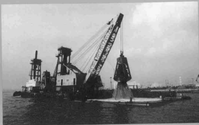
④地盤改良工 (アンカレス浚渫船)
