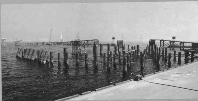
棧橋、棧台、 設置ガイド打設状況④
