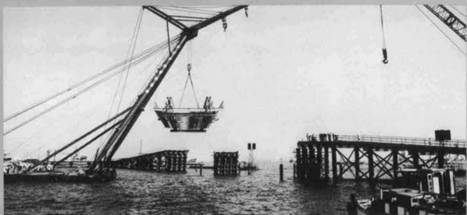
仮設トラス橋の架設
