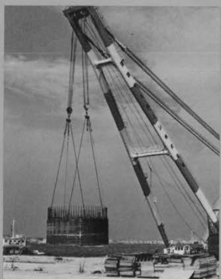
ケーソン鋼製刃口 (径10 m ×高さ4 m) のつり込み
