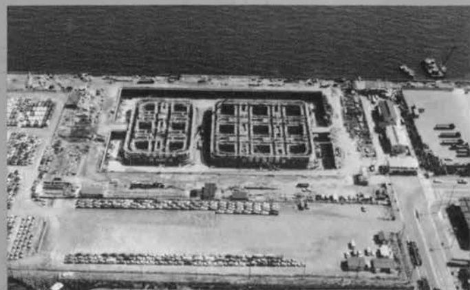
コンクリートバージ 製作中のドック
