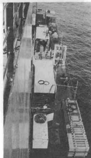
写真-2 潜水機材配置状況
