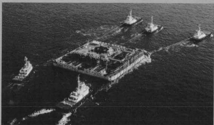
コンクリートバージ 主塔のえい航
