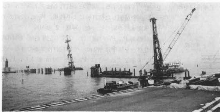
写真-2 橋杭打設状況
