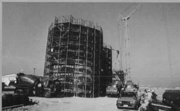
プレキャストケーソンの コンクリート打設
