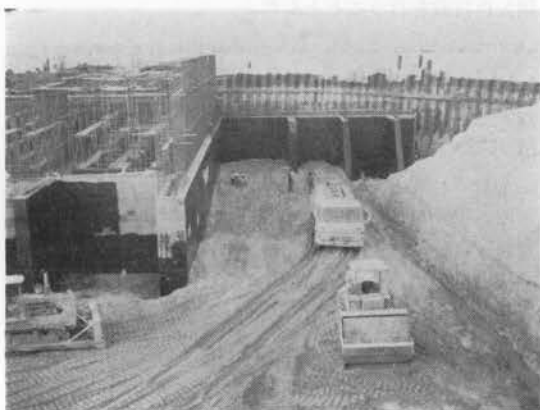
写真-4 埋戻し状況
