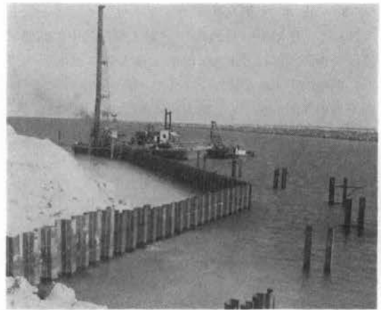
写真-2 鋼矢板締切状況
