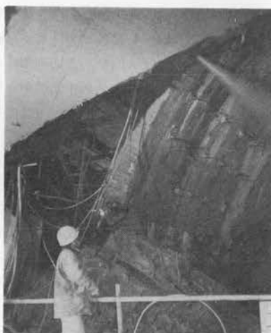
写真-5 切断後の状況
