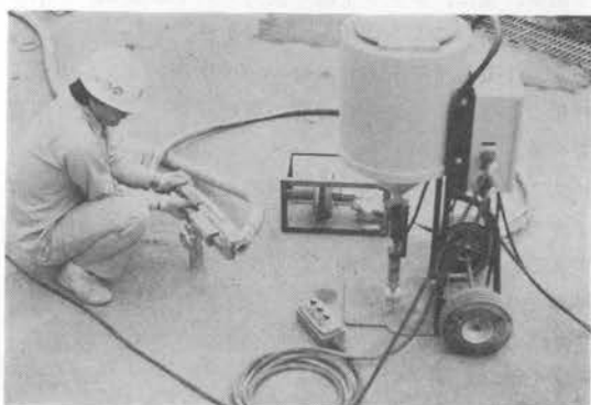
写真-1 アブレイシブジェット装置
