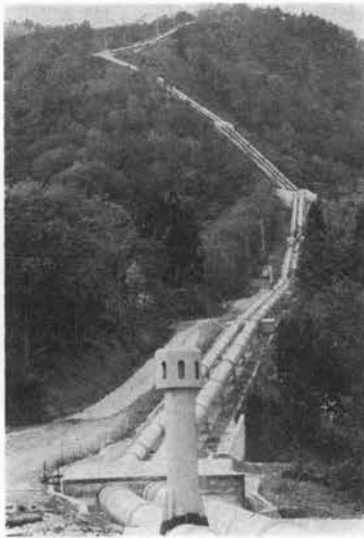
写真—5 明り部鉄管路
