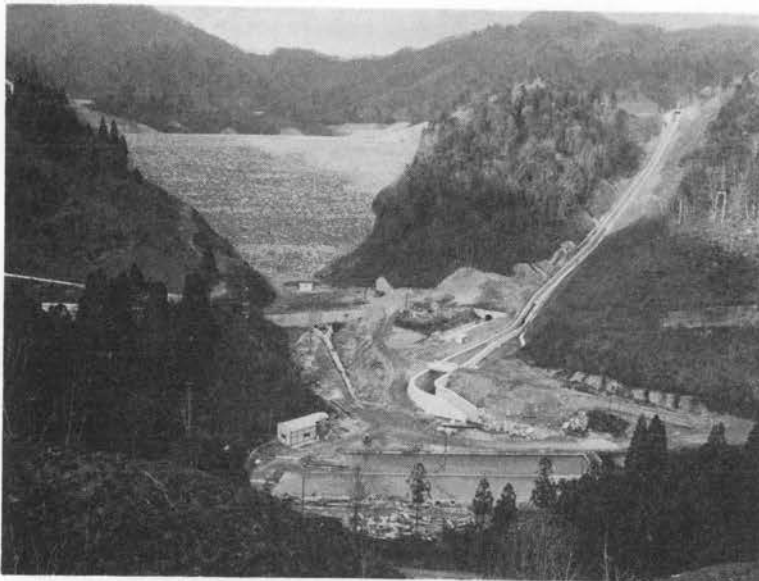
写真-1 土用ダム工事状況を下流側から望む
