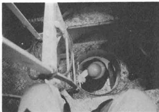
写真—1 高圧の潜函工事現場に降りて行くための加減圧室から見たらせん階段
