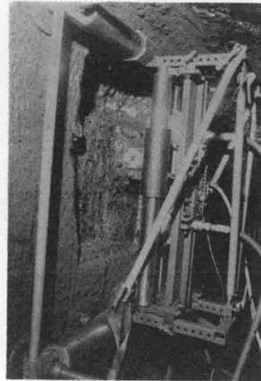
写真—1 原位置における測定状況
