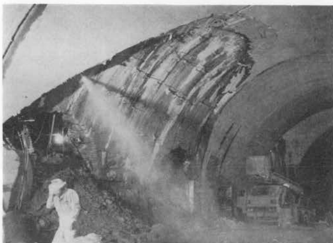
写真-4 コンクリート壁の切断作業
