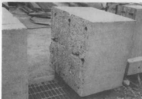
写真-3 鉄筋コンクリート柱の切断
