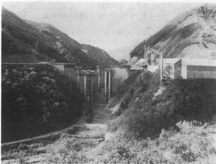
写真-2 俣野川ダム工事状況を上流側から望む
