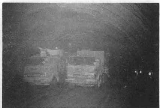
写真-1(C) 坑内におけるコンクリートモービルの設置状況
