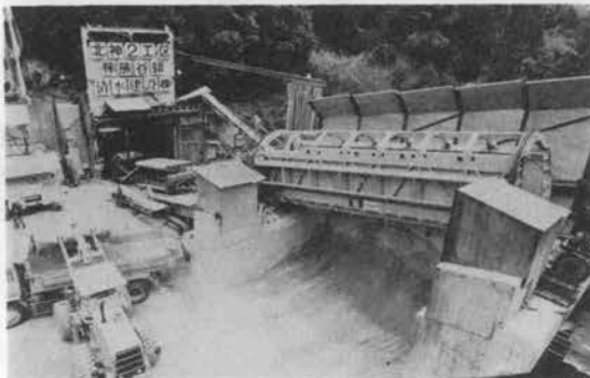
写真-3 第2工区斜坑坑口付近(チップラ15m 3 鋼車用)
