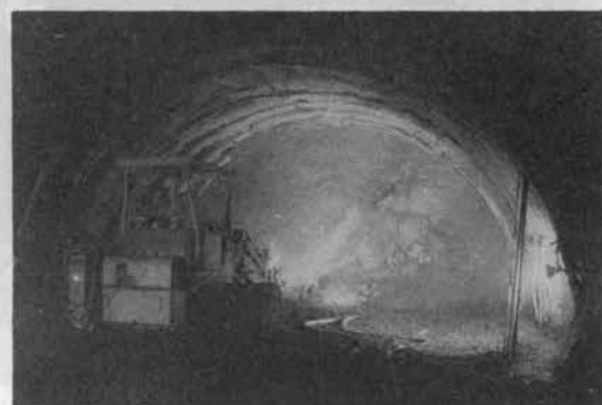
写真-2 坑内での SEC コンクリートの吹付状況
