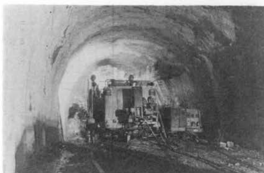
写真-2 第1工区切羽さく孔中(油圧さく岩機2台、5ブーム)
