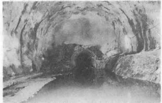
写真-4 第3工区水抜導坑(4k217m地点)
