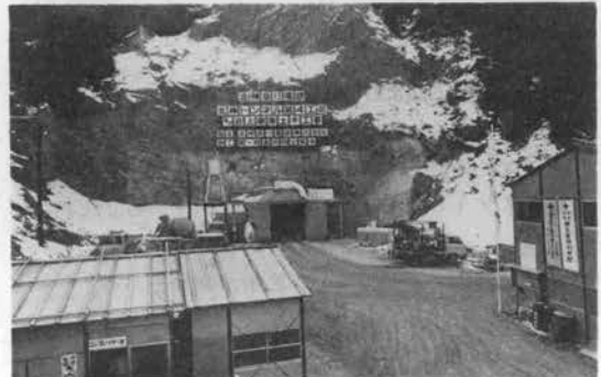
写真-5 第4工区横坑坑口付近(横坑口厚さ30cmコンクリート製防音扉)
